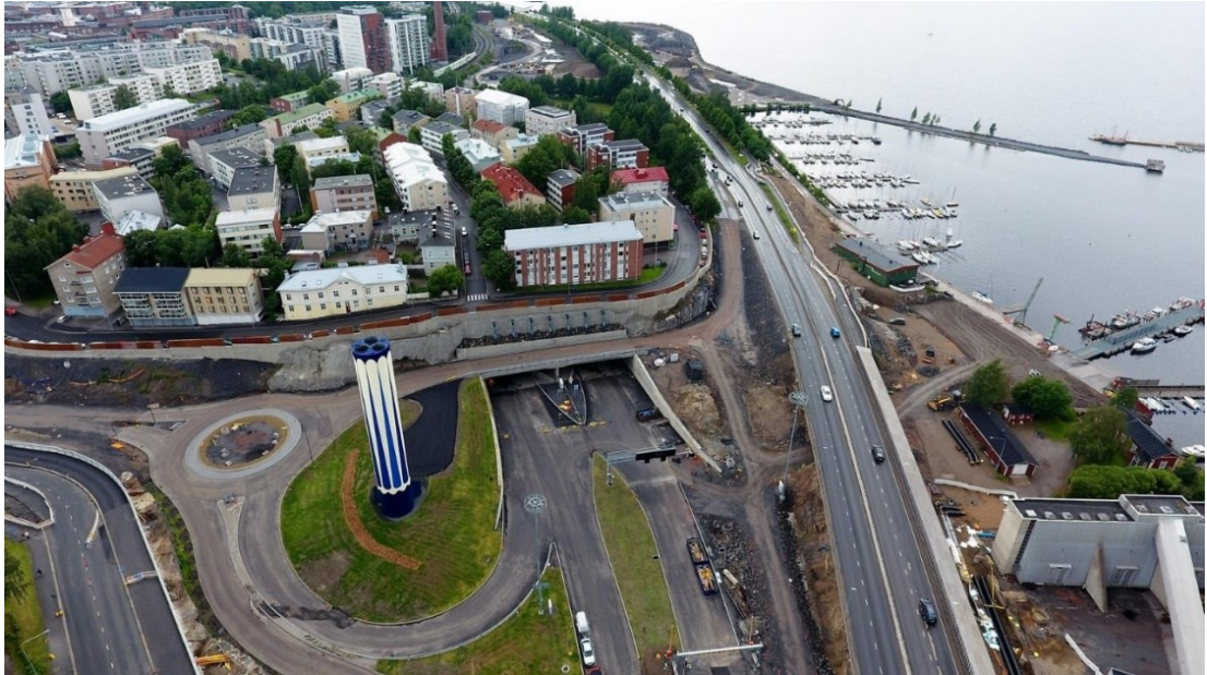
Kuva 3. Valtatie 12 Tampereen rantatunnelin rakennustyömaan ilmakekuva (MTV 2016)
