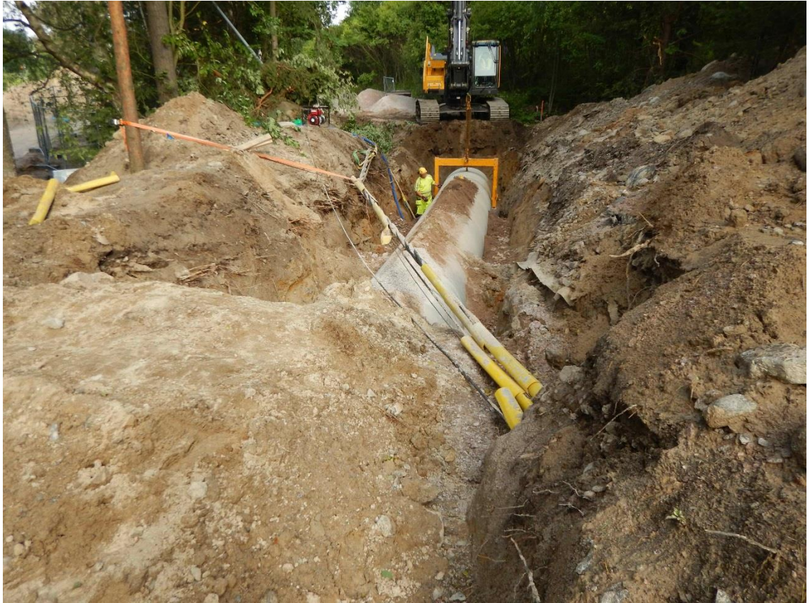
Kuva 7. Virheellinen kaapelinkäsittely.
