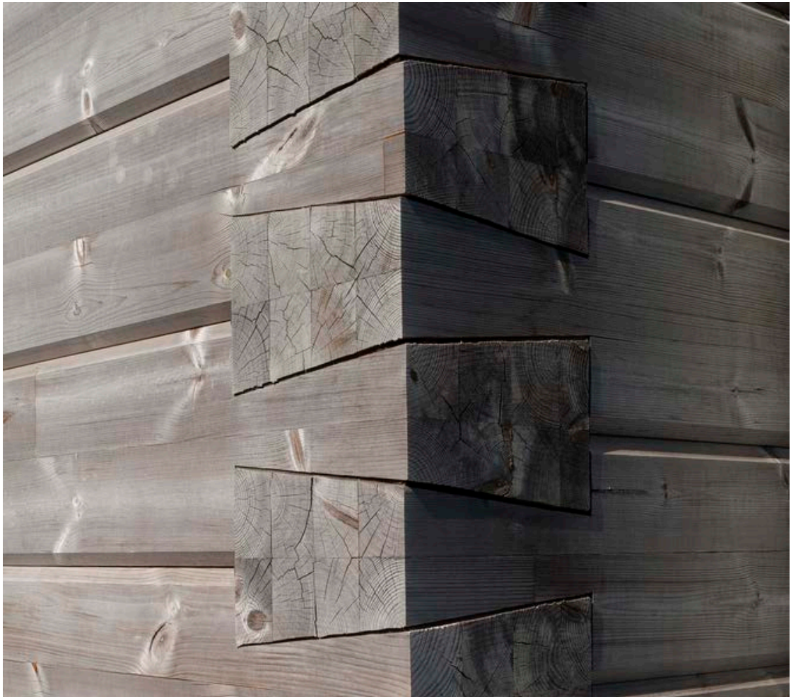
Kuva 50. Lohenpyrstöliitos ja lamellihirsi (Lähde: archdaily.com)
