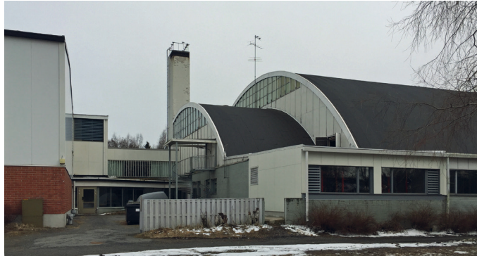
Kuva 84 (vasemmalla). Alkuperäisen kaariosan ja laajennusosien liittymäalue. Vasemmassa reunassa punatiilinen laajennus 1985, kuvan etualalla kuntosalilaa- jennus ja sisäpihalla poistumistieportaat ja yh- dyskäytävä. Näkymä on levoton ja yleisilmeel- tään heikkokuntoinen.
