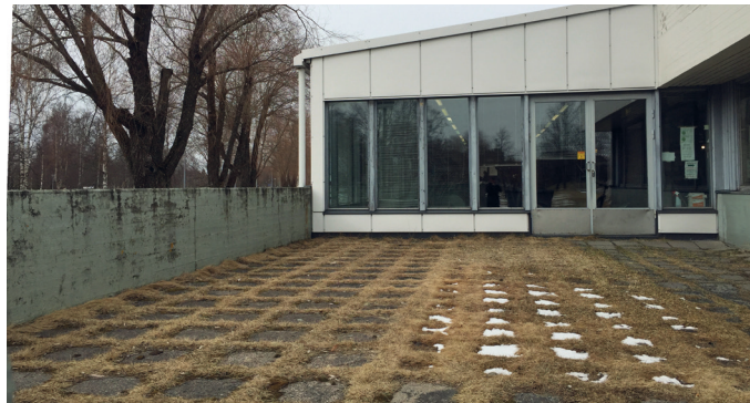
Kuva 86 (vasemmalla). Kaariosan alkuperäisen kahvilatilan ulkoterrassin eteläpäätty. Joenvarsiterassin paikalle on raken- nettu kuntosalin laajennus. Kuntosalilaa- jennus työntyy harmonisesta ja symmetrisestä kaari- osan massasta ulos yksikerroksisena kappalee- na ja rikkoo kaunista ensimmäisen kerroksen sisäänvetoa, joka muuten on säilynyt rakennuk- sen etelä- ja itäisivuilla alkuperäisenä.
