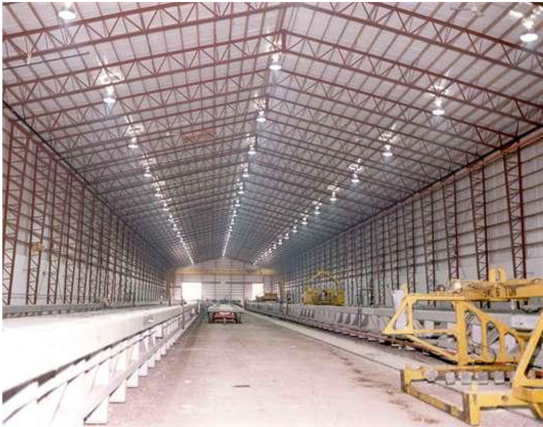
Kuva 3.1 Ristikkopilarista ja kattoristikosta muodostuva kehärakenne. [24]
