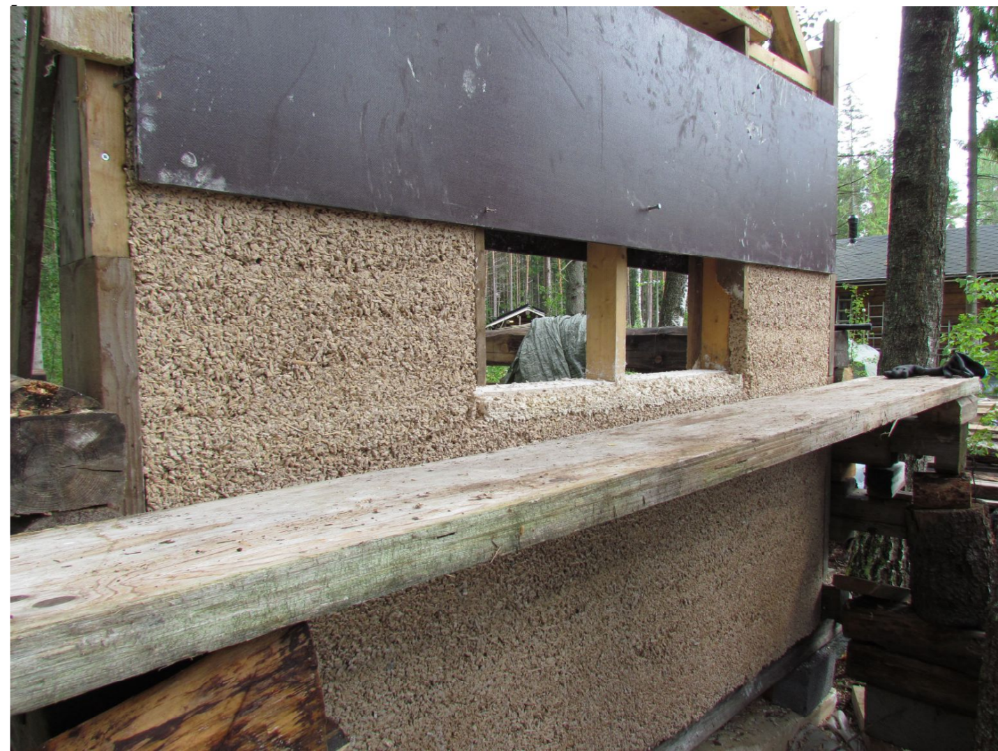
Hamppubetonin ja hirsirakentamisen yhdistämistä Turun Kaks Kerrassa vuonna 2015: rakennusvaihe
