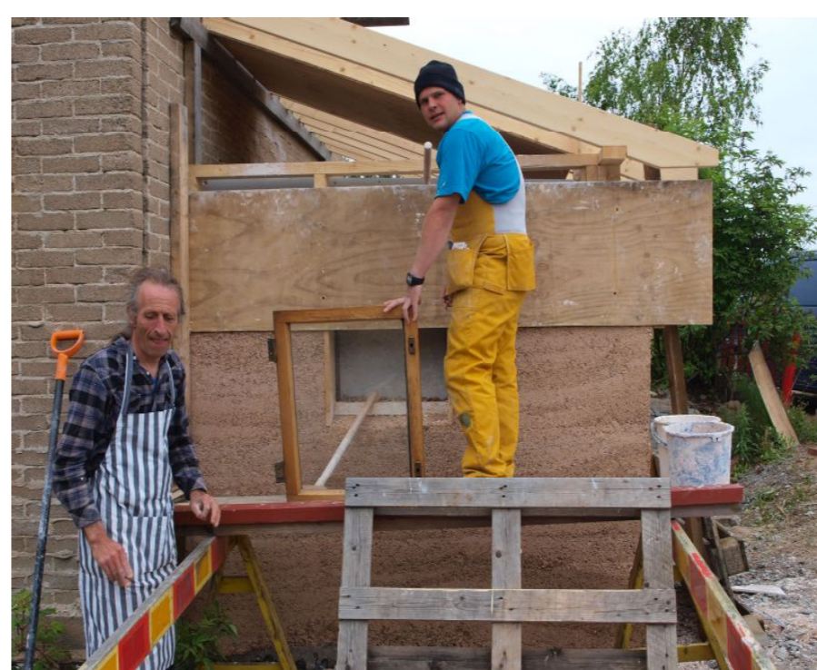
Hamppubetonin koerakentamista Steve Allinin ohjaamana Turussa 2015
