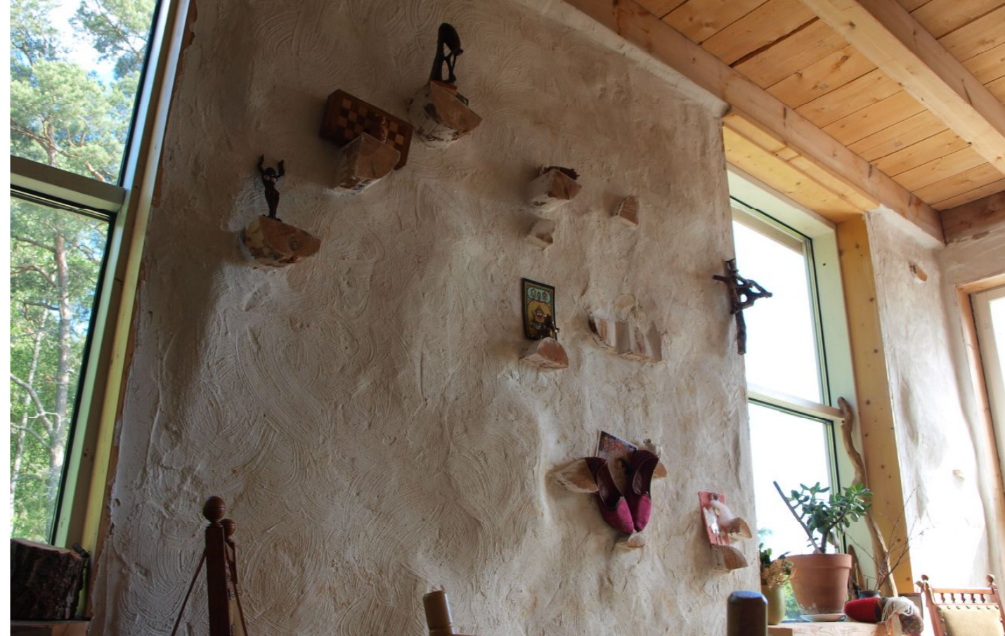
Savea, kalkkia, hiekkaa, kutterilastua ja puupölkkyjä hyödyntävä seinärakenne: Elävä pinta ja luonnolliset rakennusaineet luovat asumiseen mukavuutta ja tunnelmaa
