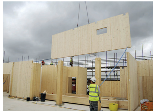
KUVA 59. Massiivipuulementtejä on onnistuneesti purettu uudelleen käyttöön hallirakennuksissa. (Kauppinen, 2016)
