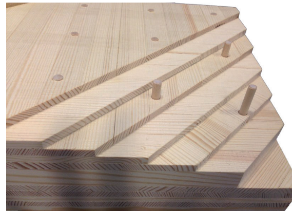
KUVA 57. Nur-Holz- elementeissä puulevyt on kiinnitetty toisiinsa pyökkitapein. (Yle Uutiset, 2015)
