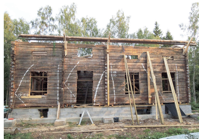
KUVA 60. Vanhat hirsirakennukset on suunniteltu purettaviksi ja siirrettäviksi. (Trifile Oy, 2016)
