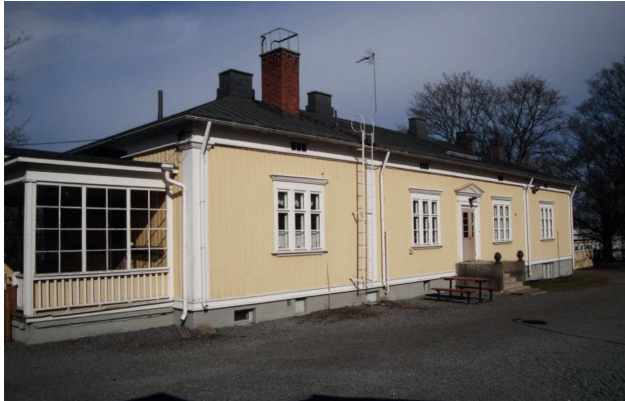
KUVA 34. Kuva vasemmalla ja yllä: Päiväkotirakennus on säilynyt muuttumattomana ja hyväkuntoisena lähes sadan vuoden ajan asiantuntevan huollon, sekä ylläpidettävien rakenteiden ansiosta.
