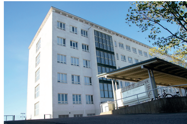
KUVA 4. Aleksis Kiven koulussa ilmeni sisäilmaongelmia vuonna 2016. Vuonna 1933 valmistuneeseen kouluun on tehty vuosien varrella useita teknisiä päivityksiä. Nyt rakennuksessa korjataan kosteusongelmia ja vaihdetaan koko huonokuntoinen talotekniikka. (Kuntalehti, 2017)
