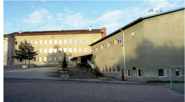
KUVA 5. Kuva 5 : Pohjois-Haagan ala-aste on rakennettu vuonna 1955. Rakennus on täystiilinen ja toimii edelleen painovoimaisella ilmanvaihdolla. (Arkkitehtuurikierrös, 2017)
