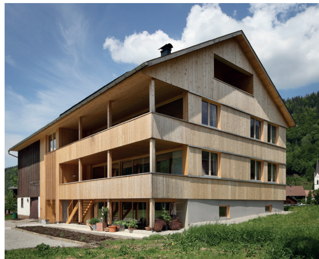
KUVA 32. Esimerkki modernista itävaltalaisesta puurakentamisesta. (Kauffmann, 2017)
