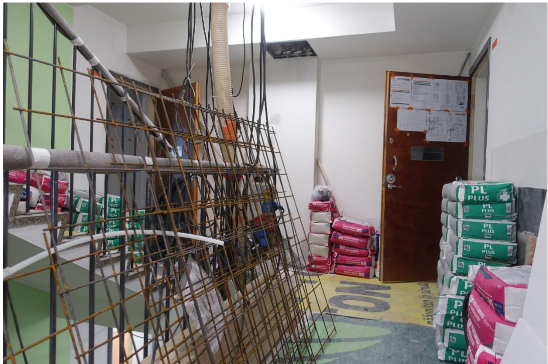
Kuva 8. Porraskäytävä oli tavallista suurempi ja siinä varastoitiin toisen erän mukana tulleet rappauslaastit ja lattiamassat. (kuva: Fira Palvelut Oy)
