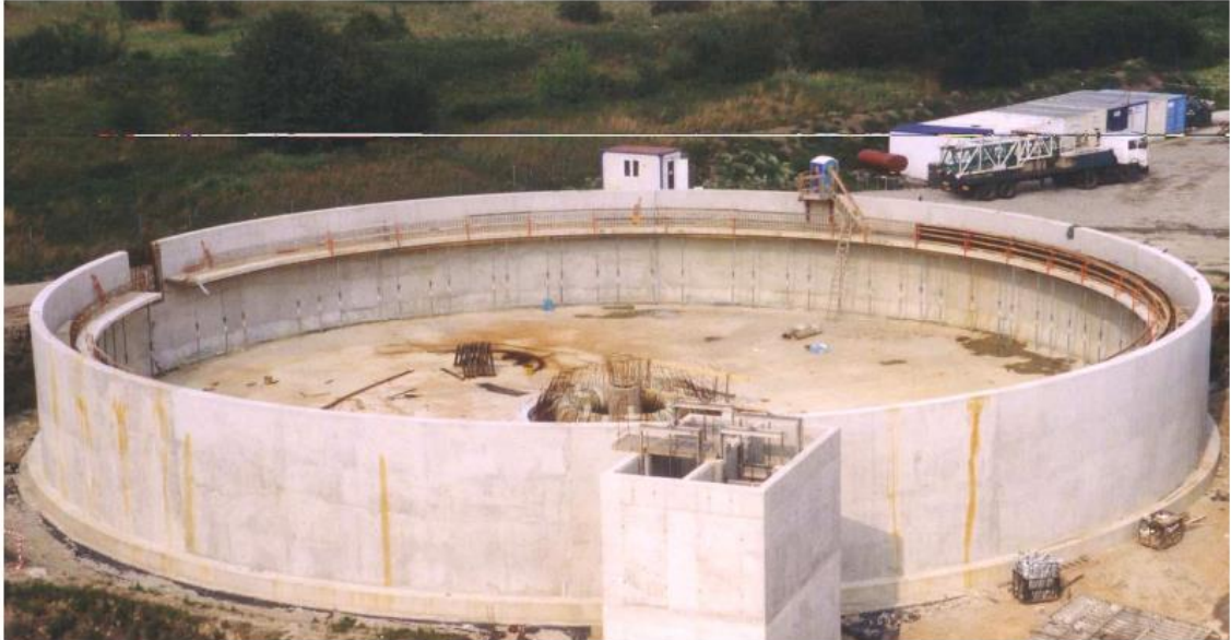
Kuva 73 Sylinterin muotoinen, teräsbetoninen säiliörakenne.
