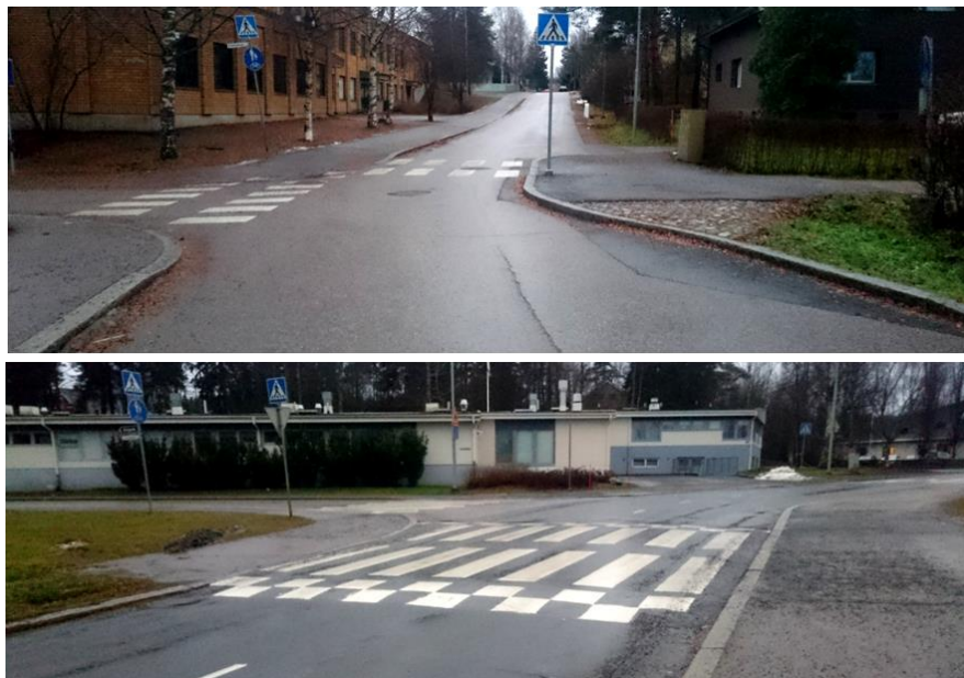
Kuva 24. Hidasteiden käyttö koulun läheisyydessä. Ylempänä koululle johtavalla tiellä sijaitseva 1-puolinen pistemäinen kavennus ja alempana korotettu suojatie.
