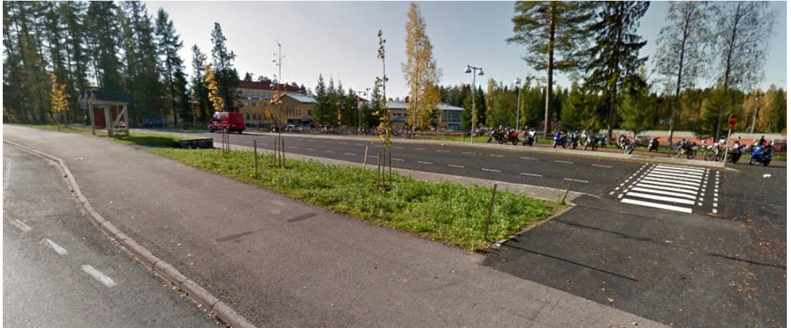
Kuva 43. Saattoliikenteelle ja koulukuljetuksille tarkoitettu jättöpaikka, jolle on mahdollista kääntyä viereisen ajoväylän molemmista suunnista. (Google 2016)
