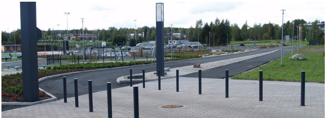
Kuva 37. Huolto- ja pelastusajolle varattu ajoreitti, jonka oikealla puolella kulkee jalankulun ja pyöräilyn väylä (ylempi kuva) ja jonka risteäminen jalankulun ja pyöräilyn kanssa on toteutettu pollareiden ja Stop-merkin avulla (alempi kuva).
