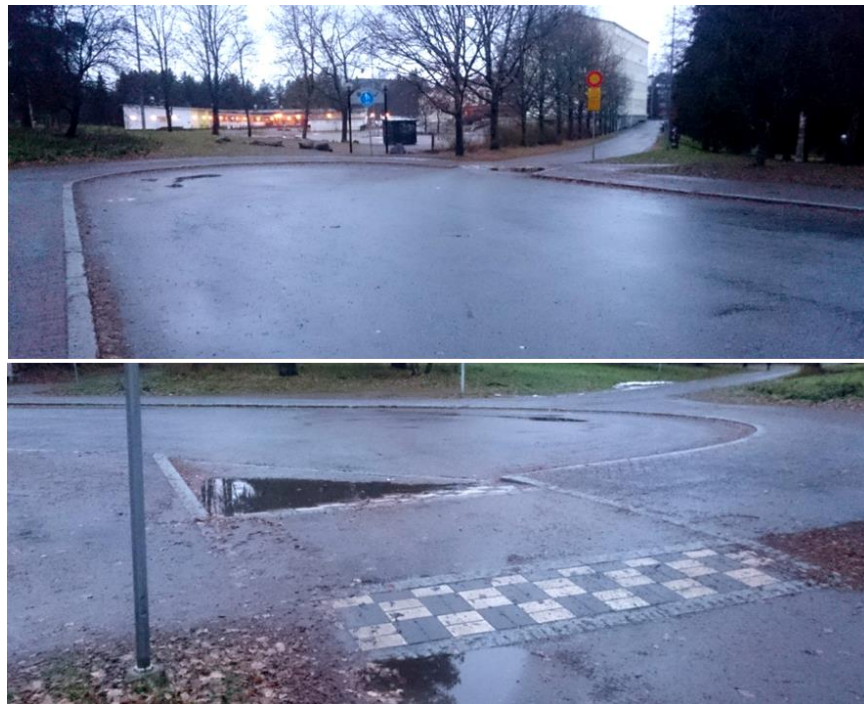
Kuva 39. Saattoliikenteen jättöpaikka, josta on ajoyhteys koulun pihaan. Jalankulku- ja pyöräilyväylä on korotettu ajoyhteyden kohdalla. Korotetun kohdan kiviä tulee kiinnittää erityistä huomiota.
