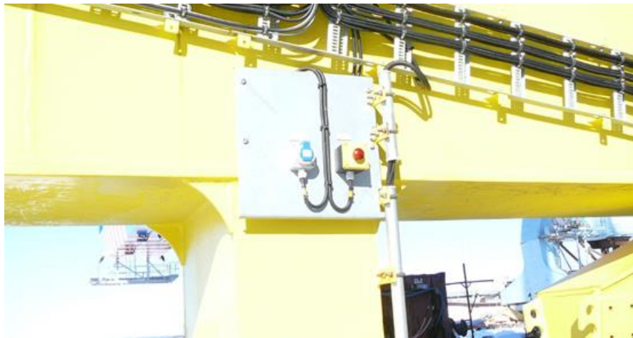
Kuva 44. Asiakasvaatimuksena tuleva hätästop-painike ja pistorasia.
