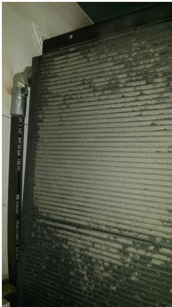
Kuva 5.2 Liasta tukkeutunut HK1:n jäähdytyskierron öljynjäähdytin
