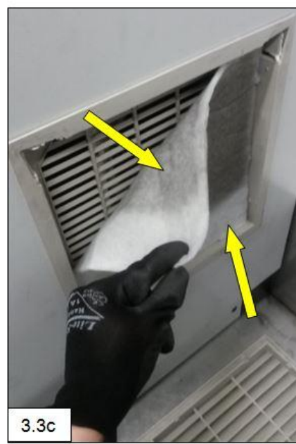
Kuva 6.5 Ilmansuodattimien tarkastusta tukevat kuvat ja huomiot liittyen kuviin
