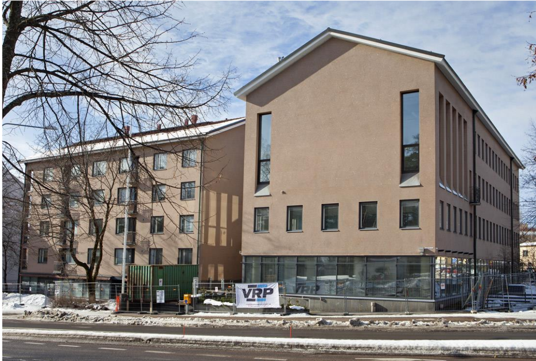
Kuva 5.6 Case-kohde, kuva otettu talvella 2016 (VRP Rakennuspalvelut Oy 2016)
