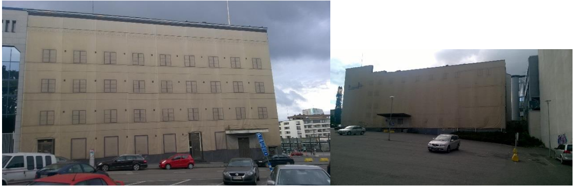
Kuva 7.1 Vasemmalla Valtiontalon julkisivu Kilpisenkadulta päin katsottuna ja oikealla näkymä Vapaudenkadulta päin. Oikean puoleisessa kuvassa näkyy rakentamaton alue.
