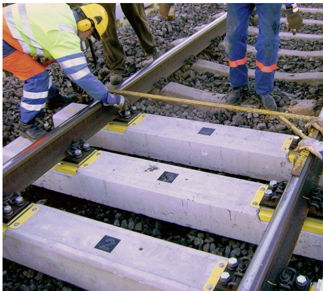
Kuva 32. Schenkin Multirail Interscan on integroitu ratapölkkyihin kiskojen alle. [24]
