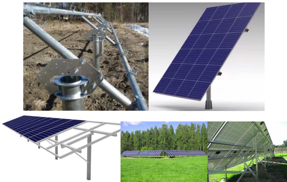
Kuva 21. Esimerkkejä pollariasennuksista maahan (Finnwind Oy, 2015a)
