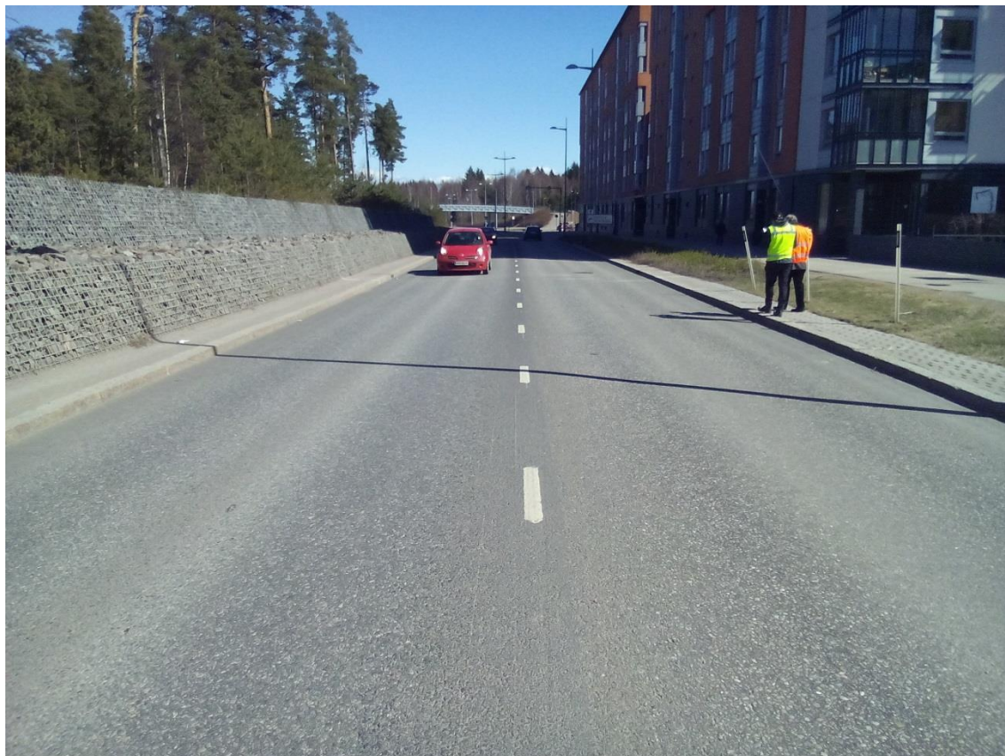
Kuva 18. Vuotien matalalämpöasfalttipäällystettä. Vasemmalla NCC:n tekemä kaista, oikealla Lemminkäisen (kuva P. Hujanen 21.4.2016).
