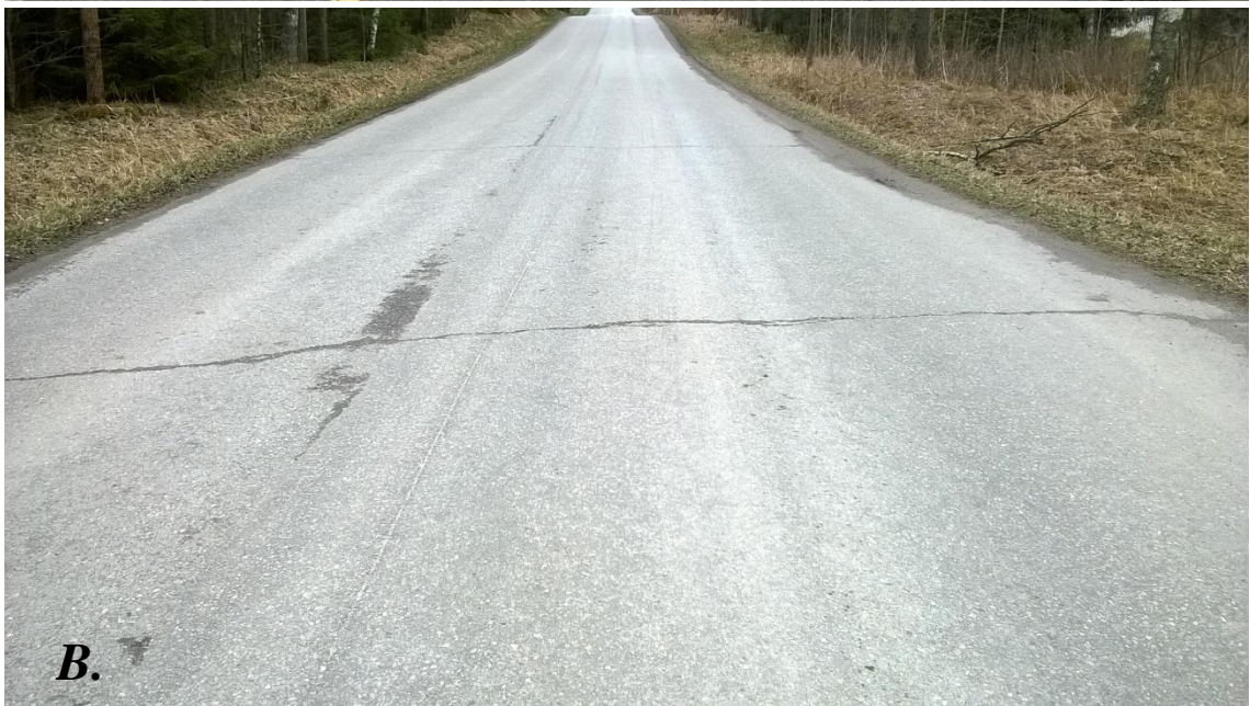
Kuvat 16. A. ja B. Vuonna 2004 tehtyä matalalämpöpäällystettä, Vanha Raumantie, Pori (valokuvat T. Härkälä, 26.4.2016).
