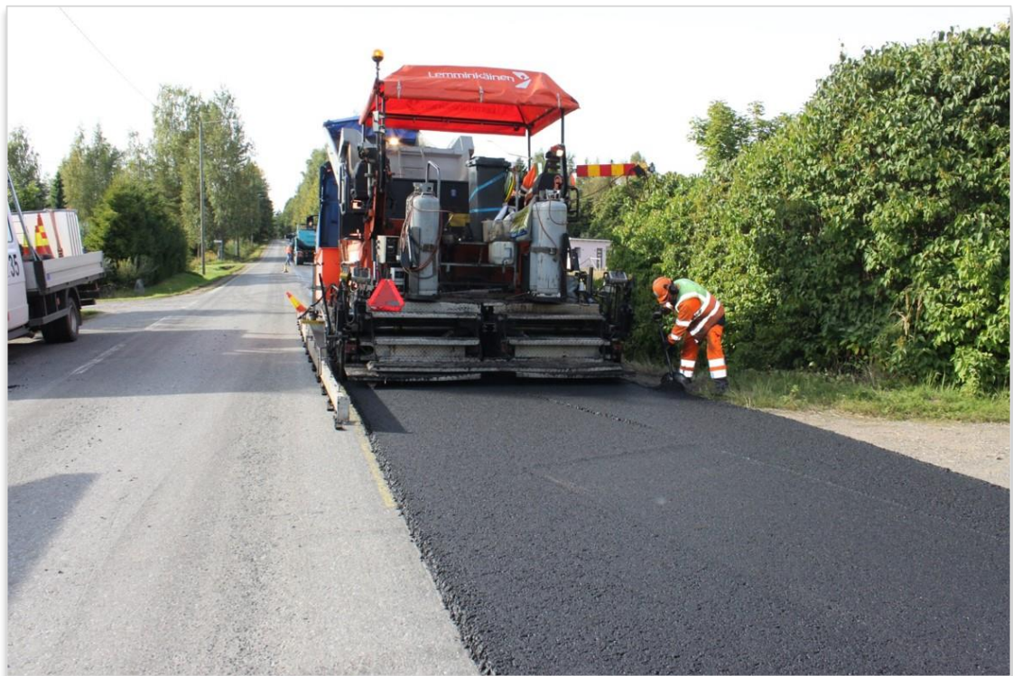
Kuva 22. LTA:n levitystä Urjalassa 9.9.2015 (kuva L. Forstén).
