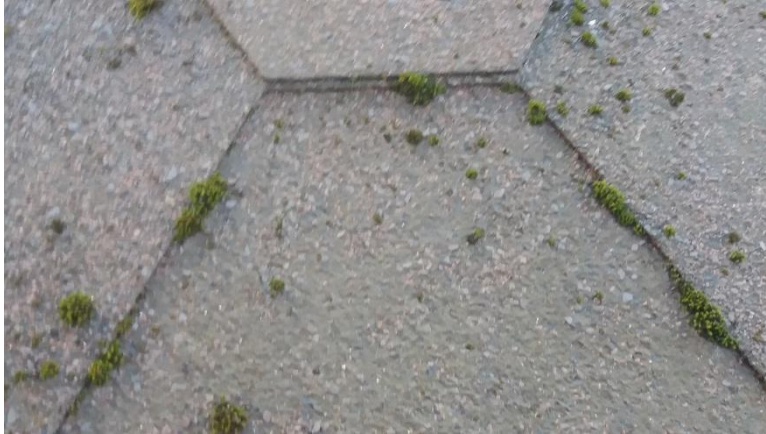
Kuva 13: Sammalta bitumilaattakatolla
