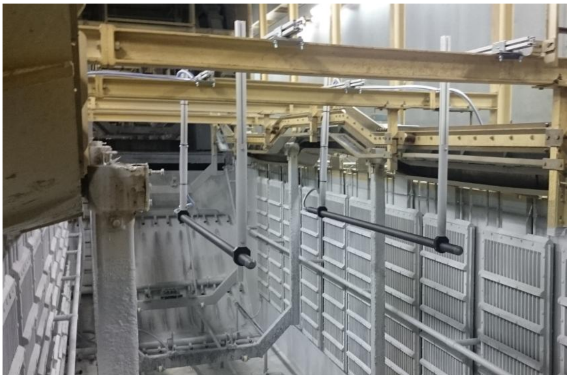
Kuva 21. Asennetut pinta-anodiputket
