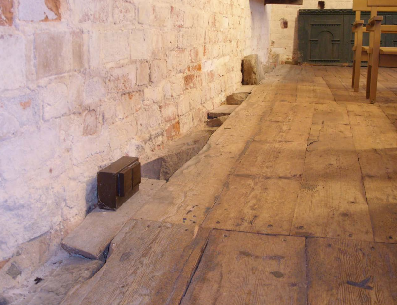
Pistorasian voisi sijoittaa lattialankkujen ja seinän väliseen rakoon.
