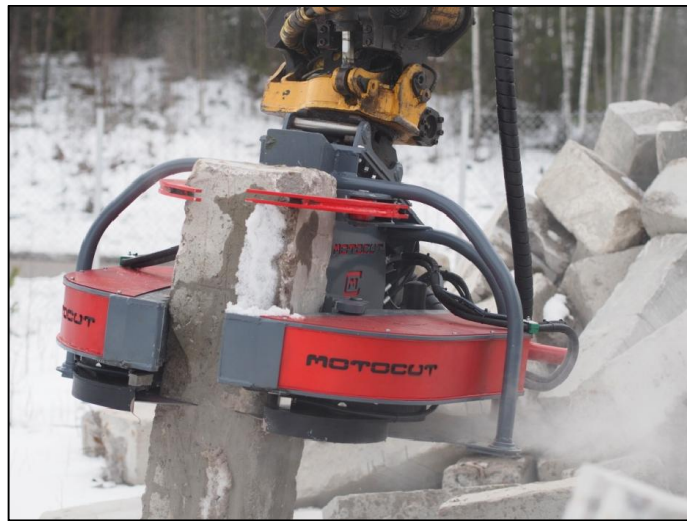
Kuva 12. Motocut-katkaisukoura työssä (MotoCut Oy 2014).
