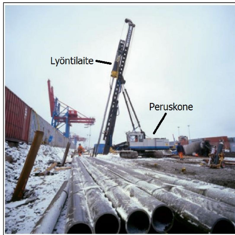
Kuva 2. Paalun asentaminen lyömällä (perustuu lähteeseen Ruukki RR-pienpaalutusohje 2010).
