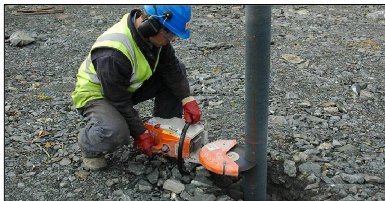
Kuva 10. Pienen teräspuutkipaalun katkaisu kulmahiomakoneella (SEOKANG Piling Ltd. 2015).
