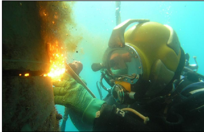
Kuva 11. Sukeltaja katkaisee polttoleikkaamalla teräsputkea (JRS Adriatic Commercial Diving 2013).
