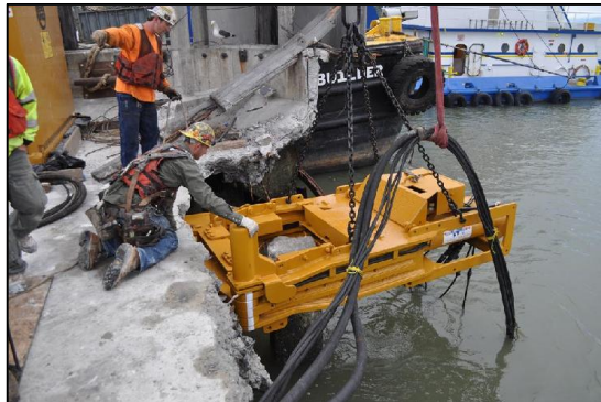
Kuva 15. Prime Pile Cutter model 24:llä suorittu suuren paalun katkaisu (Prime Marine Services INC).
