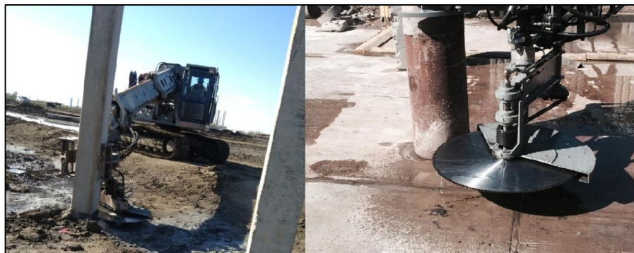
Kuva 14. Aggregate Technologies:n valmistama PCM katkaisemassa tb-paalia (vasemmalla) ja teräsputkipaalia (oikealla) (perustuu lähteeseen Aggregate Technologies; Pile Buck Magazine 2014).
