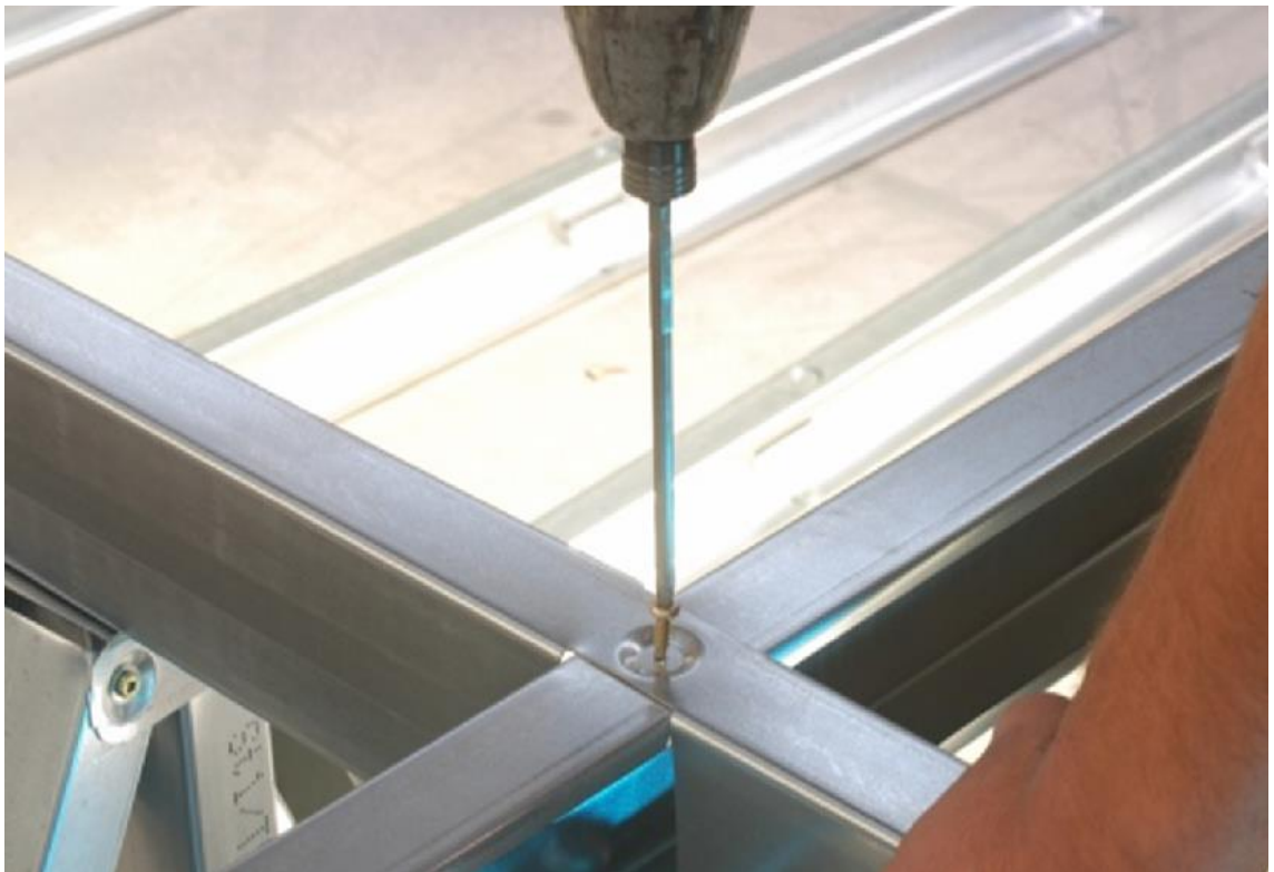
Kuva 18. CFS-ruuviliitoksen muotoilu. [ http://www.netgreendevelopments.com ]
