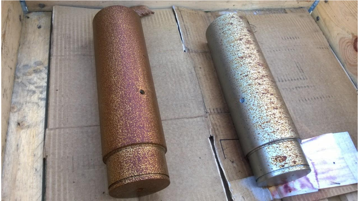
Kuva 6.19. Akseleiden ulkonäkö viimeisenä testipäivänä, vasemmalla suojaamaton akseli.
