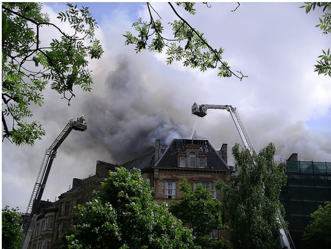
Kuva 3.10 Tulipalo on aina uhka infrastruktuurille ja itse tulipaloa havainnoiville järjestelmillekin. Kuvassa on Glasgown yliopiston rakennus Maclay Hall, joka kärsi pahoja vahinkoja tulipalossa 13.6.2006. Lähde WikimediaCommons [57]
