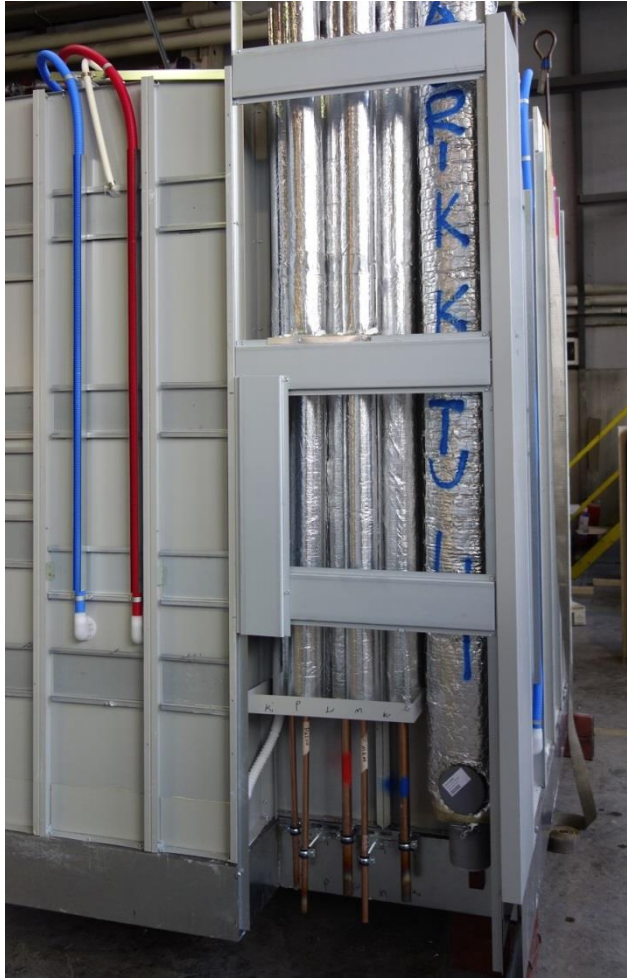
Kuva 3.6. Kylpyhuone-elementtiin integroitu tekniikkahormi ja valmiiksi asennettu talotekniikka. Työmaalla pystylinjat liitetään yhdeksi koko rakennuksen läpikulkevaksi hormiksi. Välipohjat betonoidaan asuntojen välisten ääni- ja palomääräysten mukaisesti.
