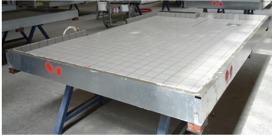
Kuva 3.4. Pohjalaatta valmiina seinäelementtien asennusta varten. Pohjalaattaan toteutettu vesieriste, laatoitus ja lattiakallistukset.
