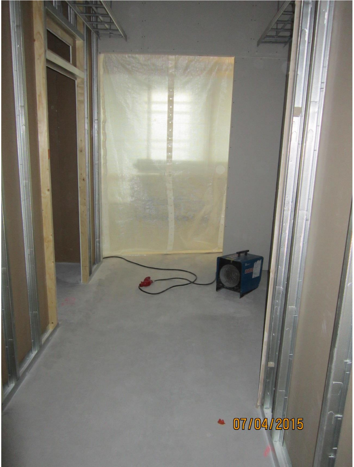
Kuva 39. C-talo, 5.krs, case 3 alueen lämpötilaa nostettu eristämällä alue muoveilla ja sähkölämmittimellä (Lemminkäisen Ilmalanrinne 1 työmaa).
