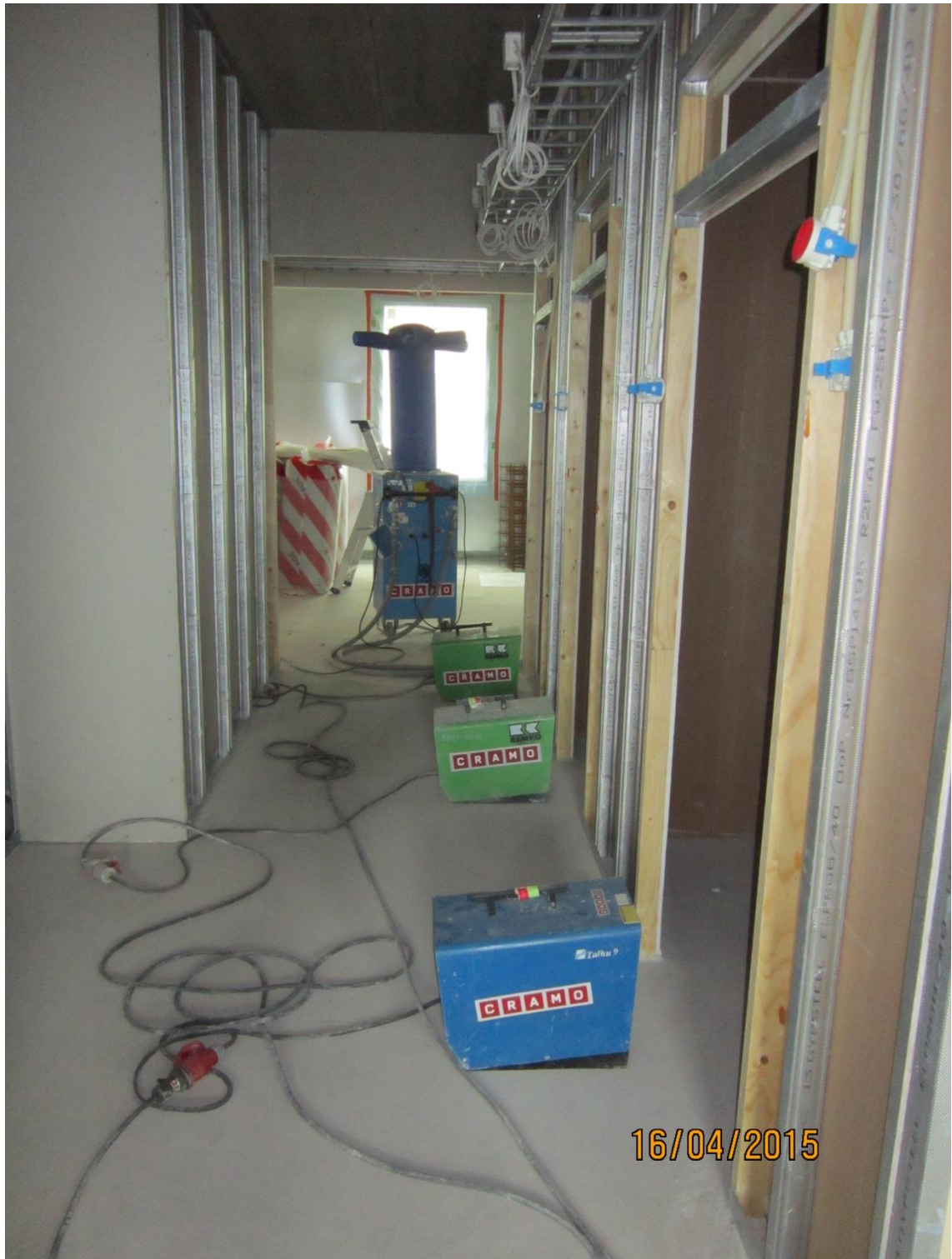
Kuva 35. C-talo, 3.krs, case 1 alueen wc-tiloihin kohdistettu sähköpuhaltimet nopeuttamaan kuivumista (Lemminkäisen Ilmalanrinne 1 työmaa).
