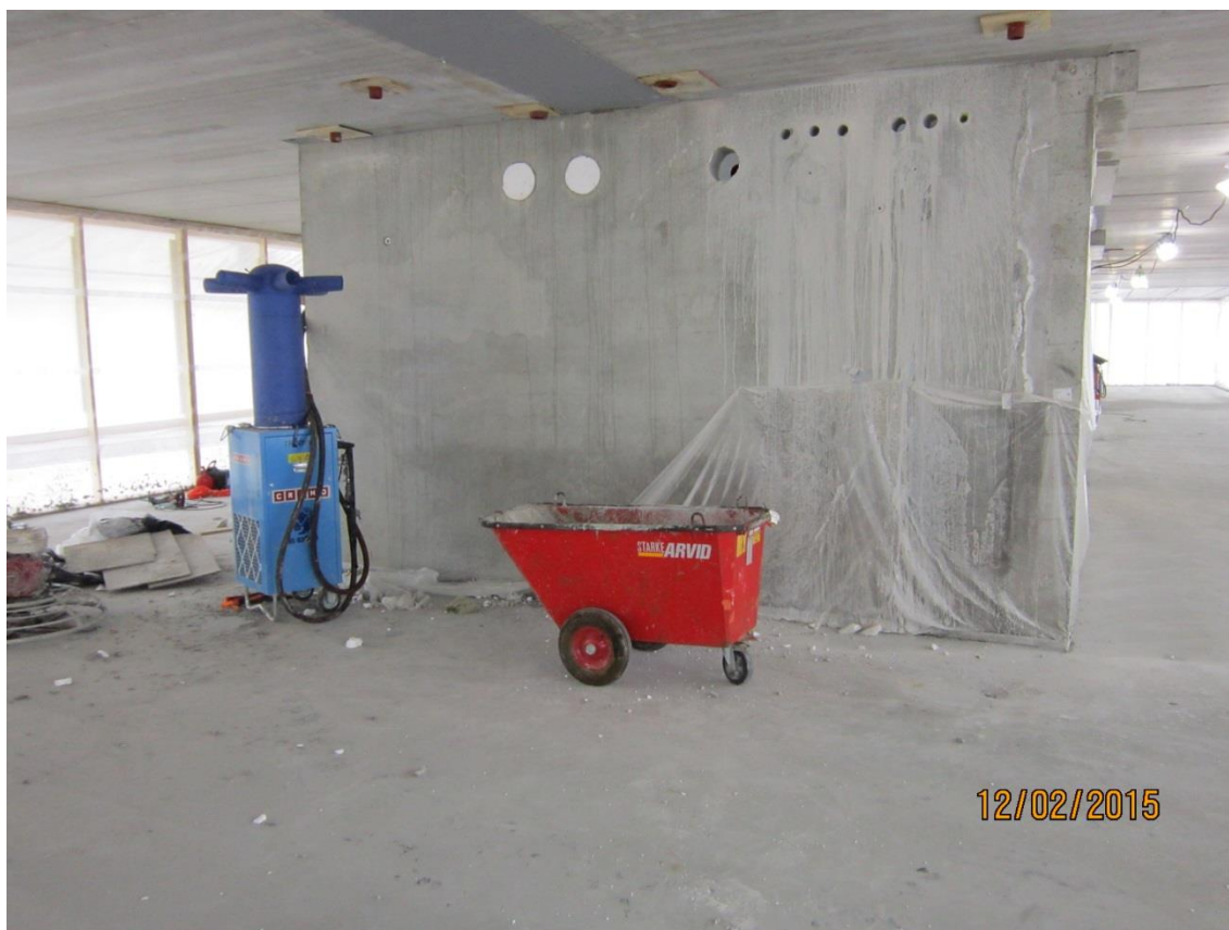
Kuva 32. Case 3 kolme päivää valun jälkeen (Ilmalanrinne 1, C-talo, 5.krs, eteläpuoli).
