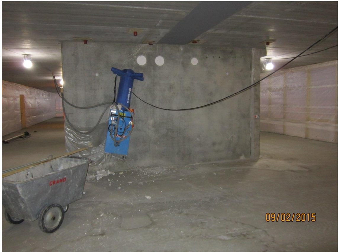
Kuva 30. Case 2 neljä päivää valun jälkeen (Ilmalanrinne 1, C-talo, 4.krs, eteläpuoli).
