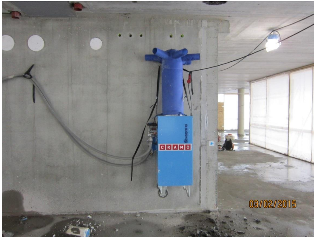
Kuva 8. Kaukolämpöverkossa oleva lämpöpuhallin (Lemminkäisen Ilmalanrinne 1 työmaa 3.2.2015).
