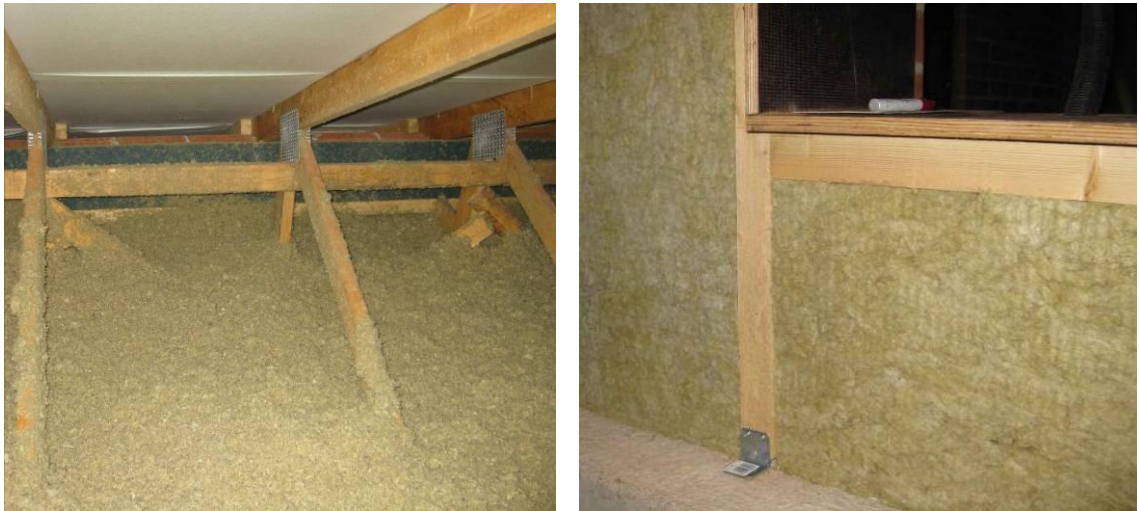
Kuva 5.14. Passiivitaloksi rakennetun omakotitalon yläpohjan lämmöneristys on tehty 700 mm kerroksella puhallusvillaa. Ulkoseinän lämmöneristyksessä on kaksi 150 mm kivivillalevyä päällekkäin sekä 30 mm tuulensuojalevy. (Passiivitalo 2010.)
