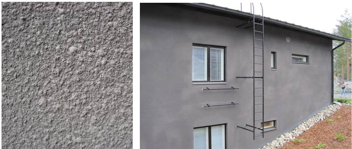
Kuva 5.40. Tummansävyisen kolmikerrosrappauksen lämpöliikkeet on huomioitu asentamalla täyttörappauksen väliin rappausverkko.
