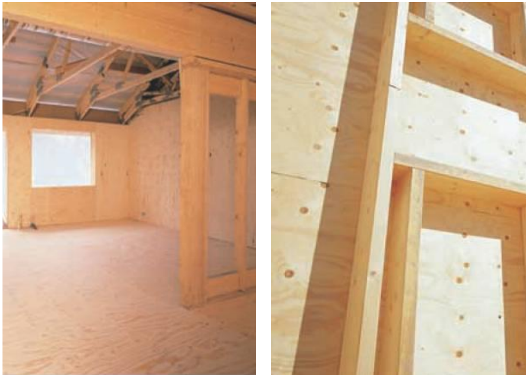
Kuva 5.35. Vaneria käytetään sisätiloissa seinä-, lattia- ja kattoverhouksissa tai verhouksen aluslevynä. (UPM Metsäteollisuus r.y. 2006.)
