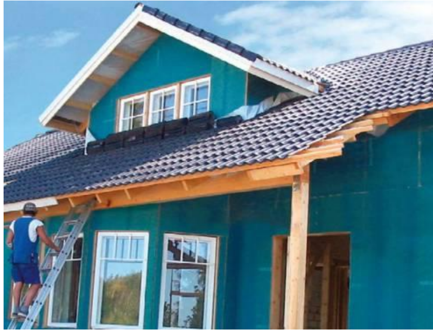
Kuva 5.12. Huokoinen puukuitutuulensuojalevy voi toimia rakennuksen väliaikaisena suojana, mutta rakennusta ei saa jättää talvehtimaan pelkän tuulensuojalevyn varaan. (RT 37721 2009.)
