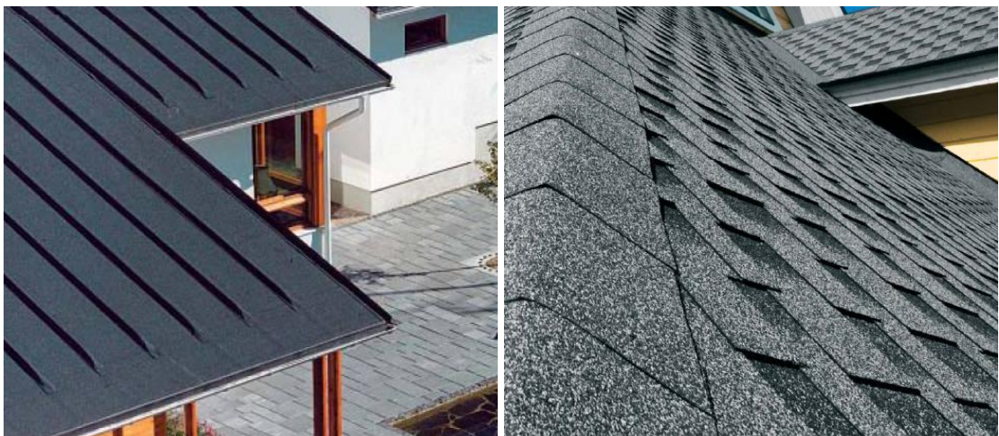
Kuva 5.1. Kolmiorimakate ja kermikatelevyistä tehty katto. (Lemminkäinen 2010.)
