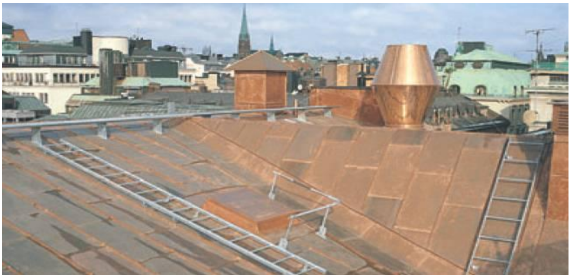
Kuva 5.4. Kuparikatteita on käytetty varsinkin hieman vanhemmassa rakennuskannassa. (Rautaruukki Oyj 2010.)
