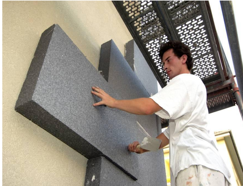
Kuva 5.20. Seinään asennettavan, grafiittia sisältävän EPS-eristelevyn vesihöyrynläpäisevyys \delta_p on 5,9 (\pm 1) \cdot 10^{-12} \text{ kg/(m}\cdot\text{s}\cdot\text{Pa)} . Kuvassa tehdään rakennuksen ulkopuolista lisälämmöneristystä. (Fischer 2008; VTT-C-3712-09 2009.)
