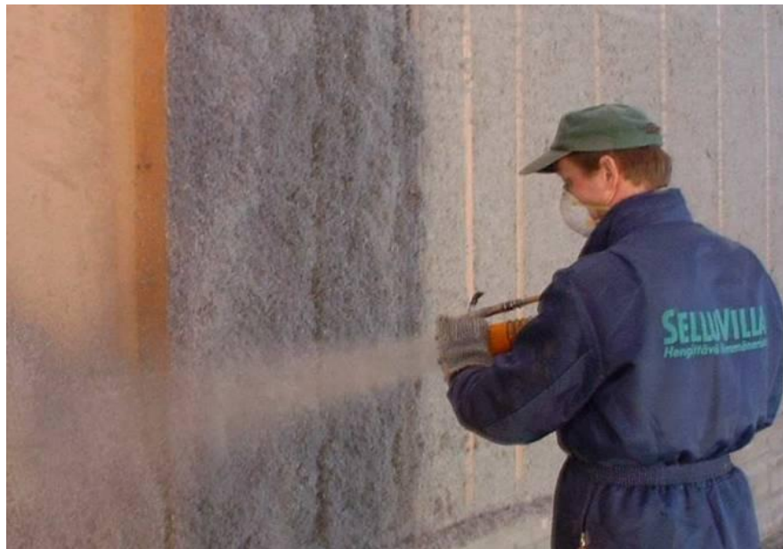
Kuva 5.16. Kuivaruiskuttamisen etuna on, että eriste liimaantuu rakenteisiin täyttäen ja tiivistäen raot ja kolot. Ylimääräisen kosteuden on haihduttava pois eristemassasta ennen rakenteen sulkemista. (Suomen Selluvilla-Eriste Oy 2006.)
