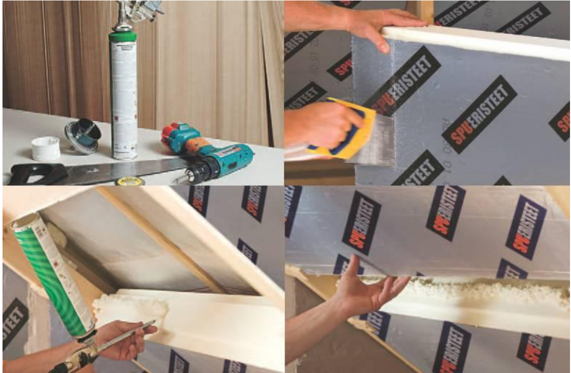
Kuva 5.21. Alumiinilaminaatilla päällystetyn polyuretaanieristeen saumojen tiiviys varmistetaan saumausaineella ja alumiiniteipillä. (SPU Systems Oy 2010.)
