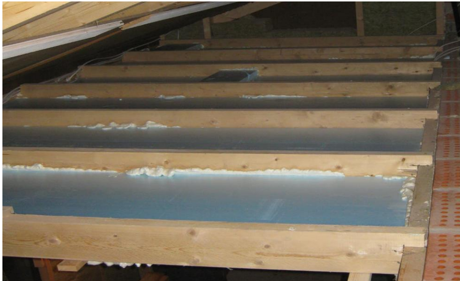
Kuva 5.10. Omakotitalon lämpimän kuistin katon höyrinsulku on tehty polyuretaanilevyillä, joka toimii samalla lämmöneristeenä. Levyjen päälle ja koko yläpohjaan puhalletaan kivivillaeristettä. (Passiivitalo 2010.)
