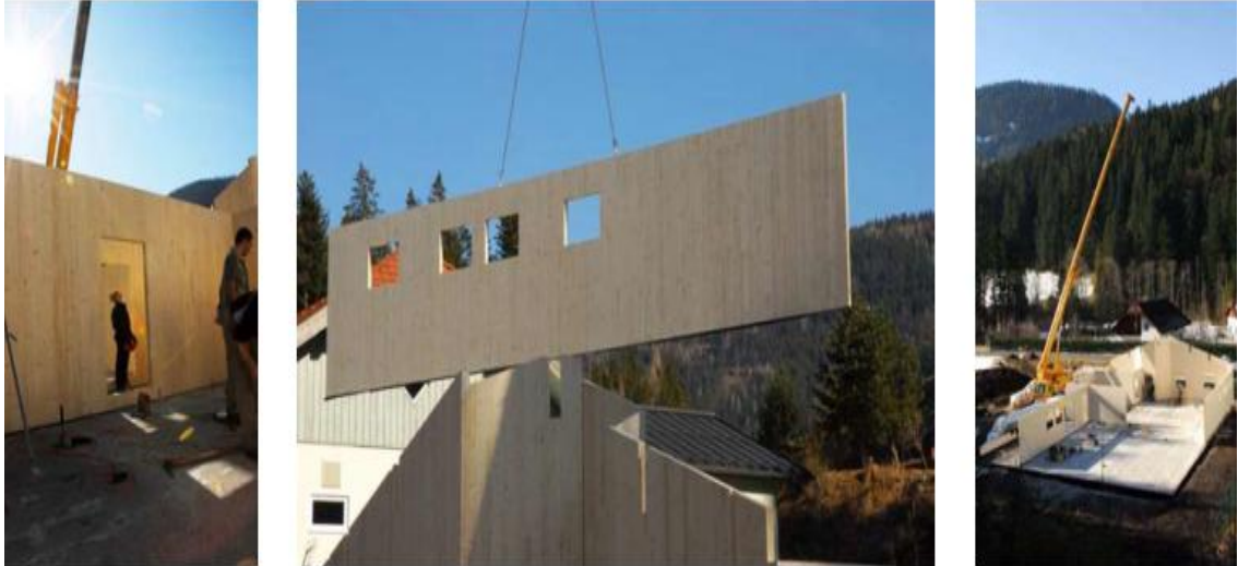
Kuva 5.31. CLT- monikerroslevyelementit ovat puuelementtejä, joita voidaan käyttää sekä omakotitalo- että liiketilarakentamisessa. Kuvassa rakennetaan 100 m 2 leipomoa Salzburgiin, Itävaltaan. (Stora Enso Timber 2010.)
