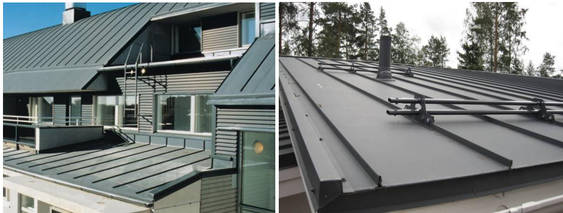
Kuva 5.2. Vasemmalla PVC-muovista valmistettu yksikerroskate ja oikealla peltikatto. PVC-kate saadaan haluttaessa näyttämään peltikatolta profiileilla, jotka asenetaan katteen päälle kuumailmalla hitsaten. (RT N-37634 2008.)
