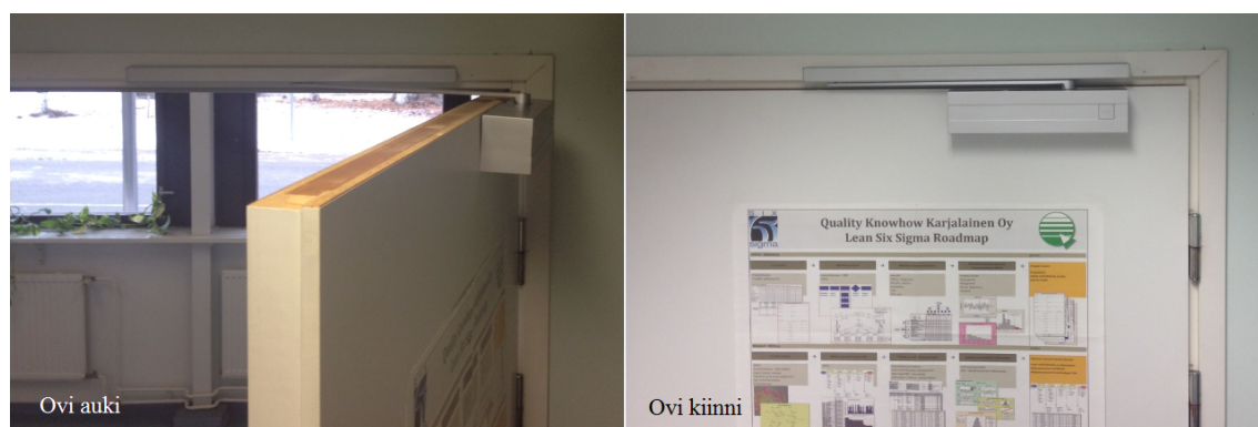
Kuva 2.1. Ovensuljin käyttötarkoituksessaan.
