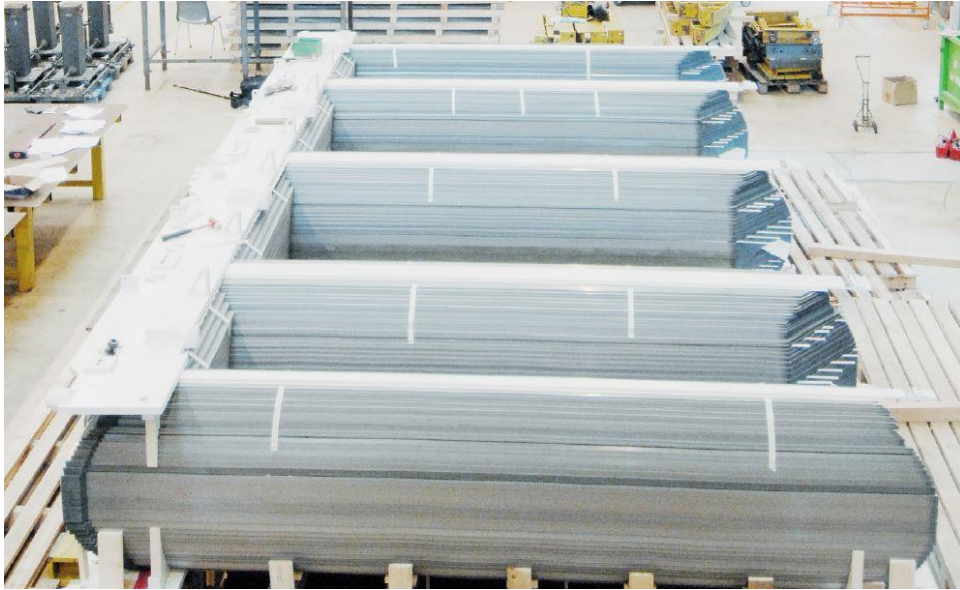
Kuva 10. Vaippamuuntajan rautasydämen kokoonpanoa ABB Oy:n tehtaalla. [12]
