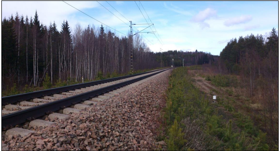
Kuva 5.107. Ylhäällä poikkileikkaus, sekä vanhat inklinometrimitaukset. Uusi putki on oikealla, jossa ei ole merkittäviä siirtymiä. Alhaalla on valokuva kohteesta (Asennuspöytäkirja).
