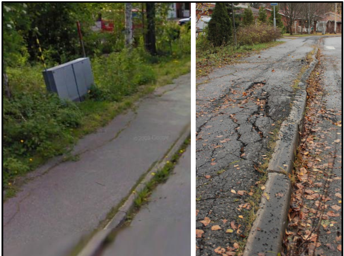
Kuva 59 Sama routinut katuosuus vuosina 2009 ja 2013. (kuvat: maps.google.fi ; Simo Kesti)
