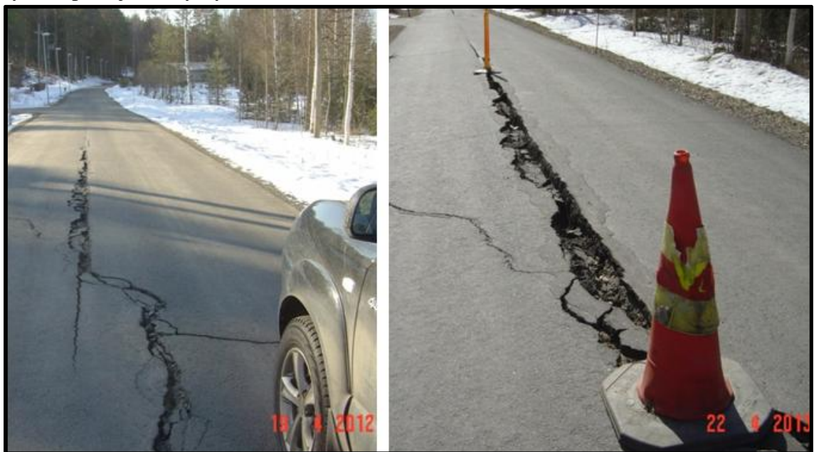
Kuva 34 Sama haljennut katuosuus vuosina 2012 ja 2013. (kuva: Esa Ek)
