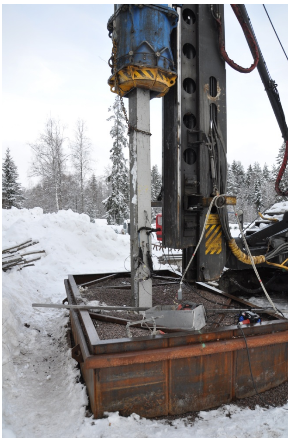
Kuva 3.5 Paalut lyötiin soralla täytetyn teräslaatikon sisään.
