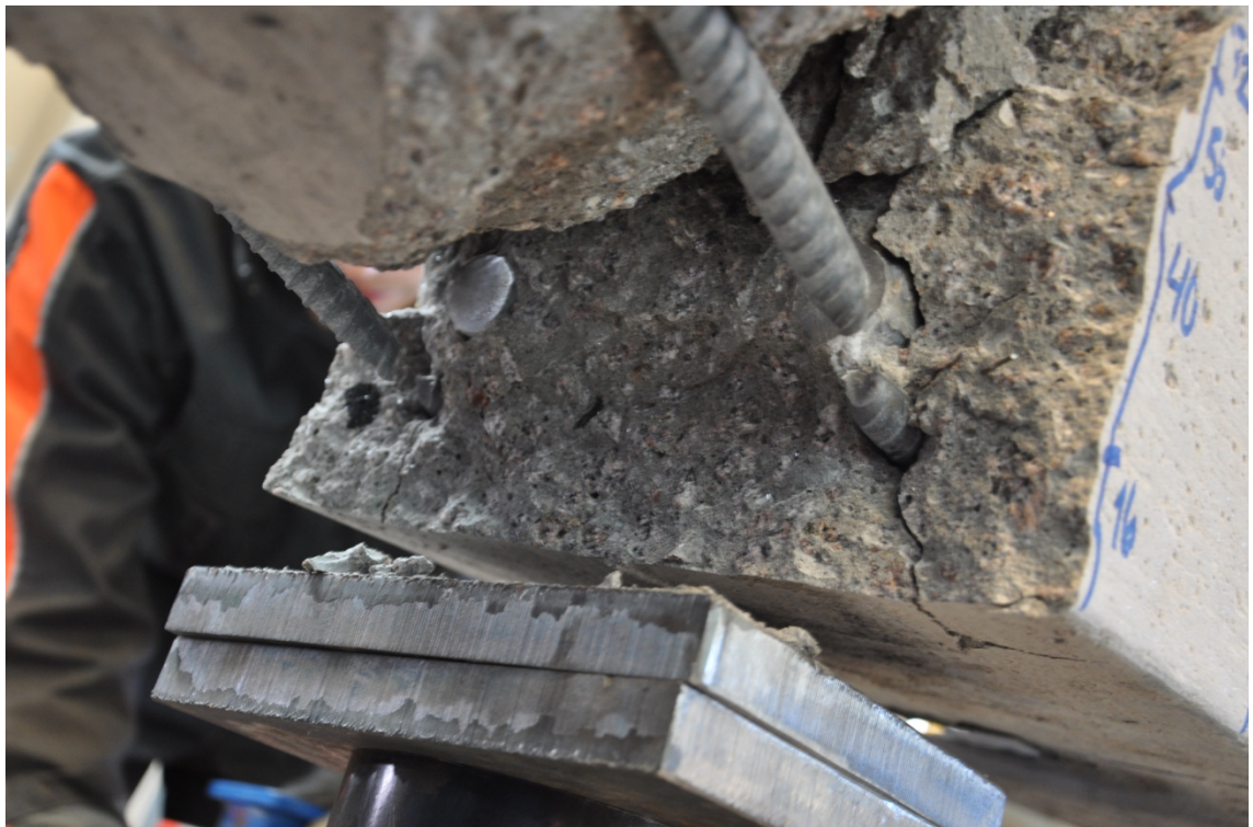
Kuva L2.3 Paalun pääteräkset ovat menneet poikki kalliokärjen ankkurointiterästen loppumiskohdassa.
