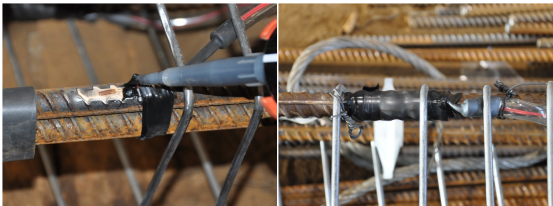
Kuva 3.3 Venymäliuskan liimausta paalun pääteräksiin ja valmis kutistesukalla suojattu venymäliuska.
