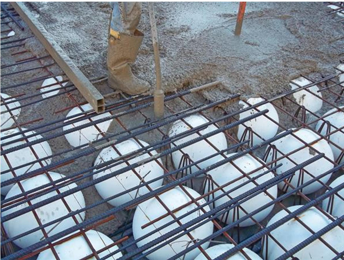
Kuva 3.3. Kuorielementtilaatan valu (Nasvik 2011).
