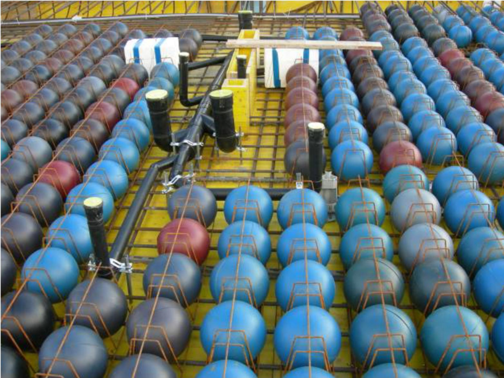
Kuva 5.2. Cobiax-moduulit yhdessä talotekniikan kanssa (Engineering Manual 2010)
