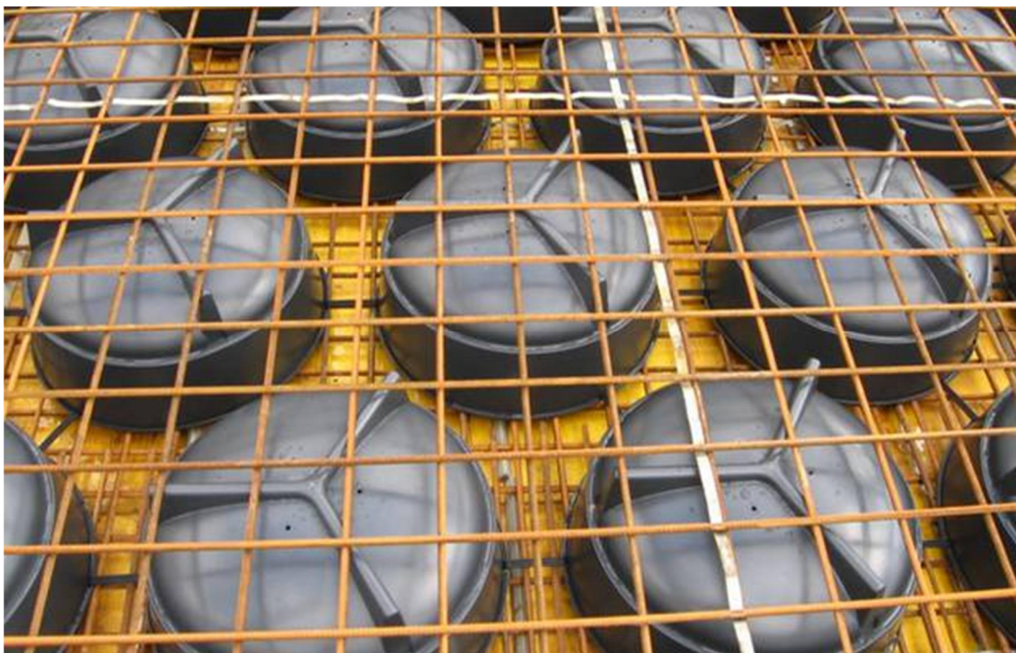
Kuva 4.1. Beeplate-rakenne ja Bamtec-mattoraudoite (Beeplate®)
