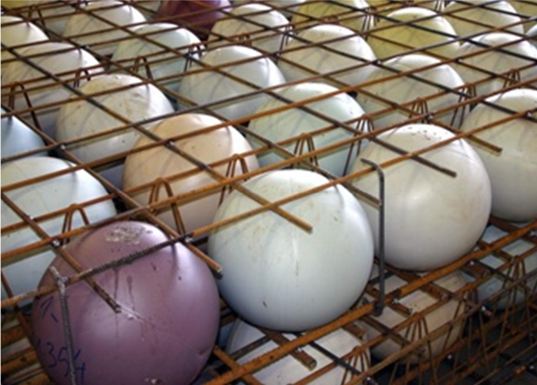
Kuva 3.2. Raudoitmoduulit pinottuina päällekkäin (Loftorka).
