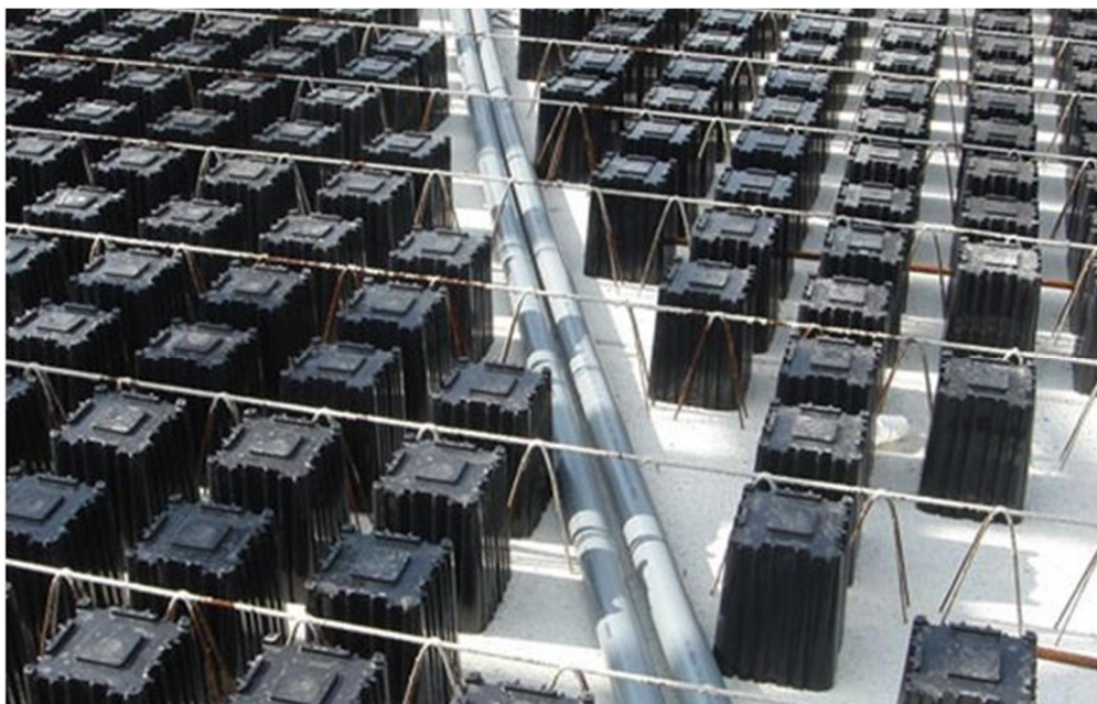
Kuva 5.1. AirDeck-välipohja ennen raudoitteiden lisäämistä ja pintavalua (AirDeck®)
