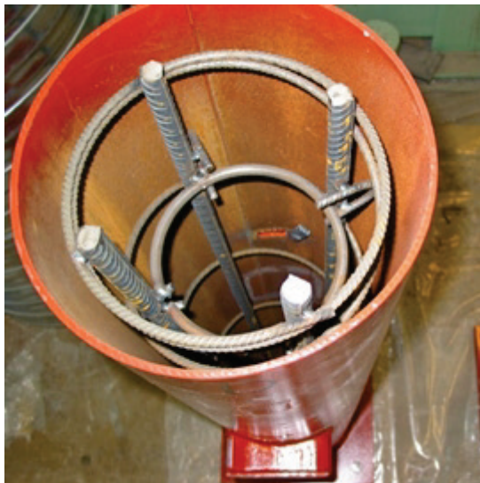
Kuva 1.1. Suomalainen pyöreä liittopilari ennen betonin valua [2]
