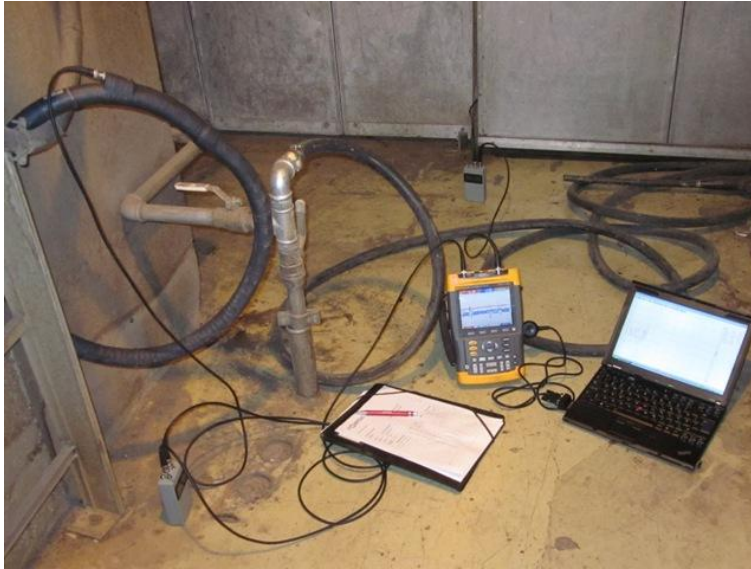
Kuva 23. Vuotovirtamittauskalusto (Moventas Gears).
