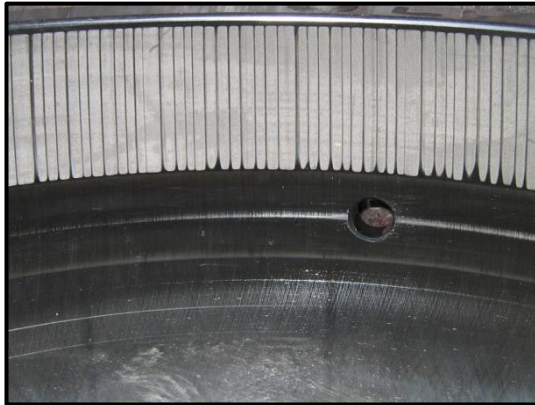
Kuva 35. Kuvan 34 mittaustuloksien laakerivaurion laakerin ulkokehän vierintärata (Moventas Gears).
