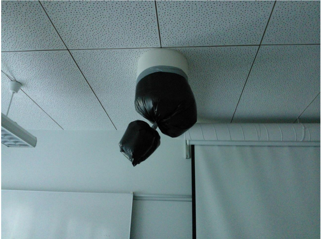
Kuva 4.9. Tuloilmapäätteet muovitettiin ja teipattiin huolellisesti ilmanvaihdon vaikutuksen poistamiseksi luokissa K1243 ja K1242.
