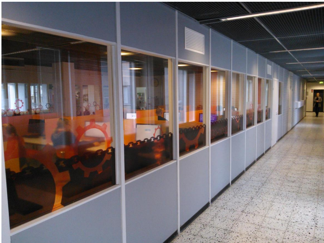
Kuva 4.8. ATK-luokan K1103 WC-käytävän puoleinen sivu, jonne siirtoilmapuhaltimet puhaltavat ilmaa ulos ATK-luokasta käytävään. Puhaltimien säleiköt ovat siistit ja ovat nähtävissä kuvan yläreunassa ikkunoiden yläpuolella.
