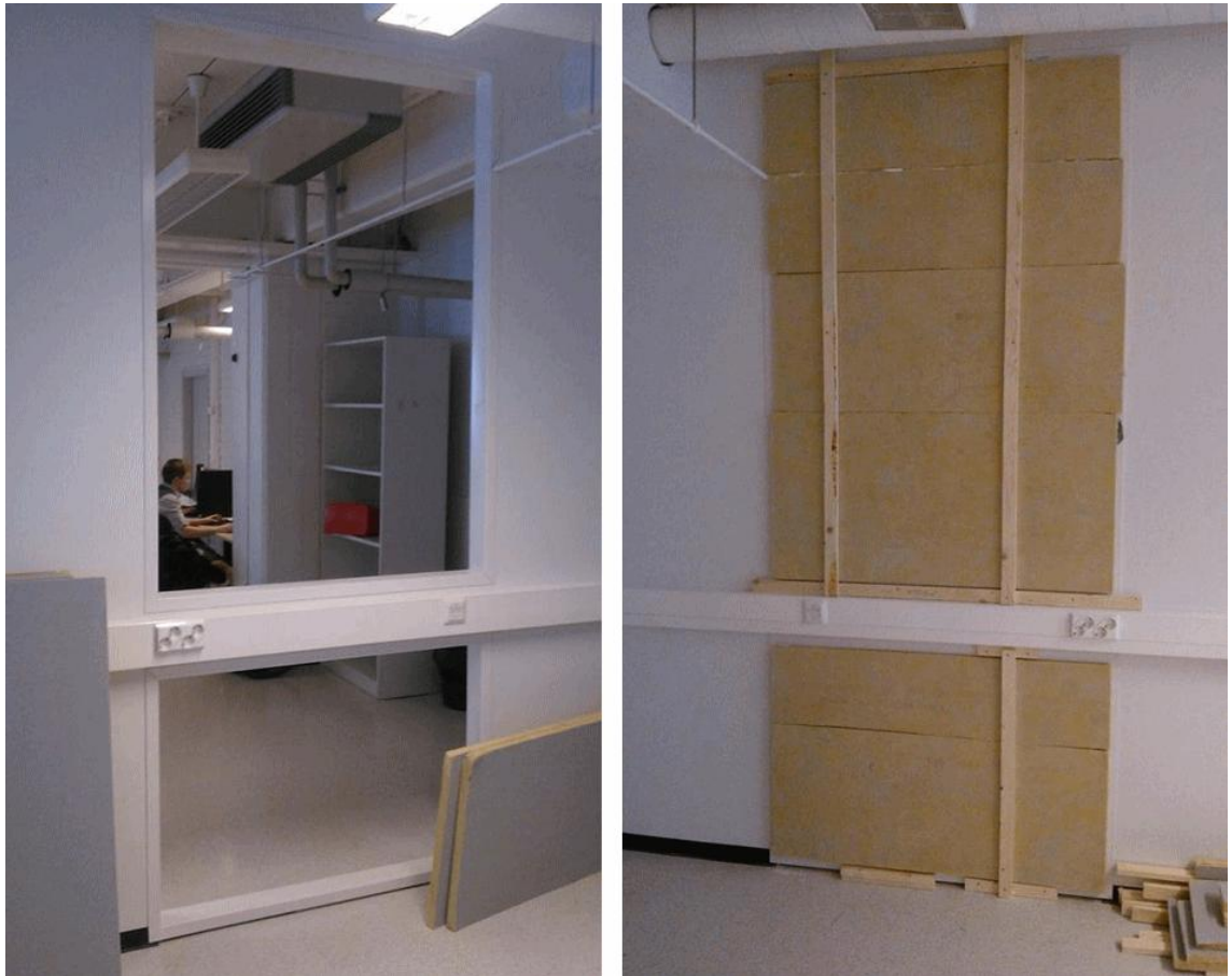
Kuva 4.6. Luokkien K1242 ja K1243 välille tehty siirtoilma-aukko. Koko aukko on 265 senttimetriä korkea ja 116 senttimetriä leveä. Aukko tai osa siitä voitiin tarpeen mukaan peittää eristelevyin.
