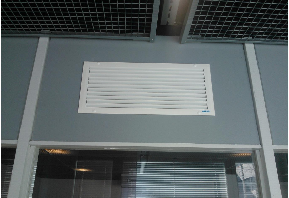
Kuva 4.7. Mobair 4100 siirtoilmalaite asennettuna luokan K1103 ja Konetalon aulan WC-käytävän väliseen seinään.
