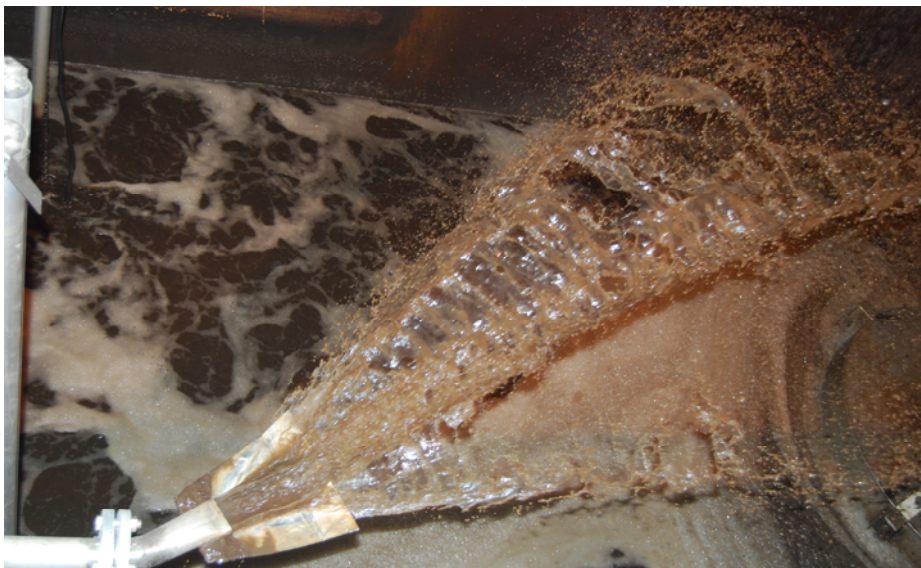
Kuva 24. Altaassa oleva vaahdonestolaite, johon pumpataan altaassa olevaa prosessivettä.
