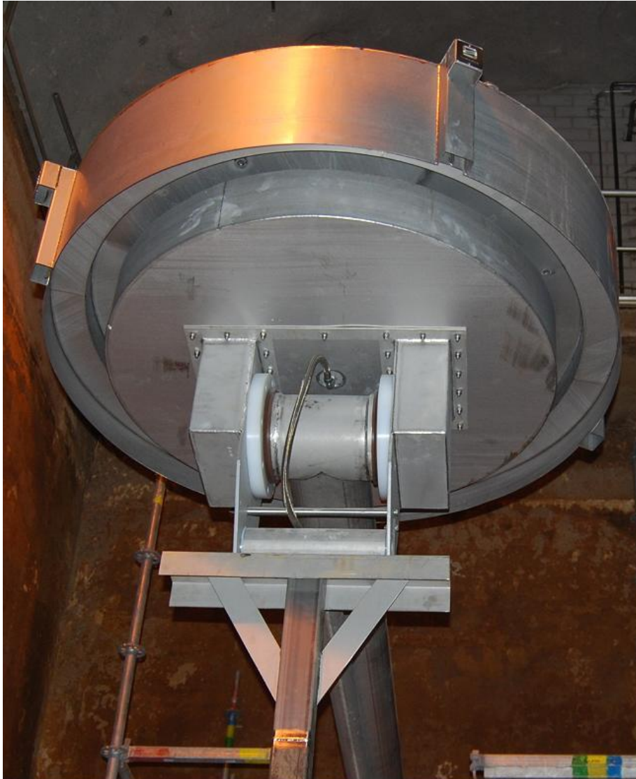
Kuva 27. Altaaseen asennettu dekantteri kuvattuna altaan pohjalta.
