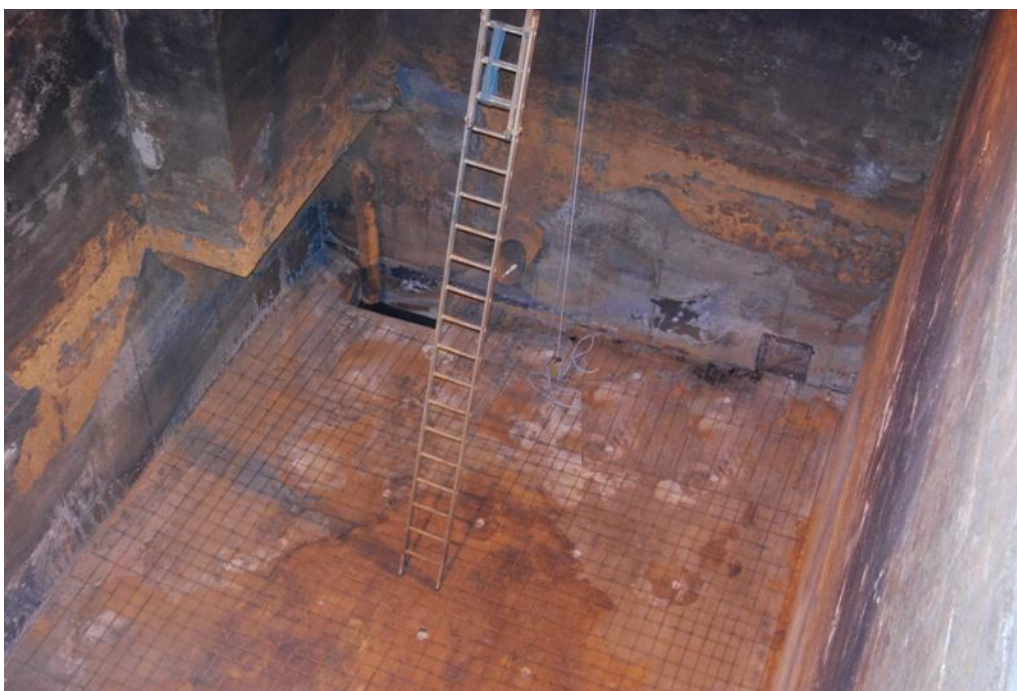
Kuva 22. Demon ® prosessialtaasta purku-urakan jälkeen ennen tasoitusta.
