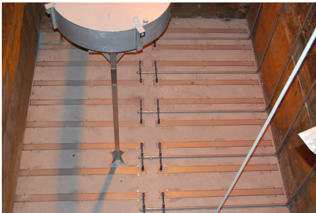
Kuva 25. Demon®-altaan pohja, jossa on asennettuna Aerostrip®-paneeli-ilmastimet.
