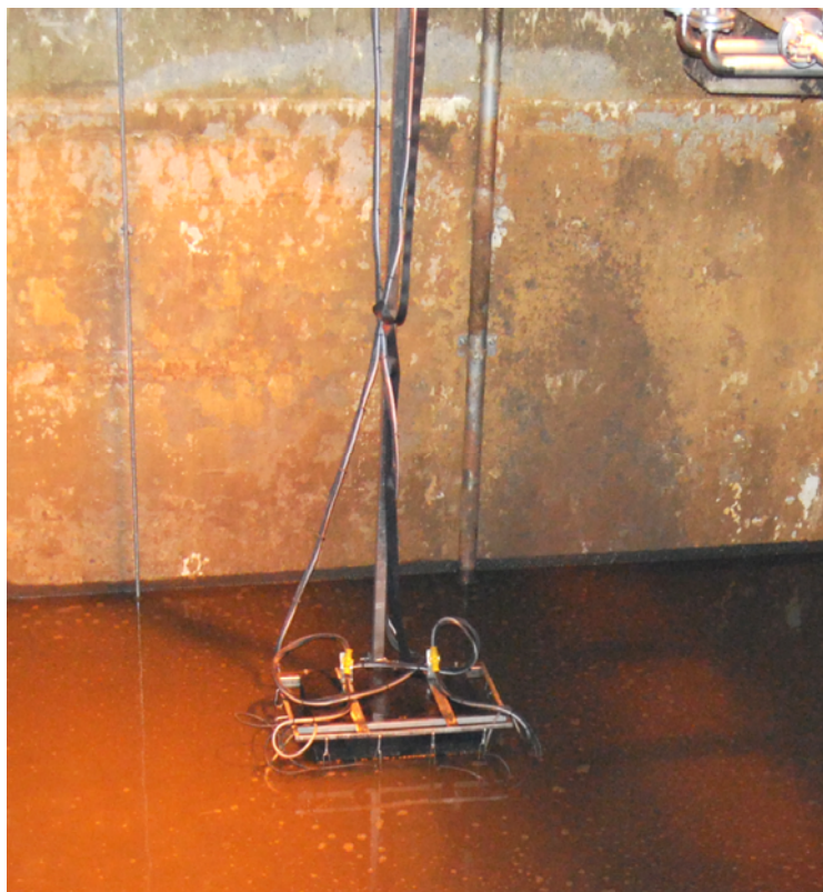
Kuva 28. Altaassa olevat jatkuvatoimiset mittaukset asennettiin kelluvaan lauttaan.
