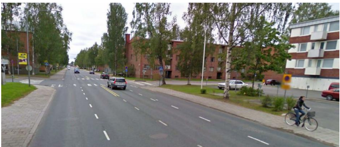
Kuva 4.13. Koulukatu Sairaalakadun liittymän kohdalla on tyypillistä Koulukatua leveine ajoratoineen ja pitkine suojaiteineen. Kadun ylittäminen on vaikeaa ja turvaton. Pyörätienä toimii kapea jalkakäytävä betonilaatoituksineen (kuva Google 2009).
