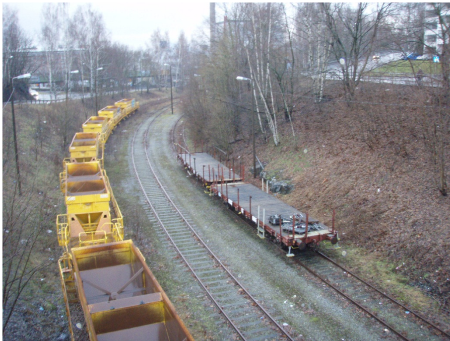
Kuva 4.6. Näkymä Kastinsillalta pohjoiseen Naistenlahdenkadulle.
