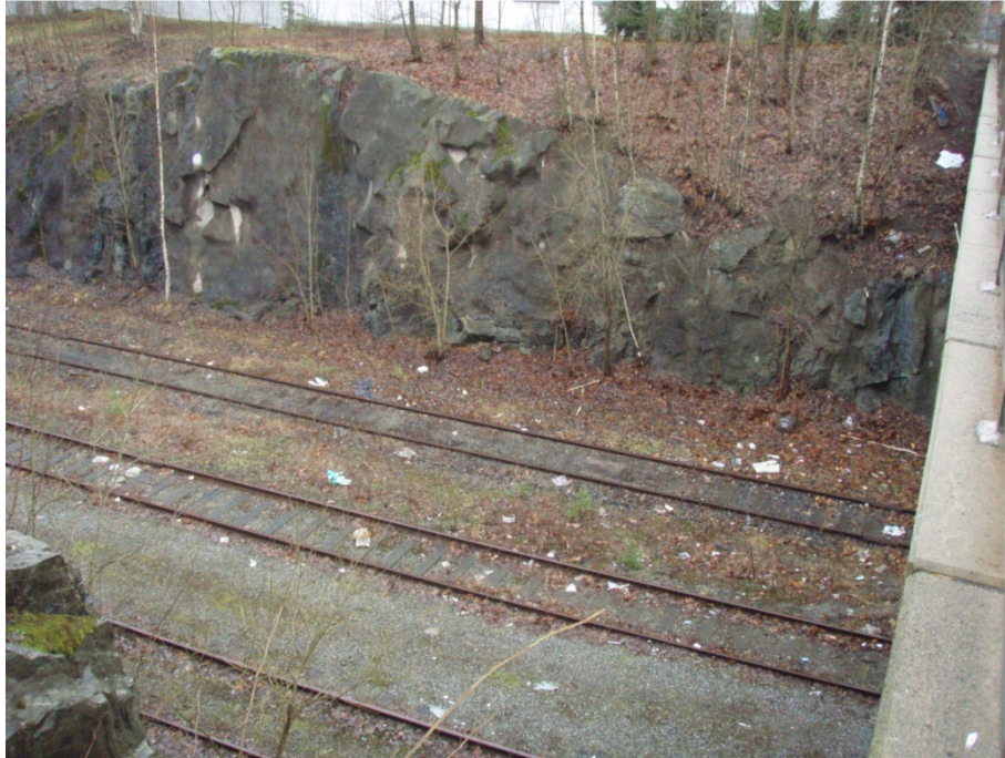
Kuva 4.5. Ratapihan kallioleikkausta Kastinsilta.
