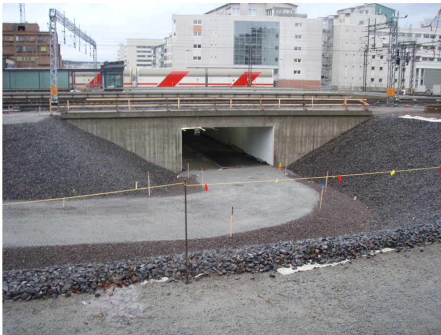
Kuva 4.2. Rongankadun alikäytävän rakennusvaihe ratapihalla.
