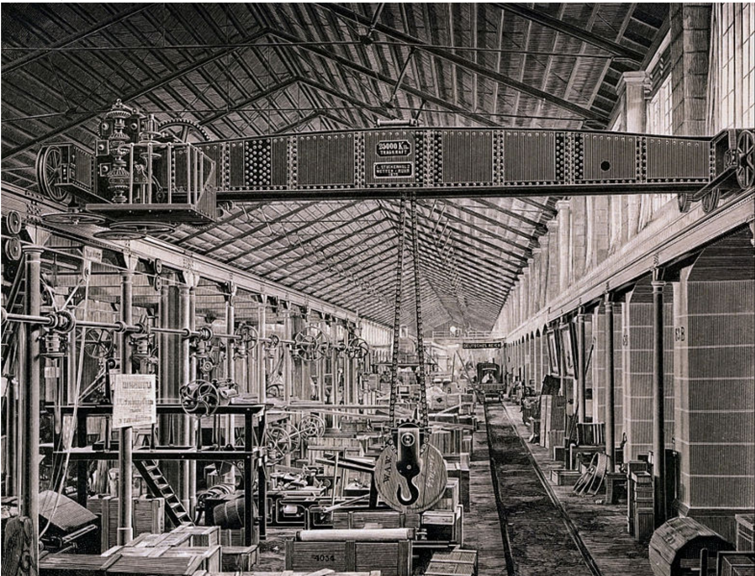
Kuva 5.6 Mechanische Werkstätten Harkort & Co höyrytoiminen hallinosturi vuodelta 1875
