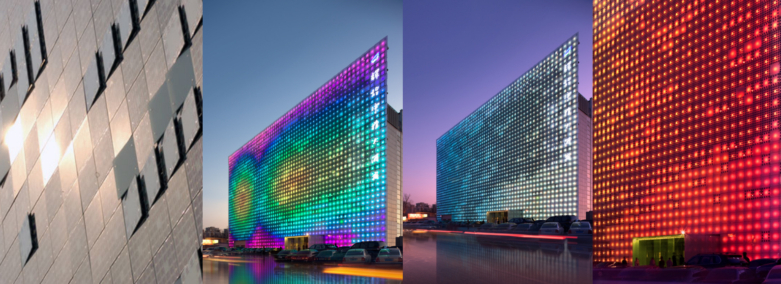
Kuva 31–34. Xicui viihdekeskus, Pekingissä. Julkisivussa on käytetty digitaalista mediaa, joka hyödyntää ympäristöstävällistä energiaa. Mediaseinä hankkii oman energiansa aurinkokennoista.
