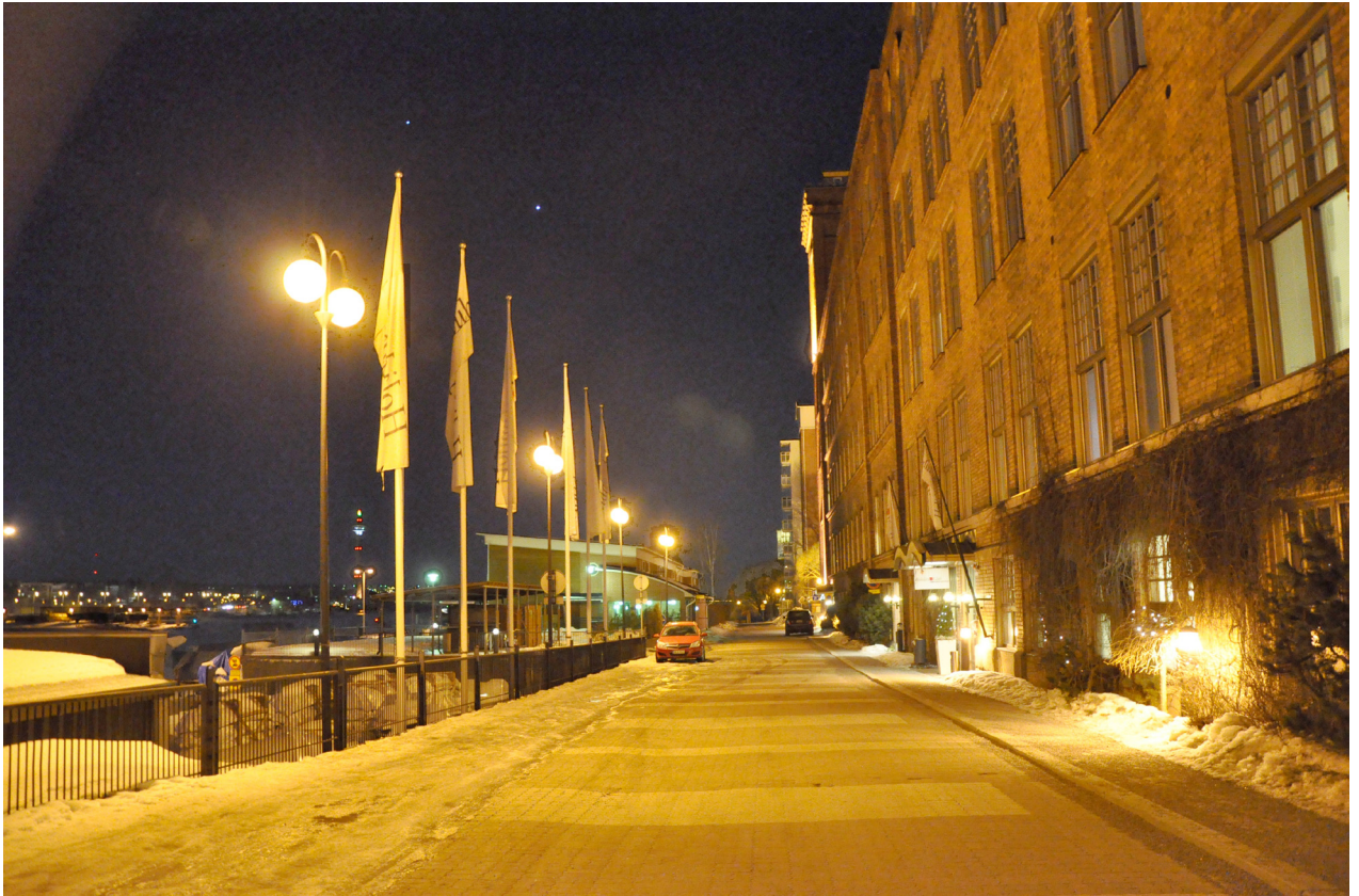
Kuva 91. Lapinniemen kylpylä katutilaa.
