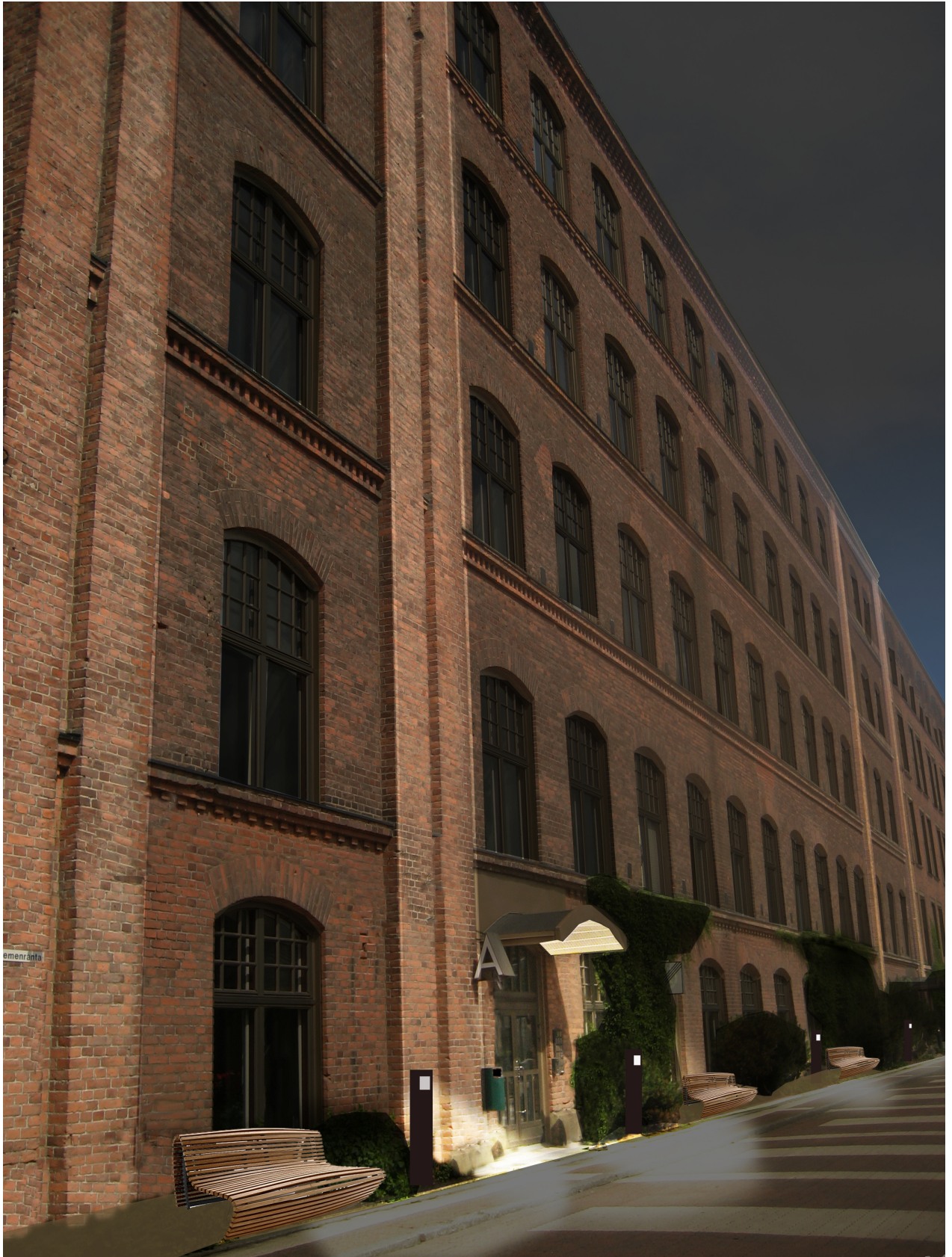
Kuva 103. Katutilan valaistus pollarivalaisimin ja sisäänkäyntikatosten uusittu valaistus.
