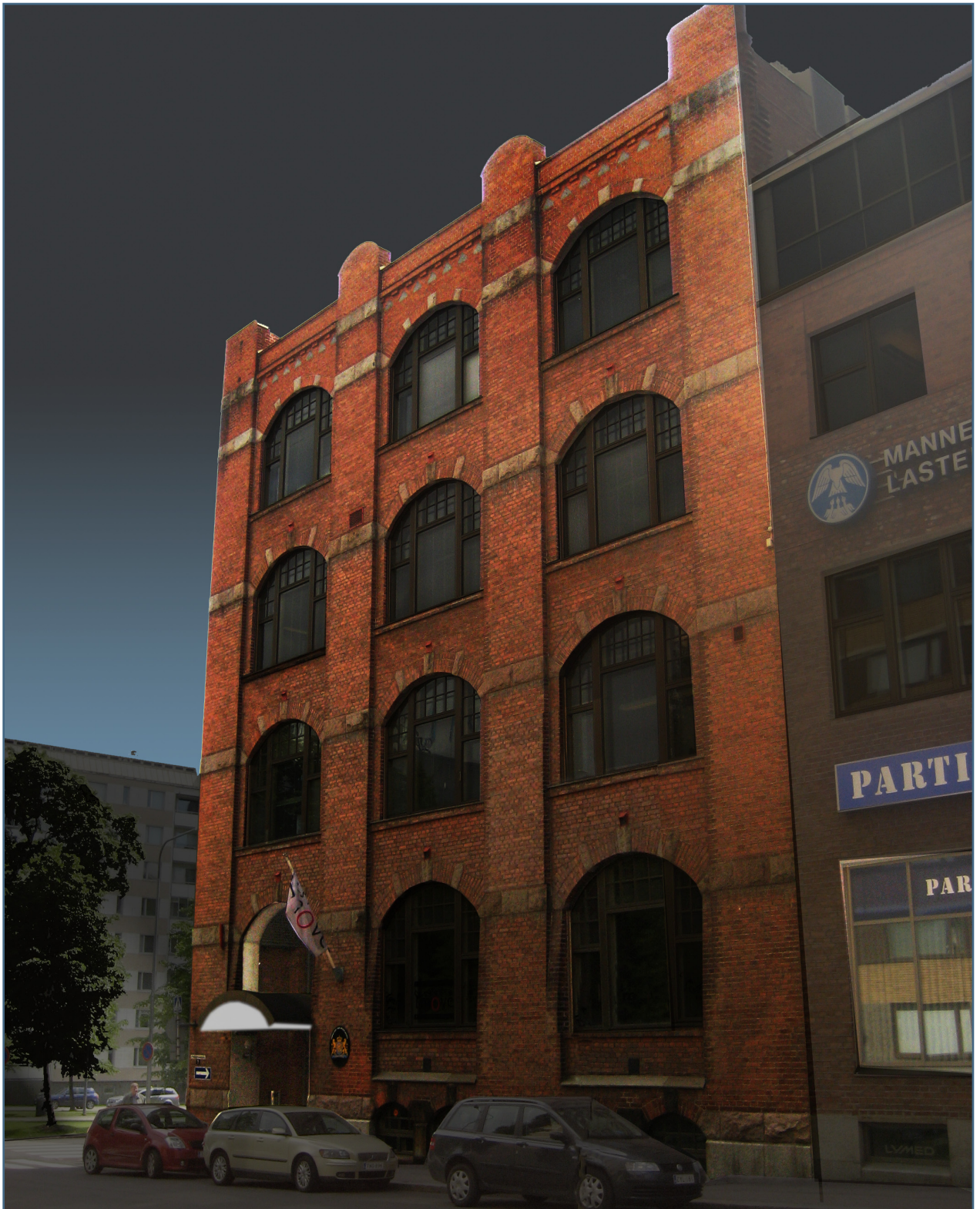
Kuva 79. Näkymä korttelin koilliskulmasta. Vuonna 1904 rakennettu osuus on valaistu muiden Pyhäjärvenkadun julkisivujen jäädessä ilman yleisvaloa.
