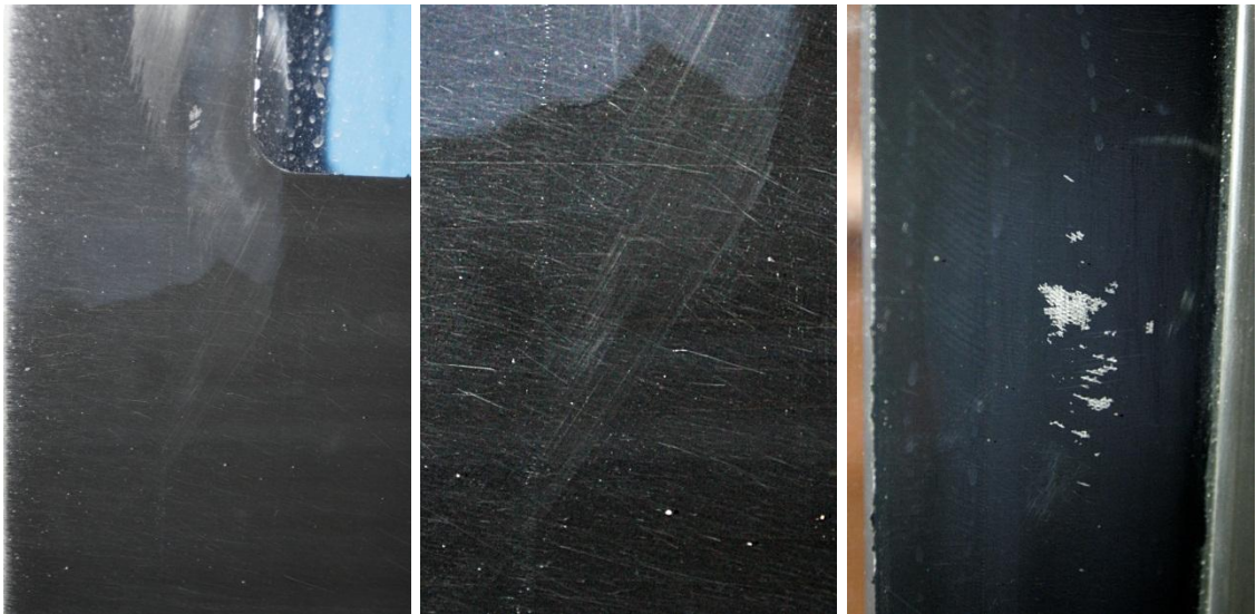
Kuva 16: Vasemmalla: harmaantumista primerpinnassa, keskellä: suurennettu kuva naarmuista, oikealla: primerin lohkeilua
