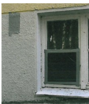
Kuva L6.3. Kellarikerroksessa sijainneen liesituulettimen ja raitisilmaventtiilien (pukuhuoneet) teippaus. Oikealla olevassa kuvassa on vielä esitettyä vanhan painovoimaisen ilmanvaihtojärjestelmän poistoilmakanavien teippaus.
