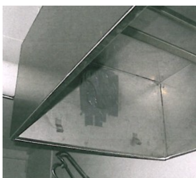
Kuva L6.3. Kellarikerroksessa sijainneen liesituulettimen ja raitisilmaventtiilien (pukuhuoneet) teippaus. Oikealla olevassa kuvassa on vielä esitettyä vanhan painovoimaisen ilmanvaihtojärjestelmän poistoilmakanavien teippaus.
