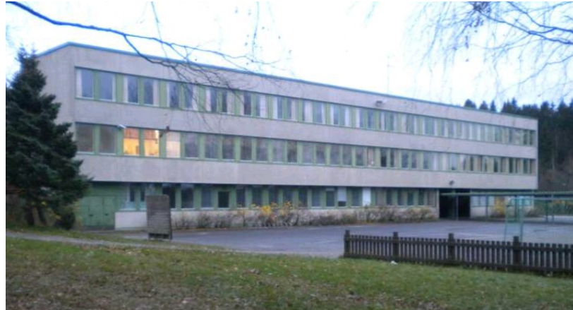
Kuva 5.6. Koulun B itäjulkisivu.
