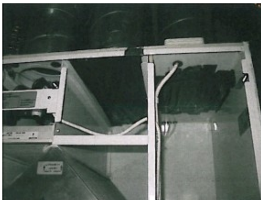
Kuva L6.1. Ilmanvaihtokoneiden teippaukset.
