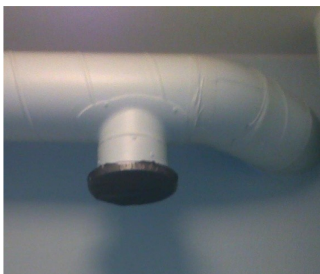
Kuva L6.2. Ullakotilassa sijaitsevan ilmanvaihtokoneen poisto- ja tuloilmaventtiilien teippaus.
