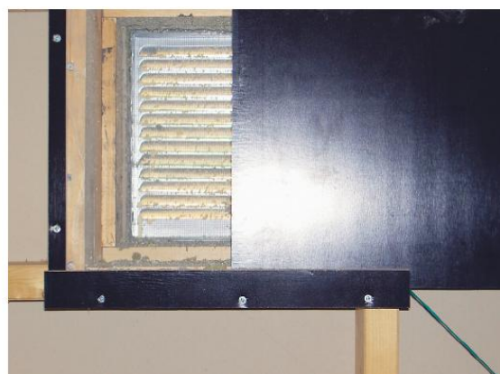
Kuva 33: Ullakkotilan tuulettumista rajoitettiin voimakkaasti sulkemalla tuuletusraot räystäällä ja rakennuksen päädyissä. [55]
