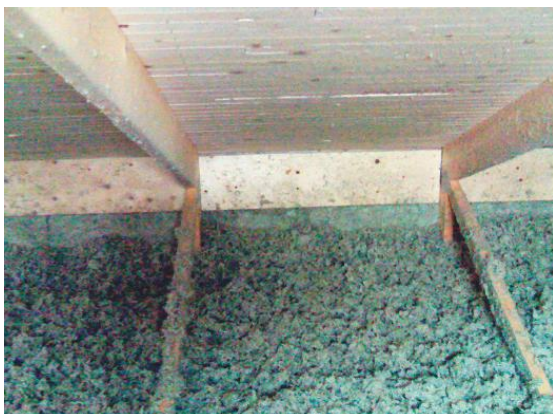
Kuva 33: Ullakkotilan tuulettumista rajoitettiin voimakkaasti sulkemalla tuuletusraot räystäällä ja rakennuksen päädyissä. [55]
