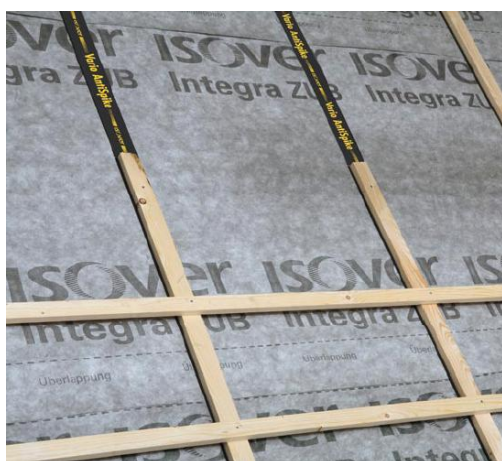
Kuva 15: Erityisellä tiivistysteipillä voidaan tiivistää naulausreiät korokerimojen alla [31].
