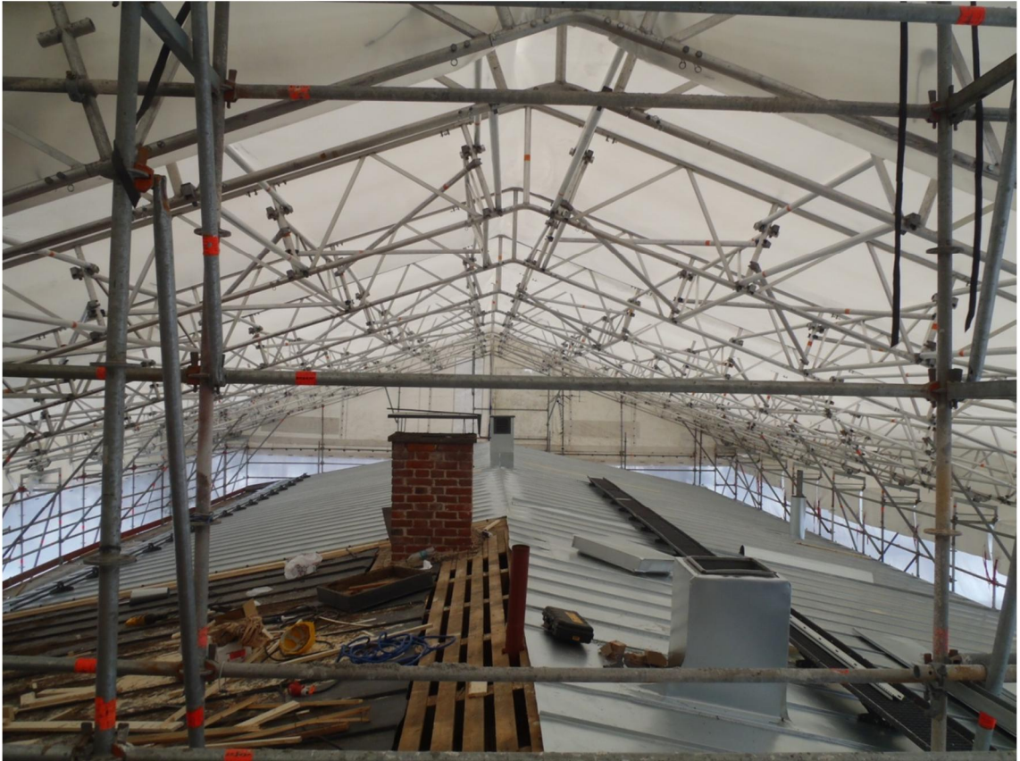
Kuva 2.3. Seurasaaren ravintolan vesikaton korjaustyömaa talvella 2011. Kuva sääsuojauksesta on otettu päivällä. Kuvasta näkee, että sääsuojan läpi pääsee riittävästi valoa työskentelyä varten. (kuva: Olli Teriö).
