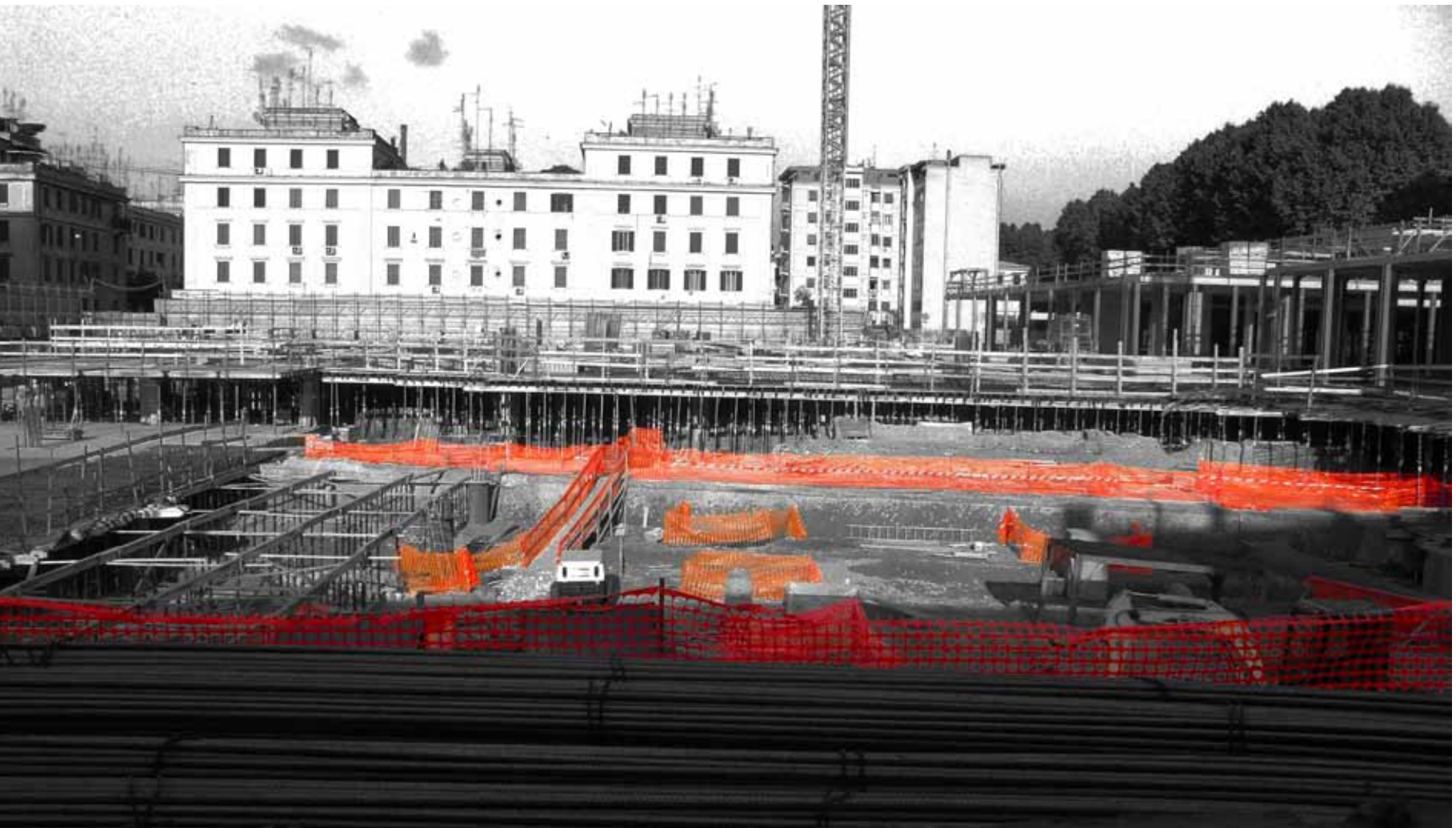
Kuva 119. Raunioiden päälle valetaan välipohja. Pelkistetyt betonikatot ja seinät luovat museolle rauhalliset puitteet.
