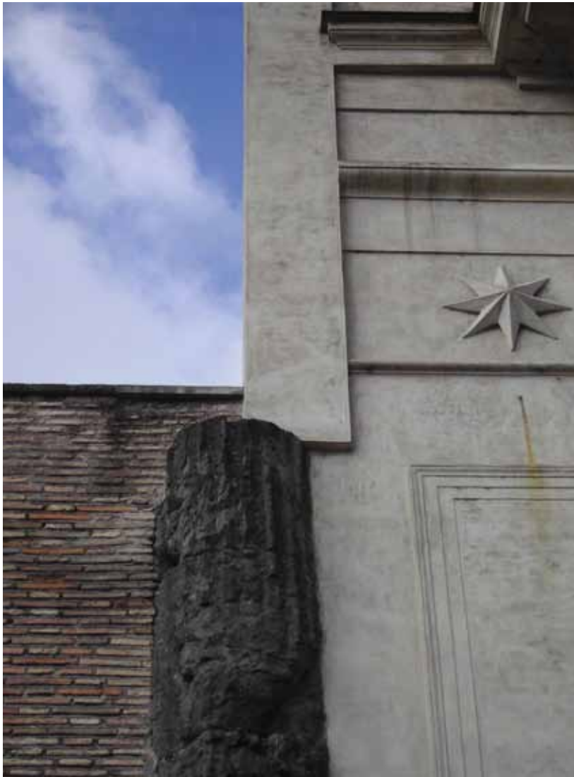
Kuva 6. Yksityiskohta Basilica San Nicola in Carceren restauroidusta pääjulkisivusta. Kirkko on hyvä esimerkki kerroksellisesta rakentamisesta ja rakennusosien uudelleenkäytöstä. Kirkon rakentamisessa on käytetty hyödyksi kolmen tasavallan aikaisen temppelin, Januksen temppelin, Juno Sospitan temppelin ja Toivon (Spes) temppelin rakenteita. Kuvassa on alkuperäisellä paikallaan oleva Juno Sospitan temppelin (197–194 eKr.) kapiteelinsa menettänyt nurkkapylväs, osa keskiajalla rakennettua tiiliseinää ja Giacomo Della Portan 1500-luvun julkisivua. Kirkko kuvastaa hyvin eri aikakerrostumia. Rakennus toimii yhä kirkkona, toisin kuin lähellä sijaitsevat Ercole Vincitore ja Fortuna Virile, jotka on poistettu uskonnollisesta käytöstä.
