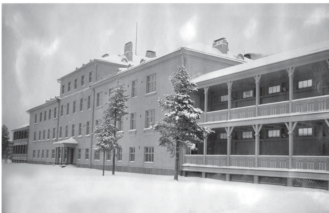
Kuva 10. Vuonna 1927 avattu Muurolan tuberkuloosiparantolan päärakennus Rovaniemellä. Hallimakuuparvekkeet, jotka mahdollistivat levon raittiissa ulkoilmassa, olivat olennainen osa tuberkuloosihoitoa (Helsingin yliopistomuseo).
