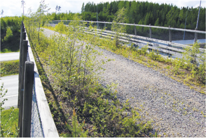
Kuva. Riistasilta Hämeenlinnan moottoritien kohdalla
