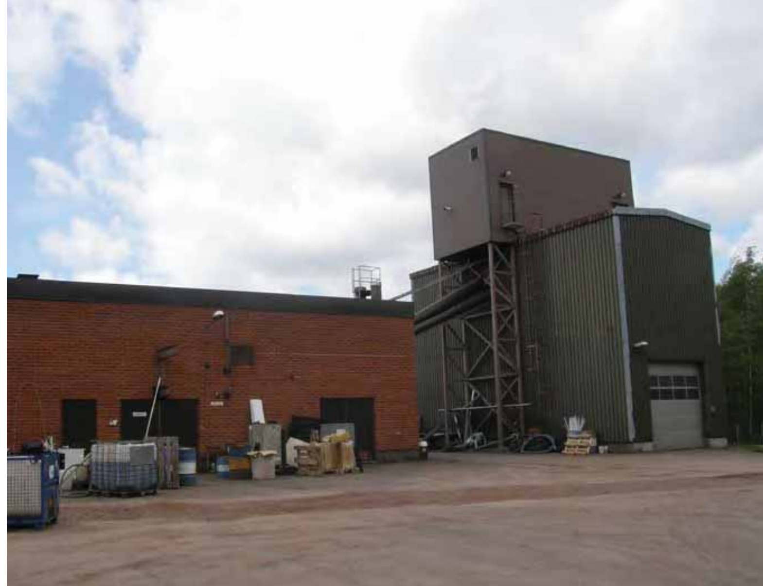
Sunilan jätevedenpuhdistamo. (Juuti & Rajala 2010)
