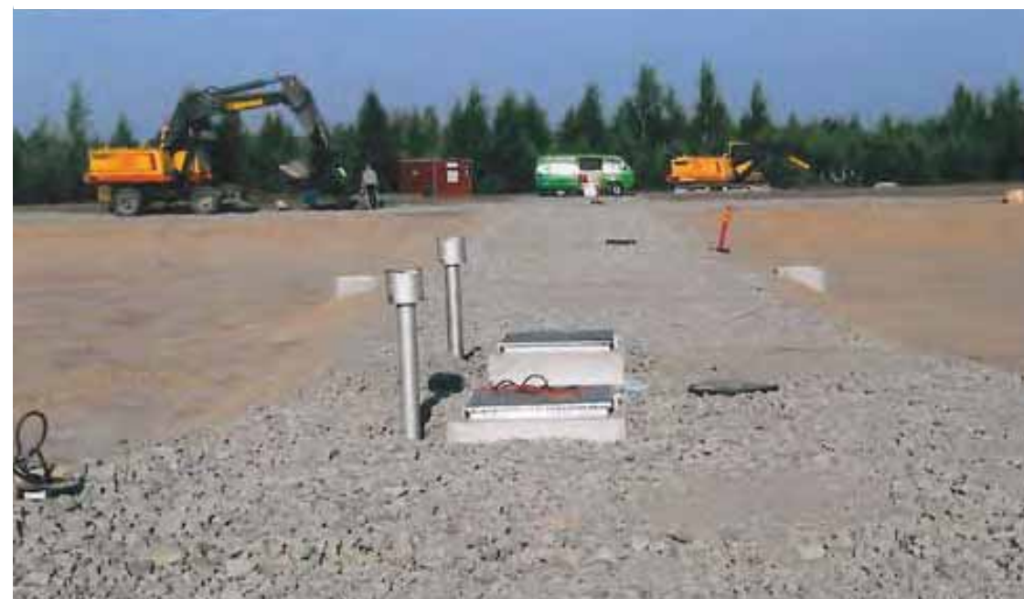
E 1-8 imeytysal- taiden rakennus- työmaa.
