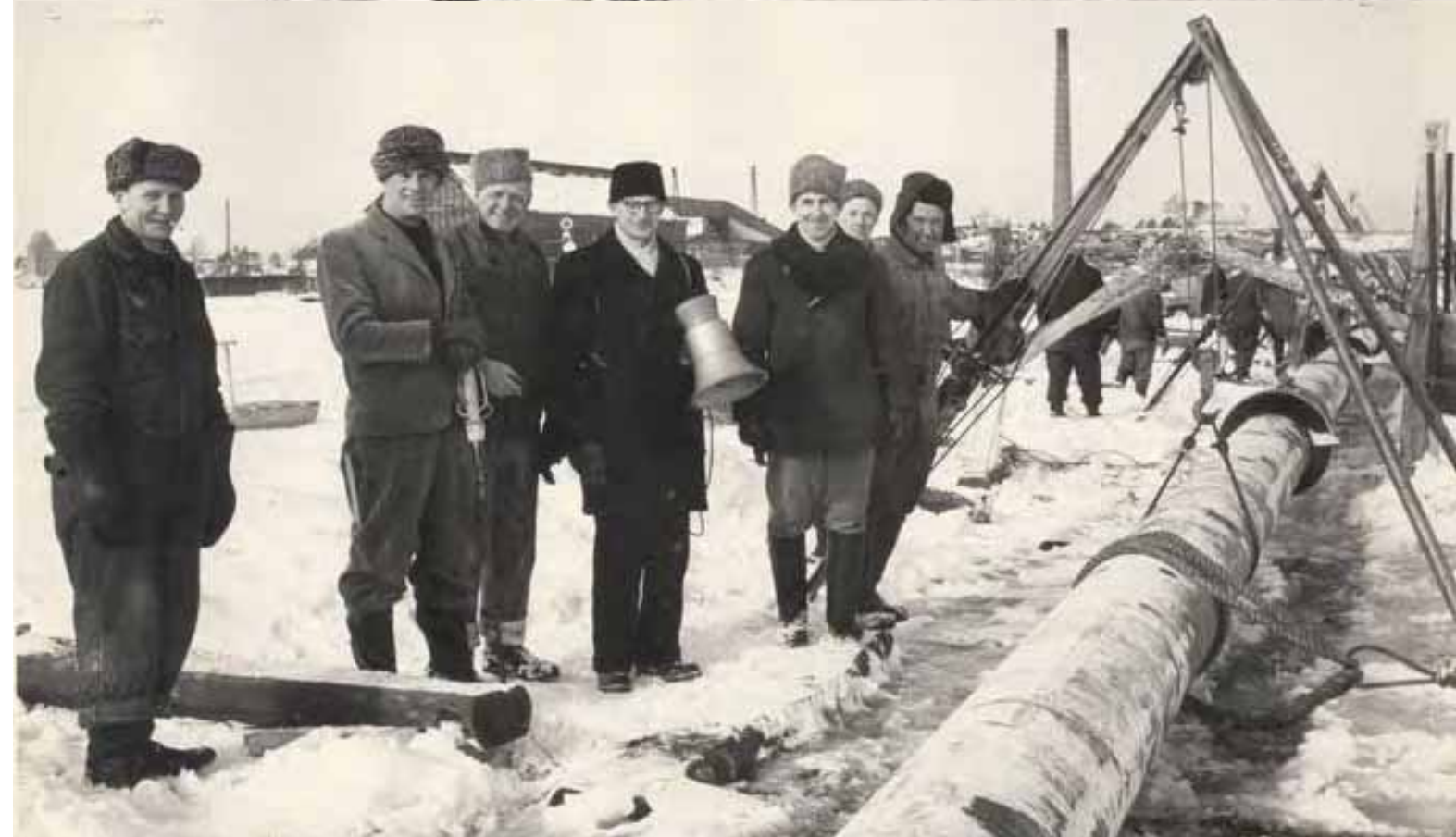
Hovisaari – Kotkansaari ø 400mm vesijohdon rakentaminen vuonna 1957. Vesistöön upotus. Mannesman teräsputki.
