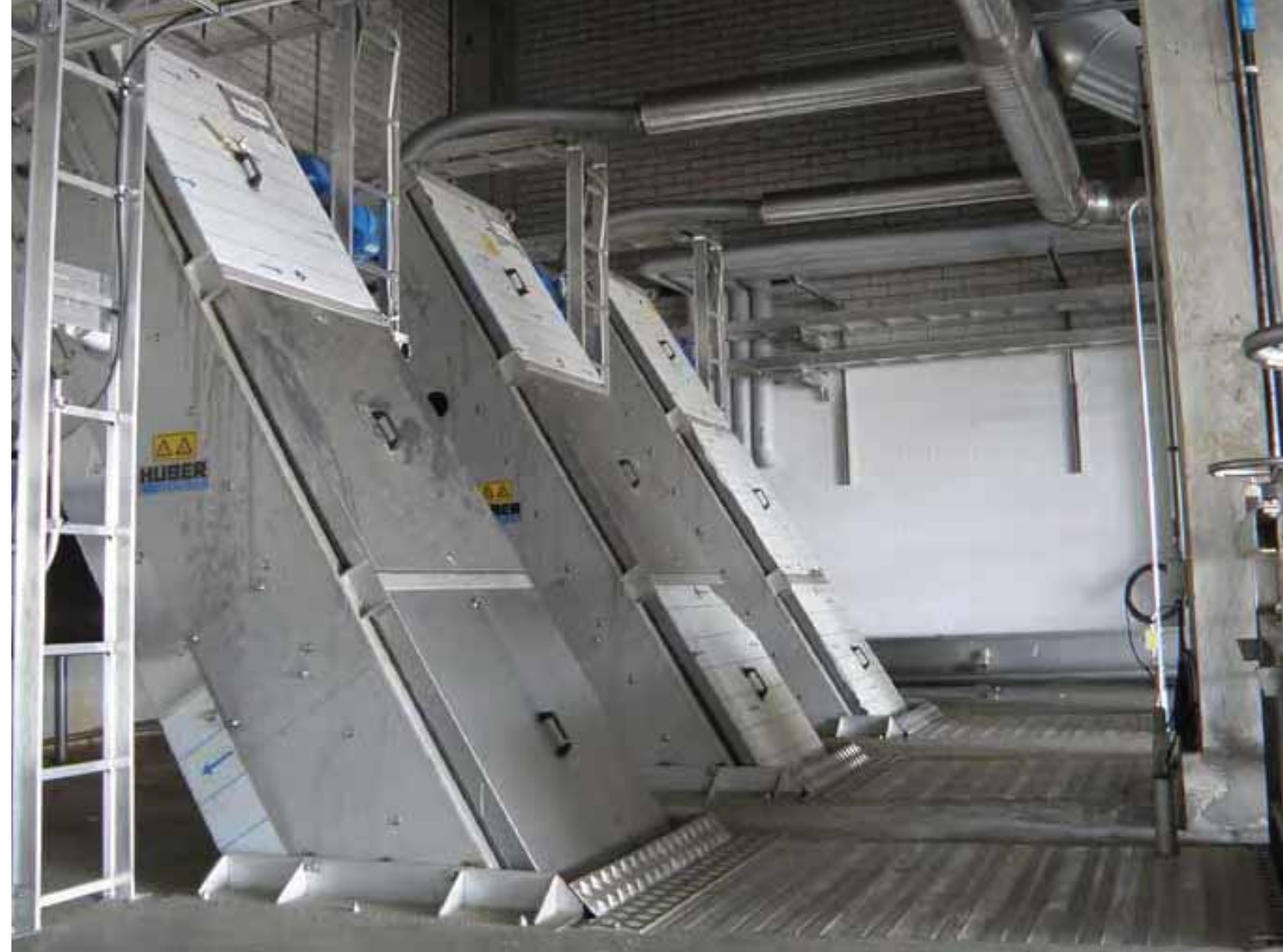
Jätevedenpuhdistaminen alkaa välppäyksellä. Ylhäällä välpät ja alakuvassa välppäjätteet. (Juuti & Rajala 2010)
