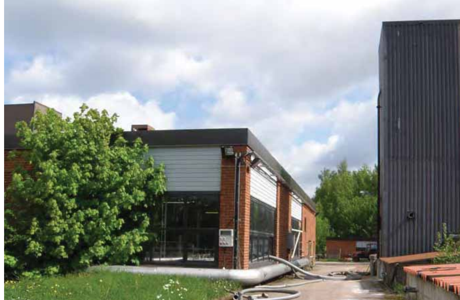
Karhulassa Sunilan jätevedenpuhdistamo otettiin käyttöön vuonna 1978. (Juuti & Rajala 2010)
