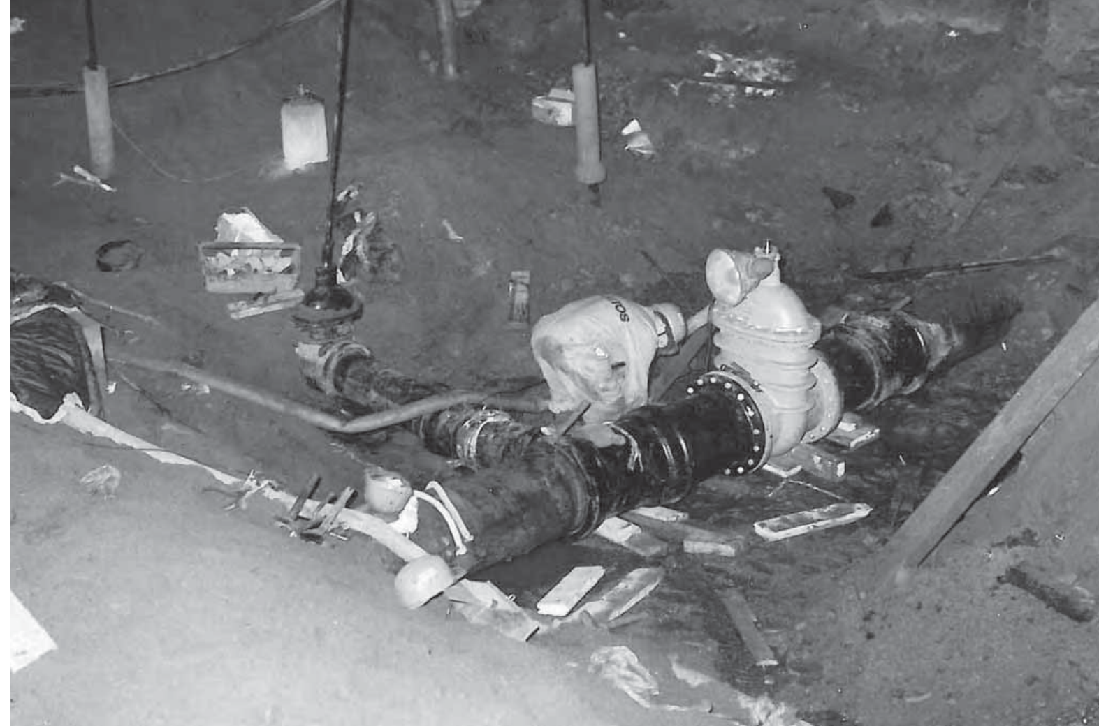
Vesijohdon rakentaminen 1971-1972 Rautatienkatu-Mutalahdenkatu risteys. Töissä on Kotkan kaupungin teknisen viraston vesihuolto-osasto.
