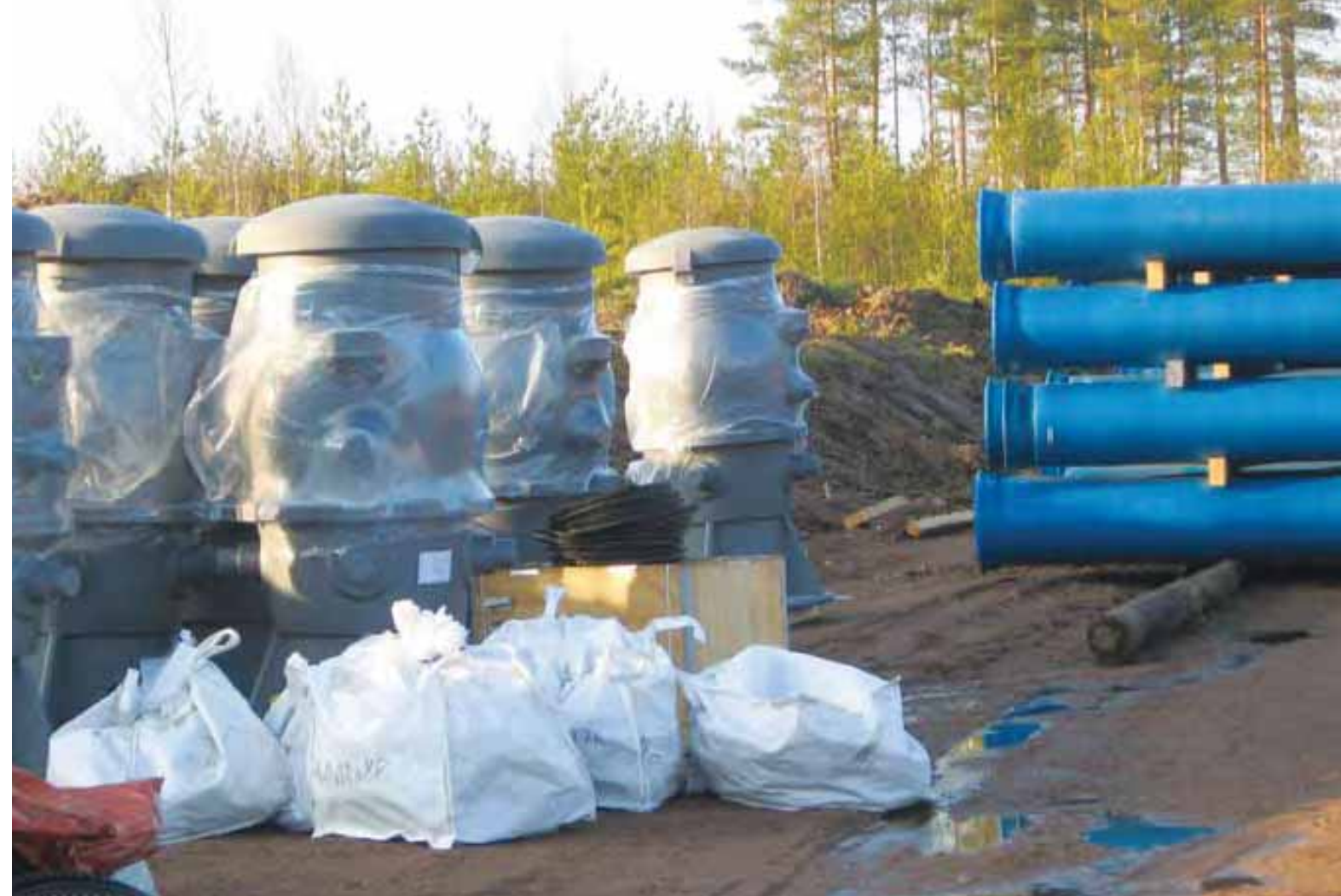
Yläkuvassa siirtolinjan rakentamisessa käytettyjä kaivoja ja alakuvassa putkivarastoa.
