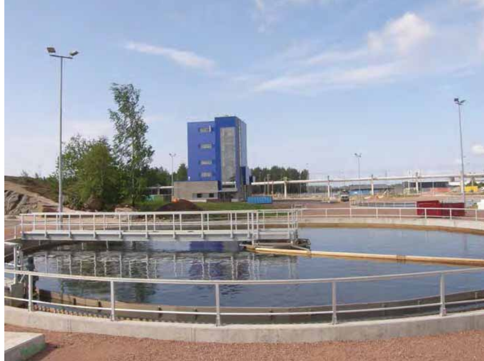
Mussalon saneerattu jätevedenpuhdistamo 2010. (Juuti & Rajala)
