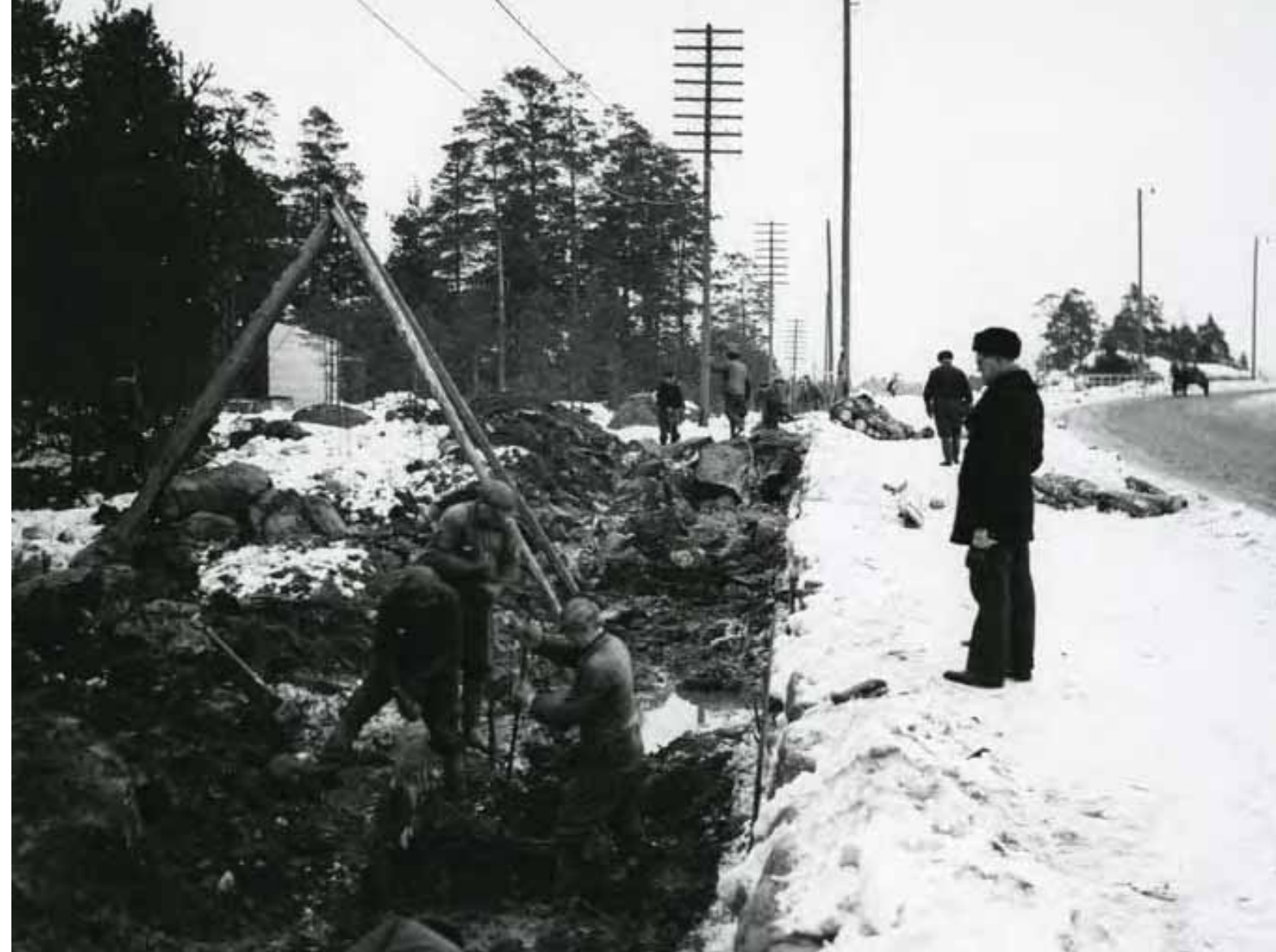
Kolmijalka oli apuna putkien nostossa. Vesijohtotyömaa 1940-1950-luvulta. (Kymenlaakson museo)
