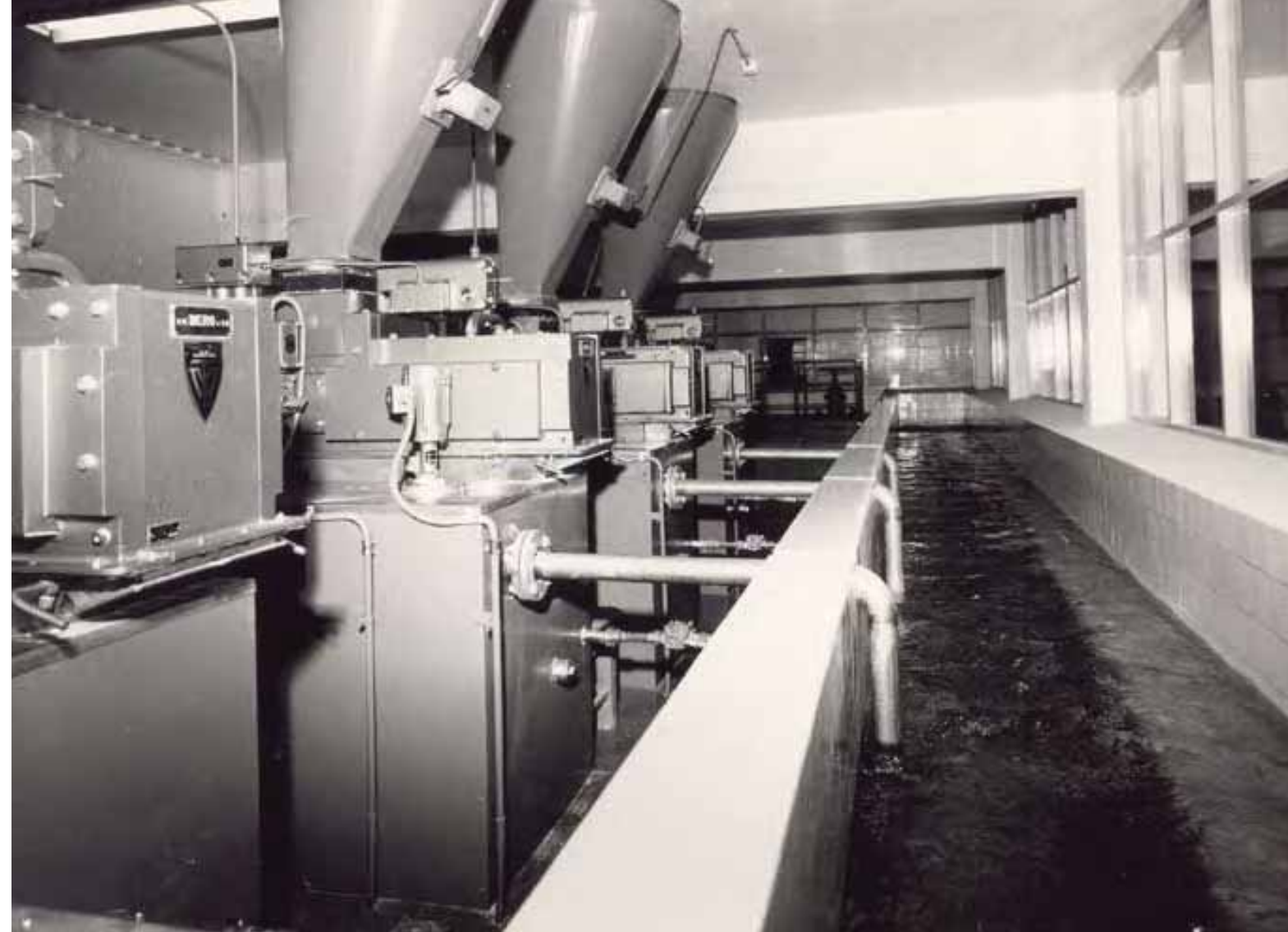
Esikalkin ja alumiinisulfaatin syöttölaitteet Langinkoskella. Kuva vuodelta 1968.
