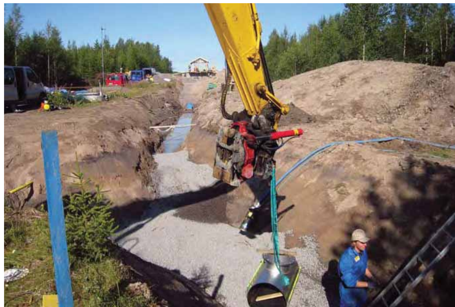
Kuvassa tehdään paineellinen haaroitus Kotkan/Anjalankosken välisessä DN600 siirtoputkessa 20.7.2009. Työstä vastasi Tonisco Systems Oy. Siirtoputki oli sisäpuolelta betonivuorattu teräsputki. Työssä käytettiin ns. haarasatulaa, joka asennettiin huolellisesti puhdistetun putken ympärille.
