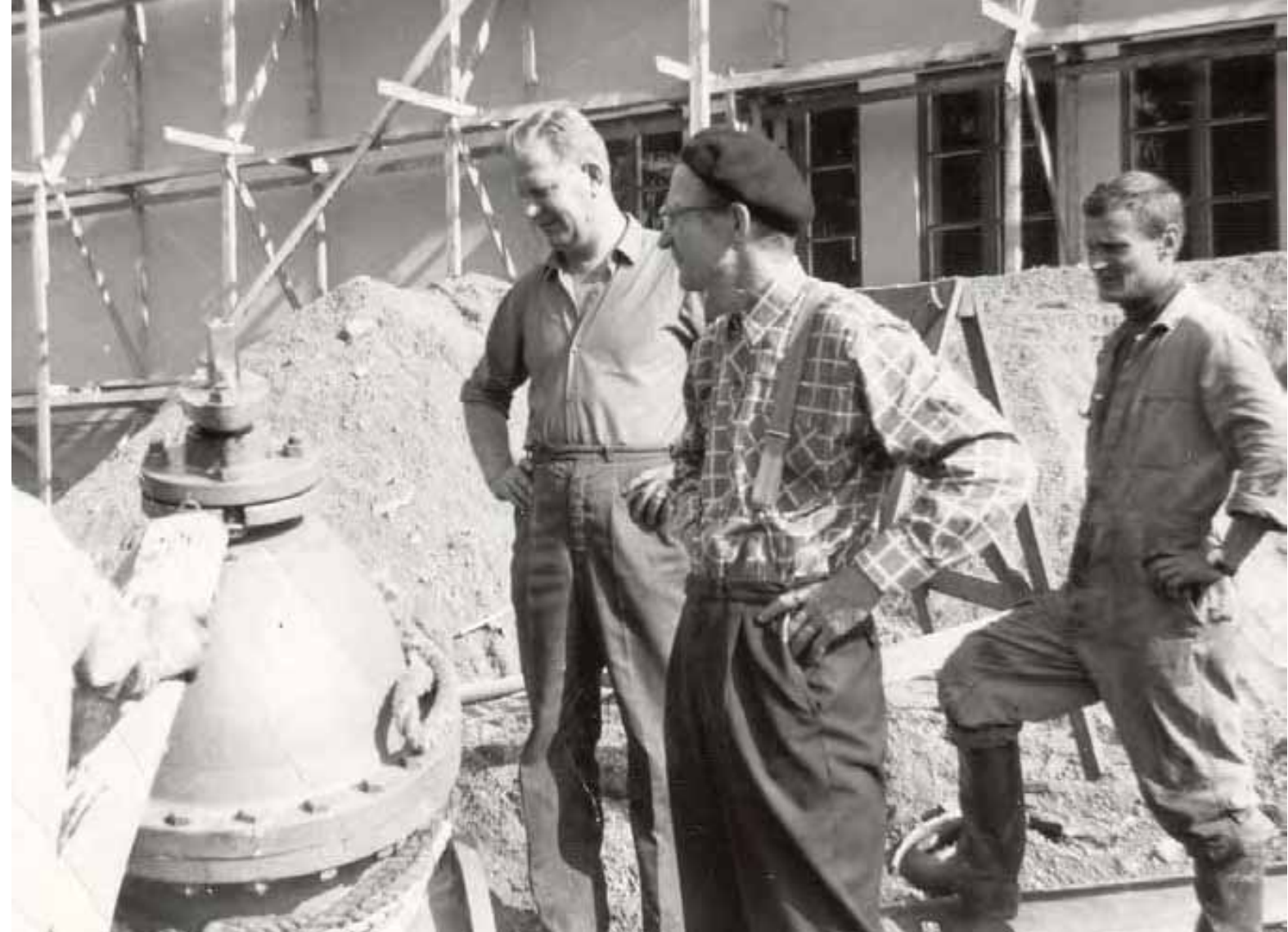
Langinkosken vedenkäsittelylaitos laajennus n. -68. 500 sulkuventtiilin ääressä P. Wahlman, M. Koponen & E. Leppänen.
