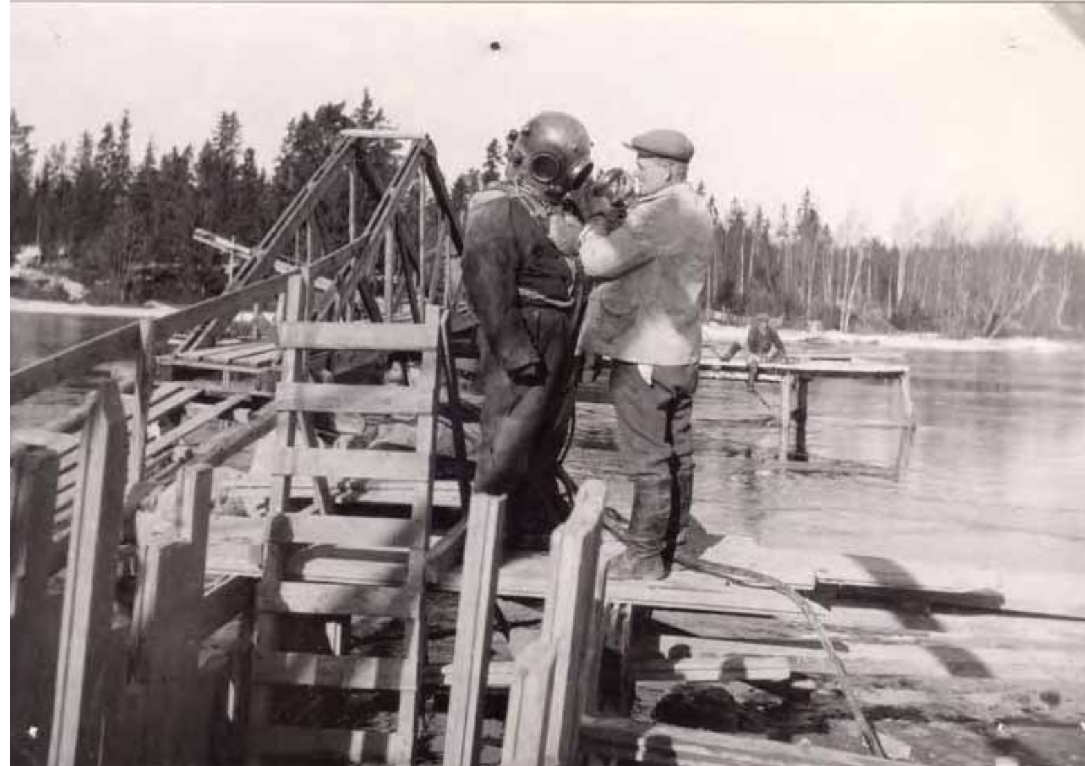
Langinkosken vedenkäsittelylaitoksen raakavesipumppaamon imuputken rakentaminen. Kuva vuodelta 1944. Sukeltaja on valmis työhön.
