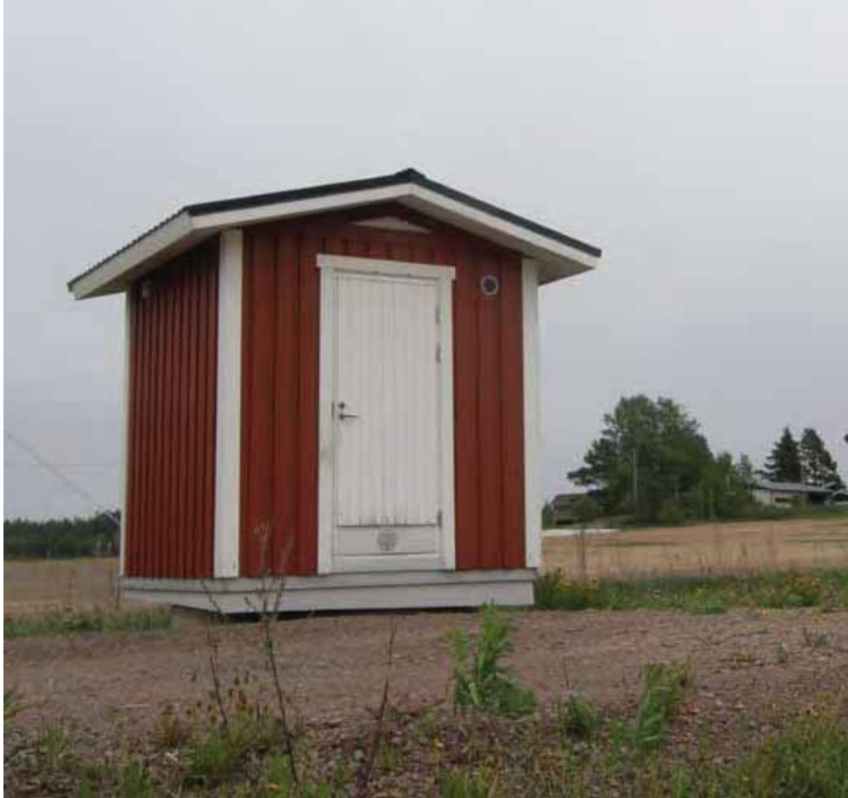
Mokran jätevedenpumppaamo Pyhtäällä. (Juuti & Rajala 2010)
