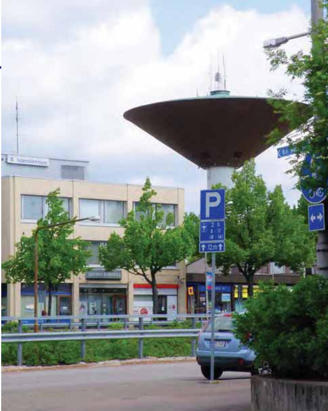
Karhulan vesitorni on rakennettu vuonna 1960. Vesisäiliön tilavuus on 2130 kuutiometriä. Arkkitehtuurista vastasi K. Tiihonen. Pääurakoitsijana oli Vesto. (Asola 2003, kuva Juuti 2010)
