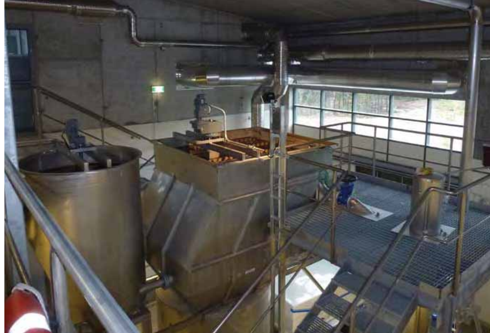
Esikäsitteilylaitos lamelliselkeytys (Juuti 2011)
