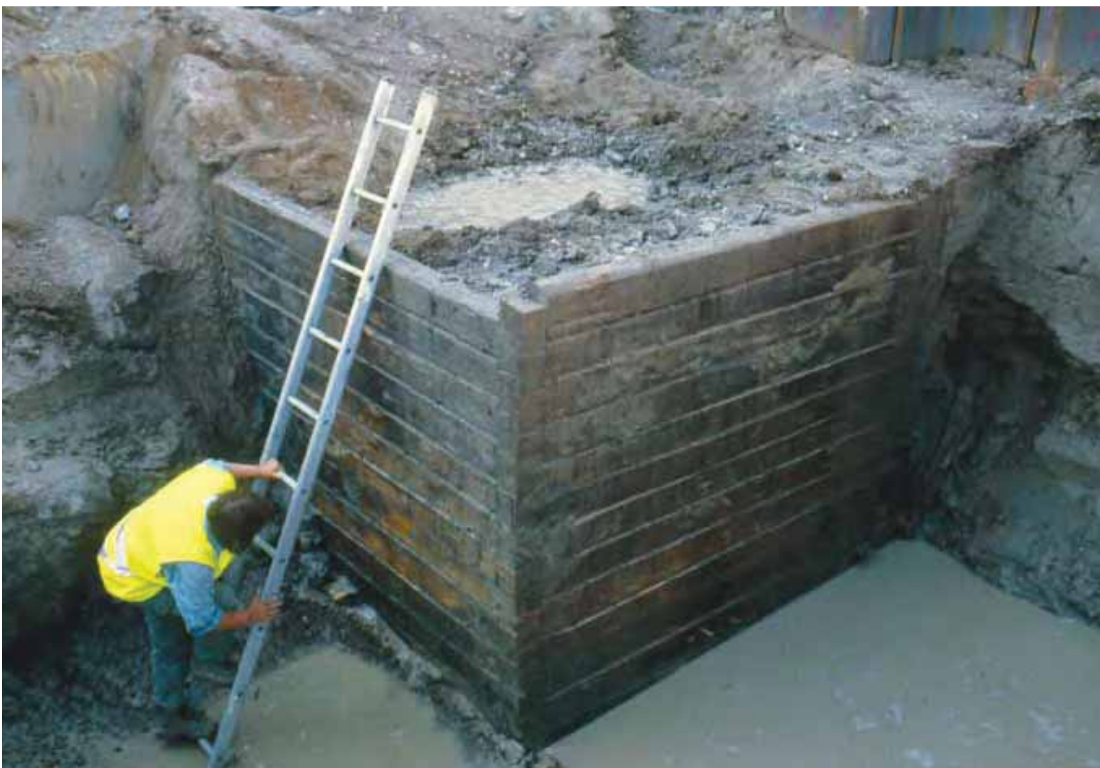
Toriparkki-kaivaukset. Yksi Kotkan yleisistä kaivoista, Tammelinin kaivo, paljastui aivan nykyisen torin etelänurkasta. 1800- ja 1900-luvun taitteessa käytössä olleesta kaivosta oli enimmillään säilynyt 20 päällekkäistä hirsikertaa. (Kymenlaakson museo, Maarit Laitala)
