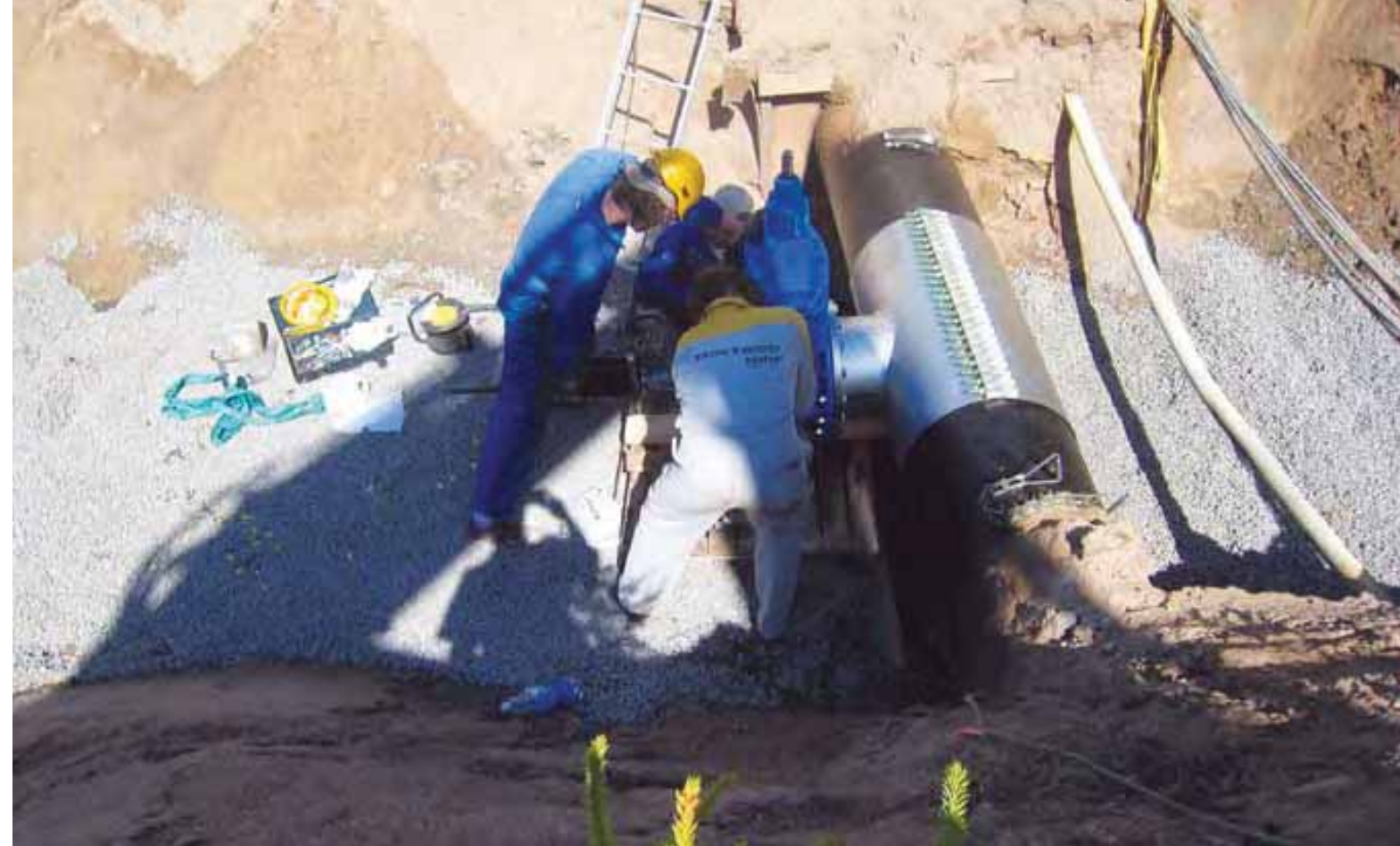
Kuvassa tehdään paineellinen haaroitus Kotkan/Anjalankosken välisessä DN600 siirtoputkessa 20.7.2009. Työstä vastasi Tonisco Systems Oy. Siirtoputki oli sisäpuolelta betonivuorattu teräsputki. Työssä käytettiin ns. haarasatulaa, joka asennettiin huolellisesti puhdistetun putken ympärille.
