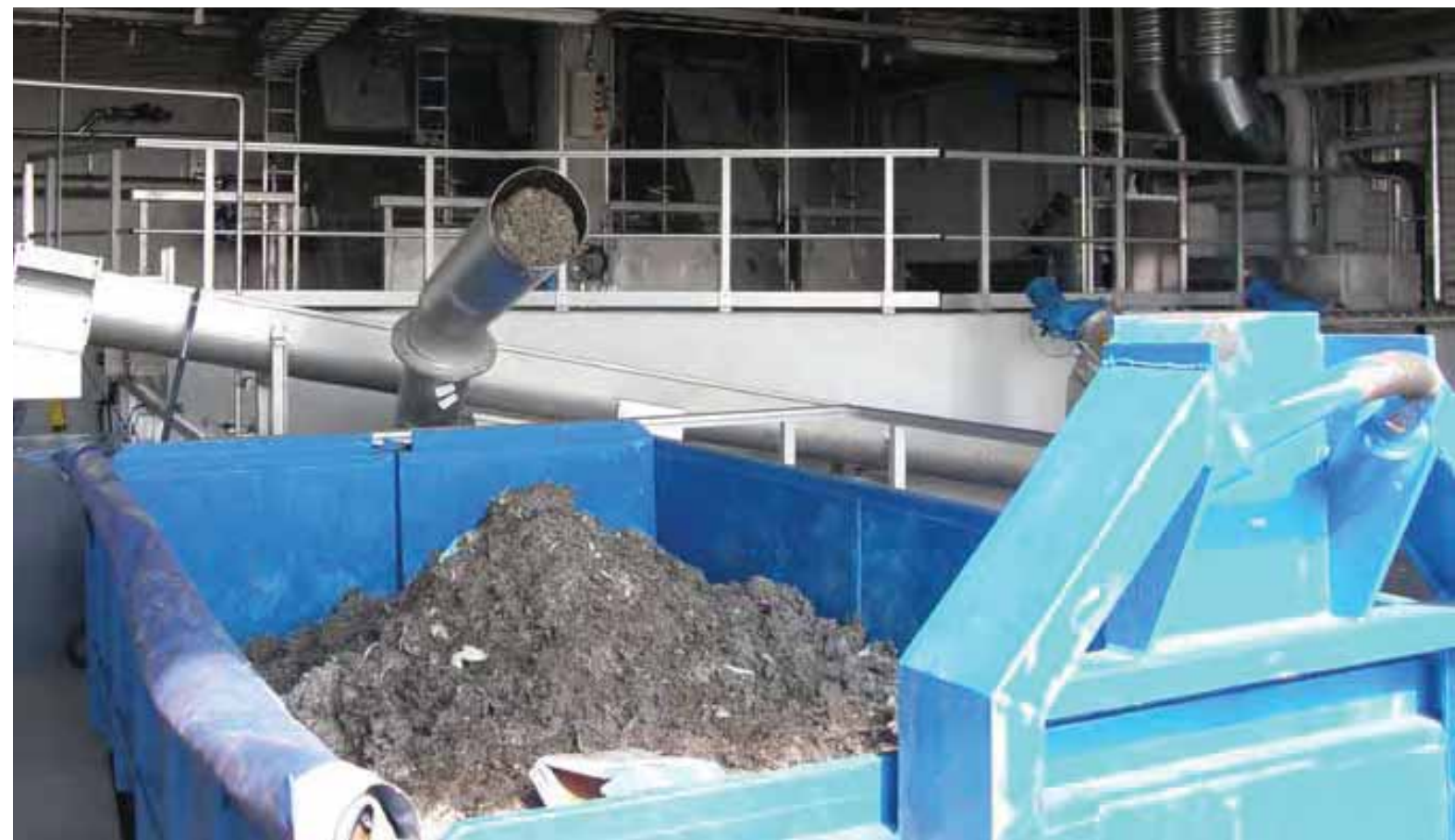
Jätevedenpuhdistaminen alkaa välppäyksellä. Ylhäällä välpät ja alakuvassa välppäjätteet. (Juuti & Rajala 2010)
