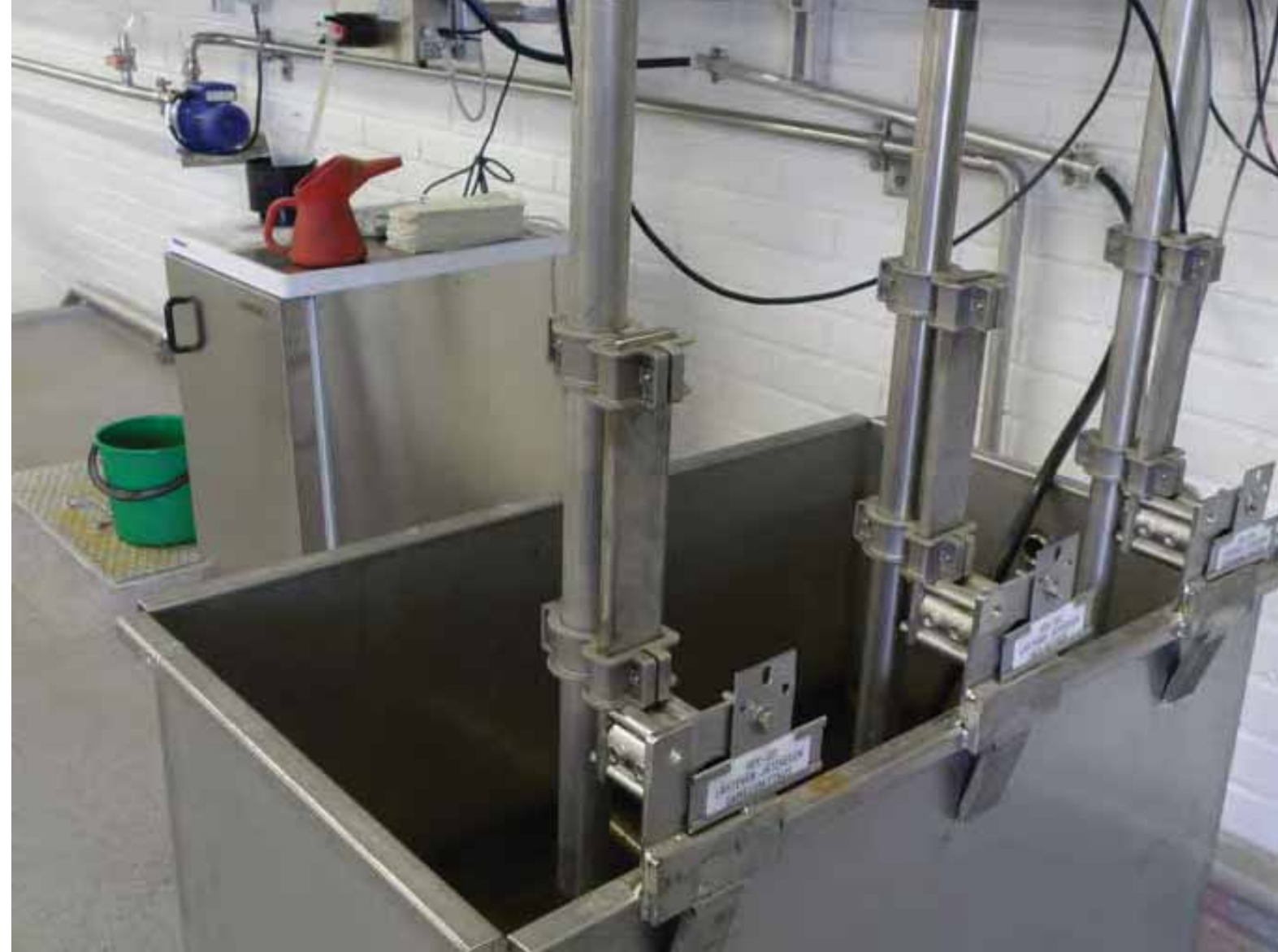
Puhdistamolta lähtevän veden sameusmittauspiste ja näkymä altailta. (Juuti & Rajala 2010)
