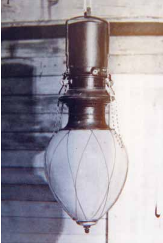
1900-luvulla käytössä ollut Kaarilamppu (Oulun kaupungin sähkölaitos 1889-1939.)
