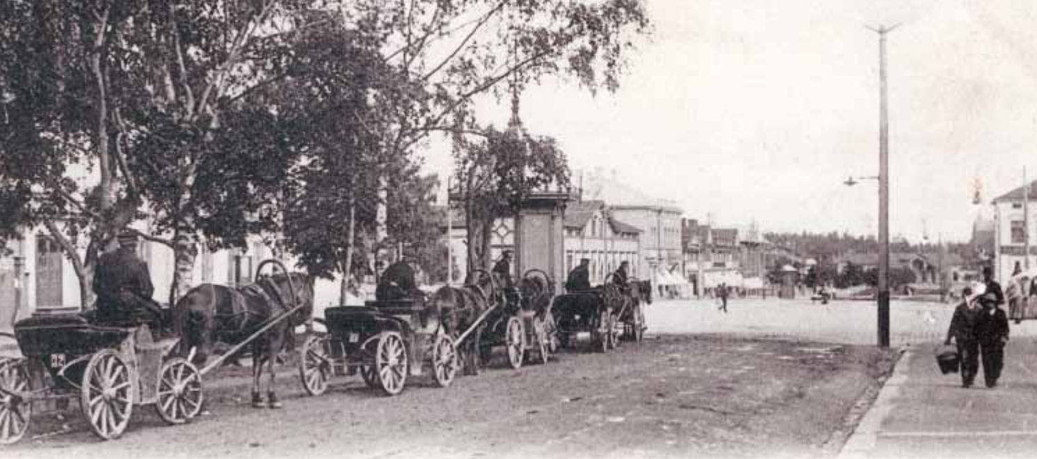
Hovioikeudenpuistikko Vaasa vuonna 1903. Huomaa valaisinpylväs oikealla ja kaivo hevosvaunujen takana. Valopylväässä on lamppu puolessavälissä ja yläpäässä paikka kahdelle johdolle. (PM)
