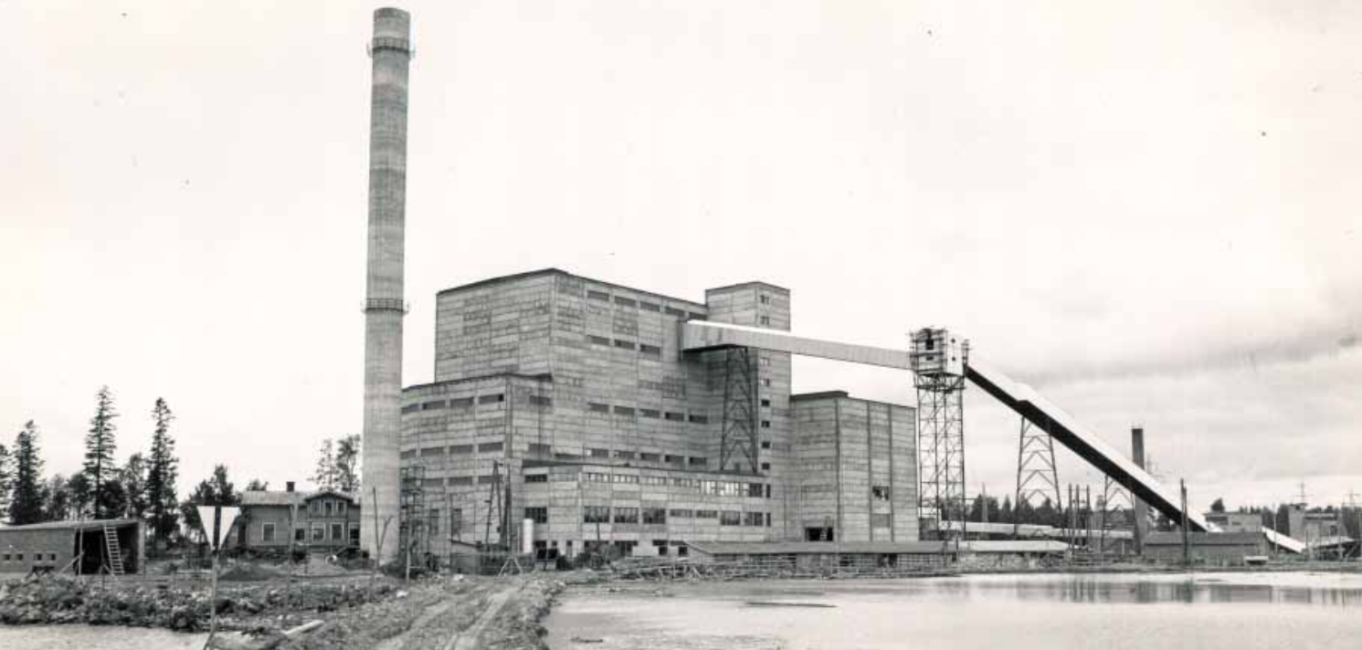
Vaskiluodon ensimmäinen voimalaitos. (Airaksinen O. 25.9.1957.)
