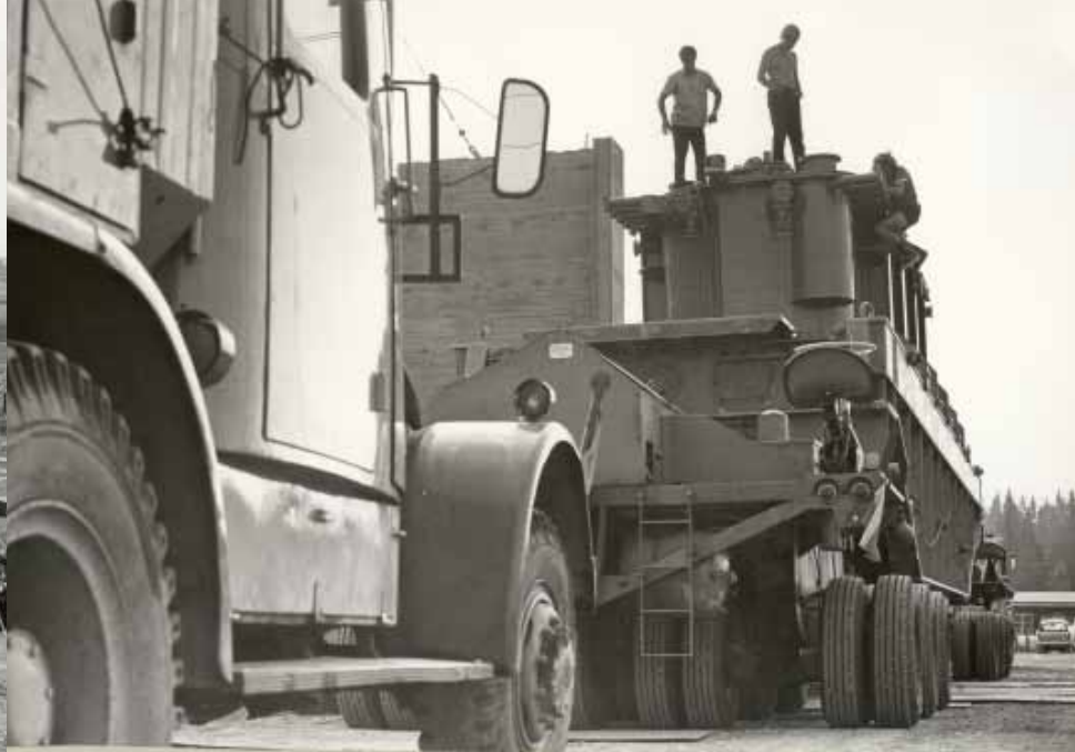
Tuovilan 220/110 kV:n muuntajan kuljetus asennuspaikalle bunkkeriin. 2.8.1971.
