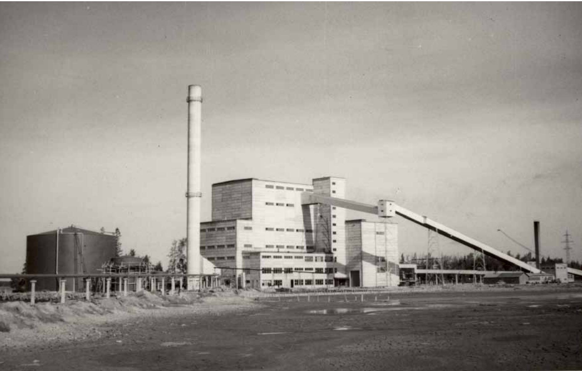
EPV:n Vaskiluodon voimalaitos vuonna 1959. (PM) Vasemmalla polttoöljysäiliöt, joista lähtee satamalaiturin päähän johtava öljyputki. Oikealla ovat hiilenkuljettimet, joiden takana lämpökeskuksen savupiippu. Rakennuksen korkeimmassa osassa on voimalaitoksen kattilahuone, jonka korkeus lattiasta kattoon on 38 metriä. (Vaasa 11.9.1958.)
