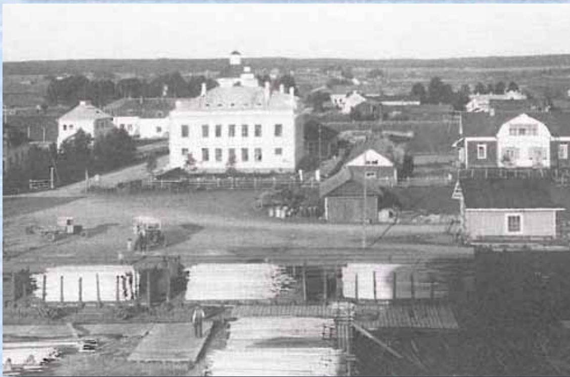
Yläkuvassa kaivon syventäjät Jyllinkosken Sähkö Oy:n konttorin pihassa noin vuonna 1925. Alakuvassa on Kurikan kirkonkylän keskustaa vuonna 1929. Etualalla Valtion rautateiden Kurikan aseman aluetta puutavaran lastauksineen. Keskellä HOP:n pankkipalatsi ja taustalla kirkko tapuleineen. (Kurikka-Seura ry/Kurikan Nuorisofilatelistien korttisarja)
