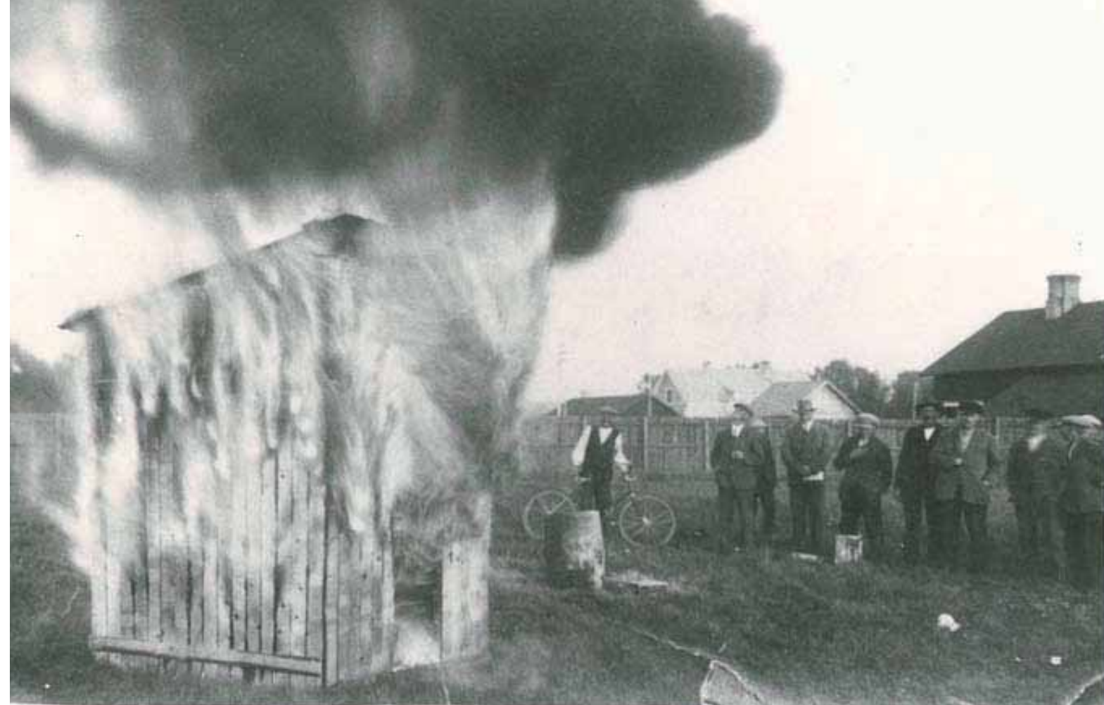
Tulipalo Kurikassa. Paikalle on saapunut useita katsojia. (KKuA)
