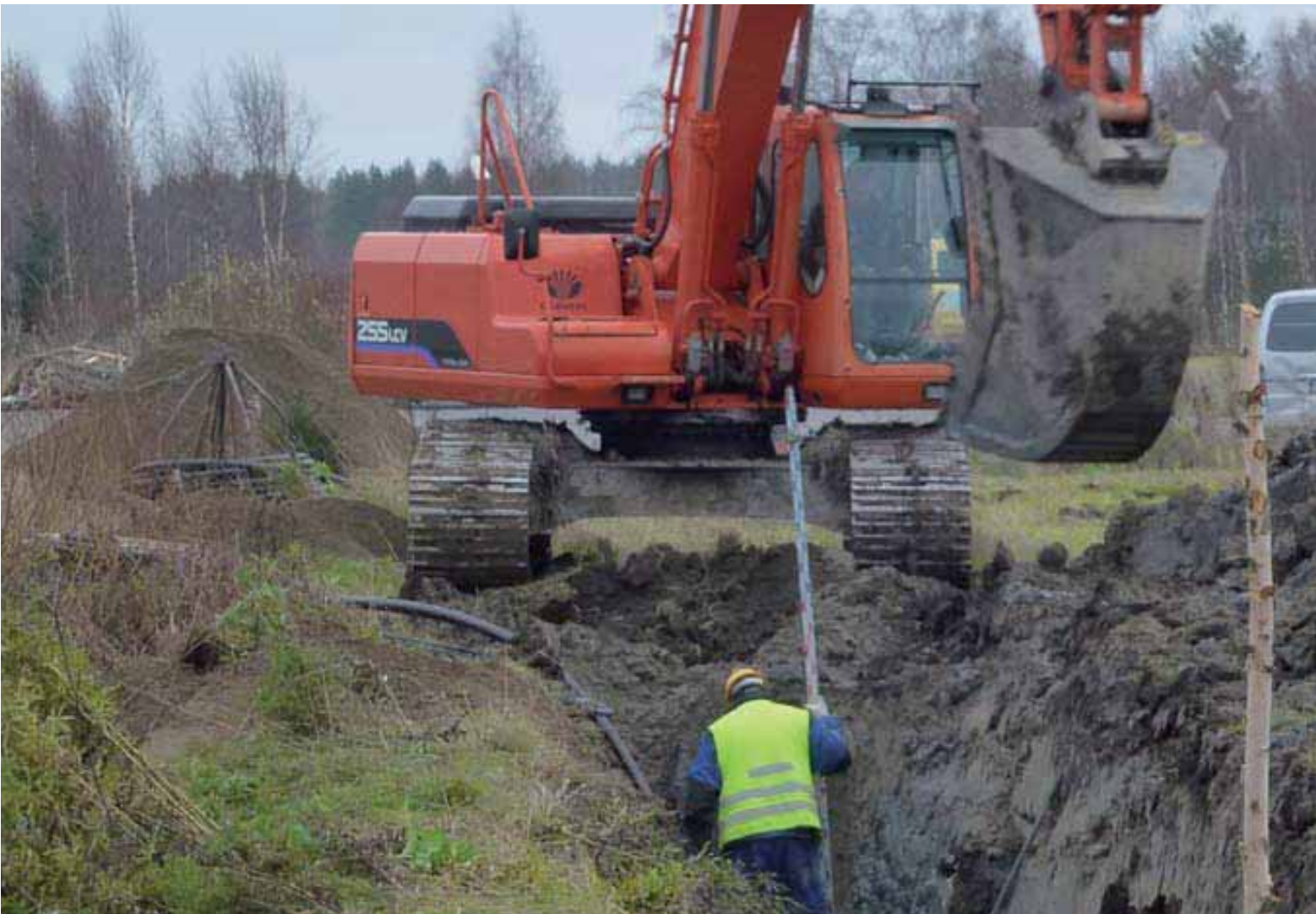
Niemenkylän jätevesiosuuskunnan rakennustyömaa lokakuussa 2011. (Rajala 2011)
