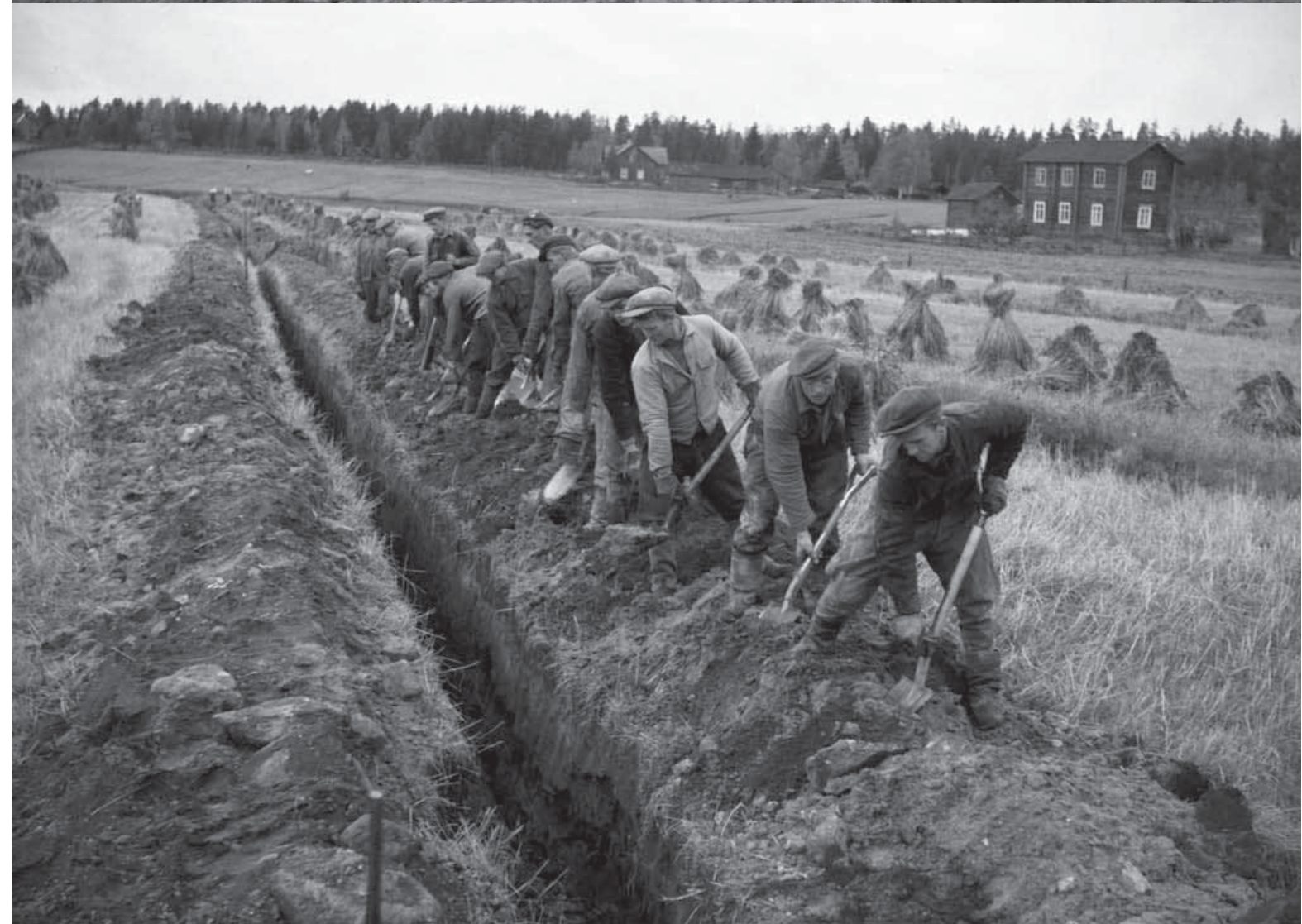
Puiset vesijohtoputket kaivettiin kökällä maahan. (Tampereen museot, Jurva 1948)
