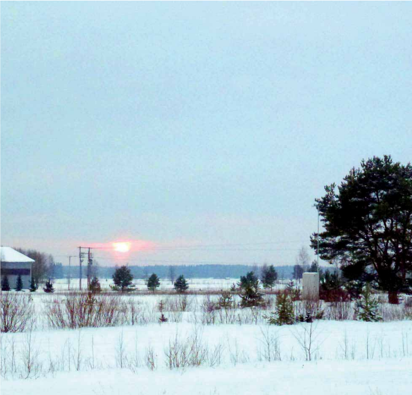
Jurvassa välimatkat ovat pitkiä, joten toimiva vesihuolto tarvitsee pumppaamoja. Jurvassa on kahdeksan jätevedenpumppaamoja. Vuosina 2009 - 2010 nämä pumppaamot varustettiin kaukovalvonnalla. Kuvassa jätevesipumppaamo Jurvan Koskimäessä. (Juuti 2011)
