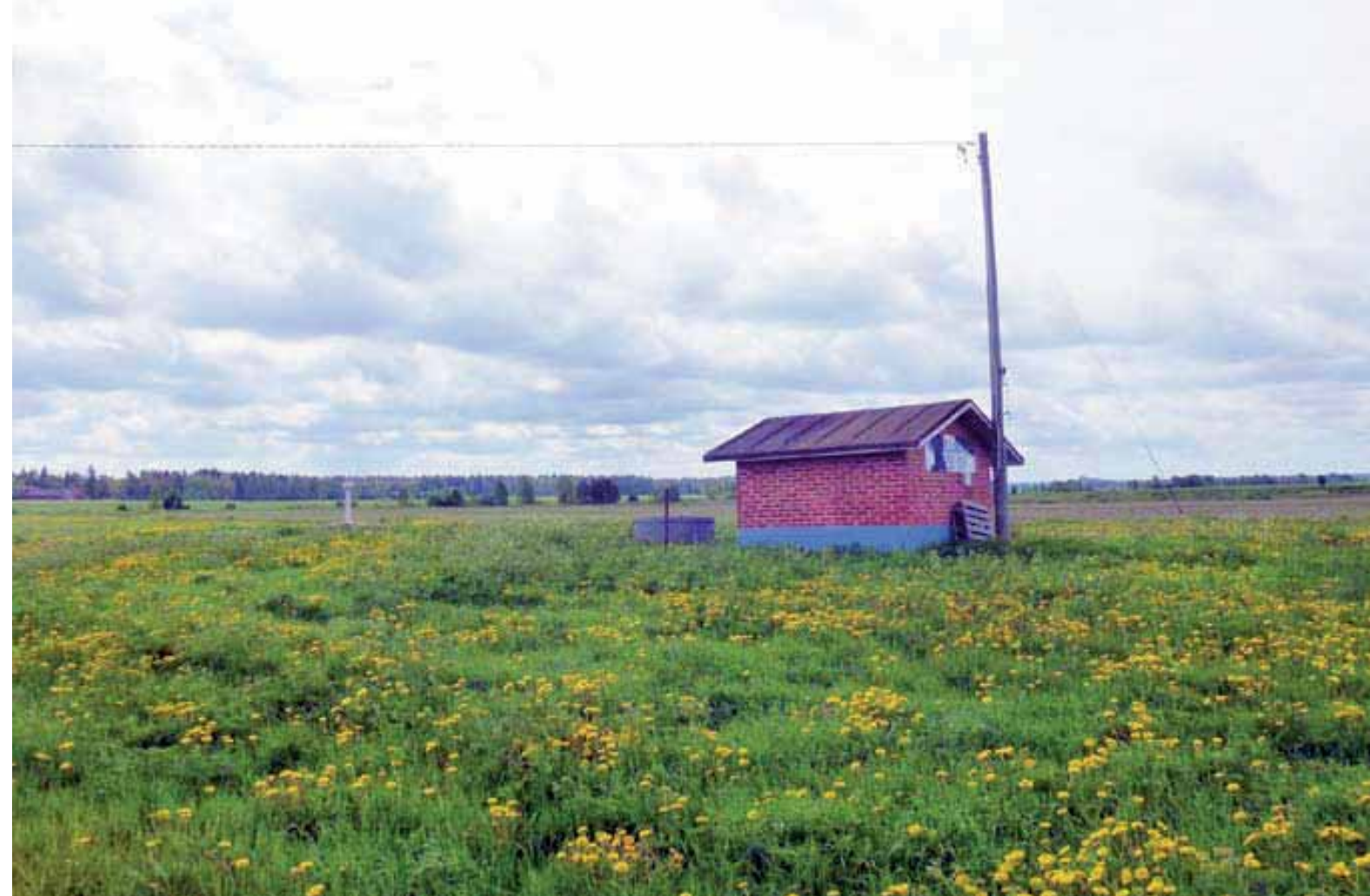
Myötämäen Vesi Oy:n vedenottamo. (Juuti & Rajala 2012)
